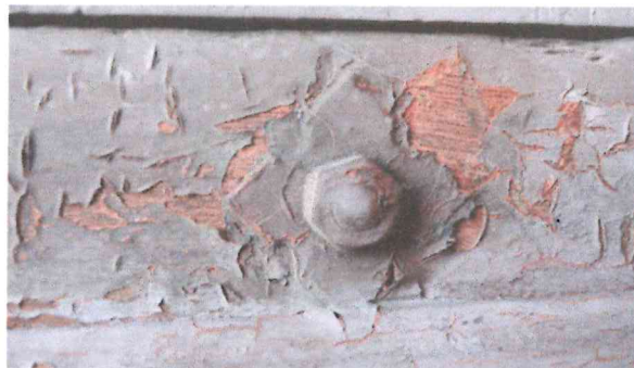
Il. 18 Kętrzyn, stolarka drzwiowa- elewacja frontowa, zbliżenie na detal- stan przed konserwacją: widoczne łuszczenie farby. Fot. B. Kwasiborska, 2022 r.
