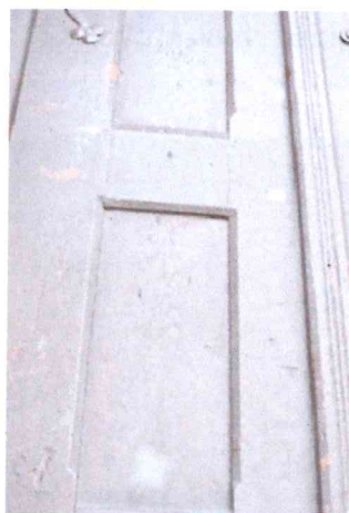
Il. 16 Kętrzyn, stolarka drzwiowa- elewacja tylna, zbliżenie na detal- stan przed konserwacją: widoczne szczeliny między płyciną a ramiakiem. Fot. B. Kwasiborska, 2022 r.
