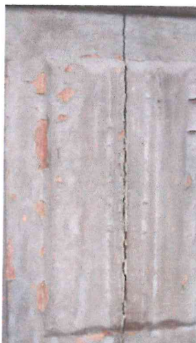
Il. 15 Kętrzyn, stolarka drzwiowa- elewacja frontowa, zbliżenie na detal- stan przed konserwacją: widoczne pęknięcie płyciny. Fot. B. Kwasiborska, 2022 r.
