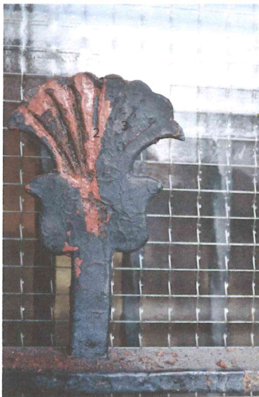
Odkrywka nr 4- drzwi główne, elewacja frontowa- 0. Metal, nawarstwienia późniejsze 1. warstwa malarska- brązowo- czerwony 3. warstwa malarska- grafitowy
