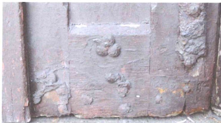
Il. 19 Kętrzyn, stolarka drzwiowa- elewacja tylna, zbliżenie na detal- stan przed konserwacją: widoczny brak kutego detalu. Fot. B. Kwasiborska, 2022 r.
