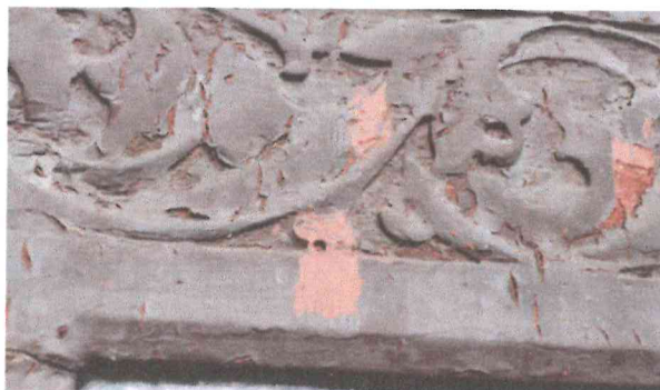
Il. 17 Kętrzyn, stolarka drzwiowa- elewacja frontowa, zbliżenie na detal- stan przed konserwacją: widoczne wtórne przemalowania oraz uszkodzenia detali snycerskich. Fot. B. Kwasiborska, 2022 r.
