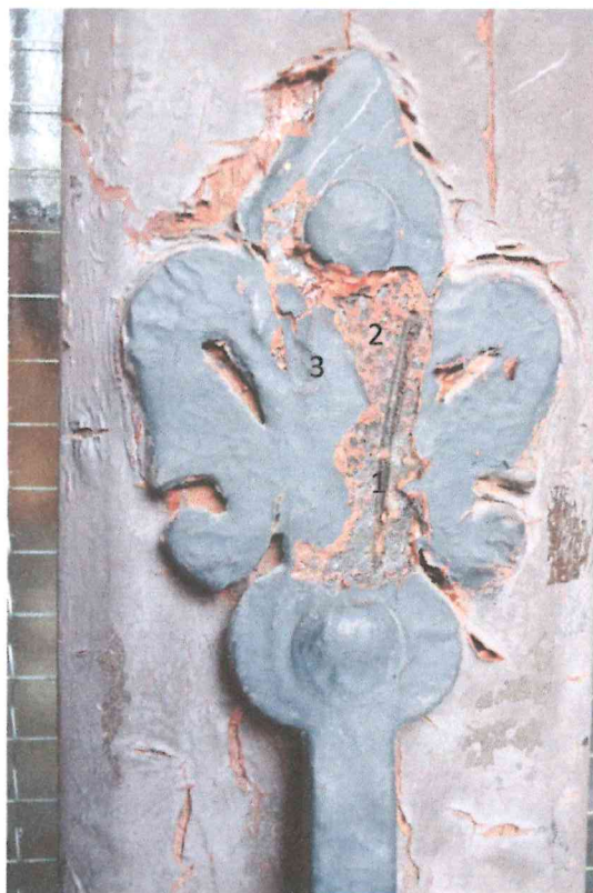
Odkrywka nr 3- drzwi główne, elewacja frontowa- 0. Metal, nawarstwienia późniejsze 1. warstwa malarska- brązowo- czerwony 3. warstwa malarska- grafitowy ciemny
