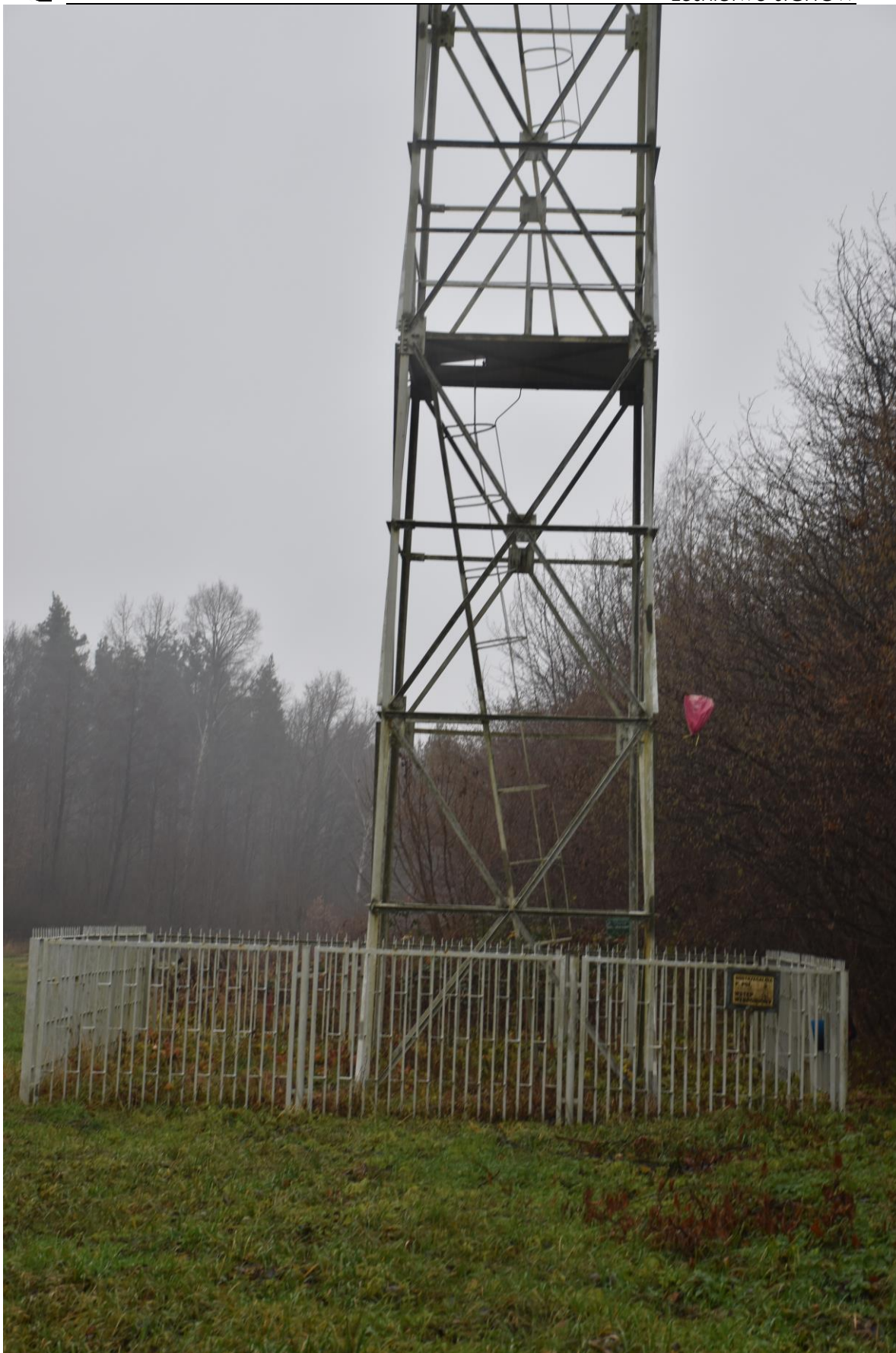
Rys. 2a. Podstawa wieży.
