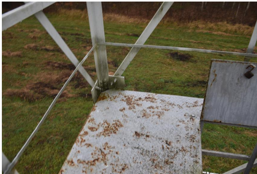
Rys.4a. Istotnych objawów korozji nie stwierdzono (nie licząc punktowych ognisk korozji).
