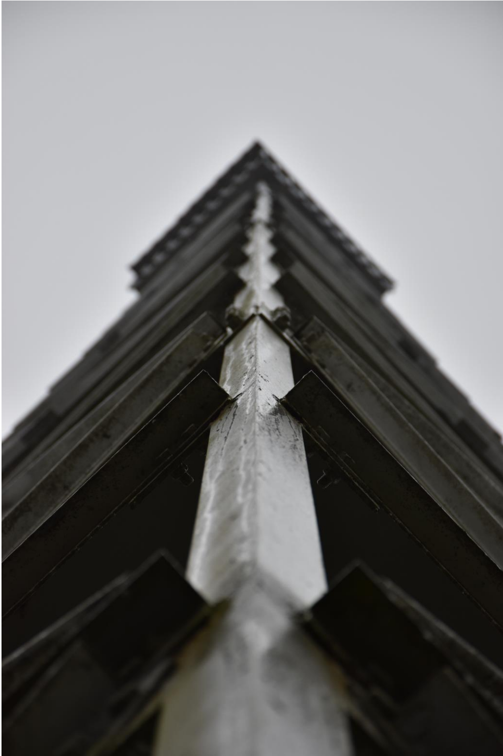
Rys.4c. Widok geometrii krawężników wieży ( nie stwierdzono istotnych odchyłek od prostoliniowości krawężników ).
