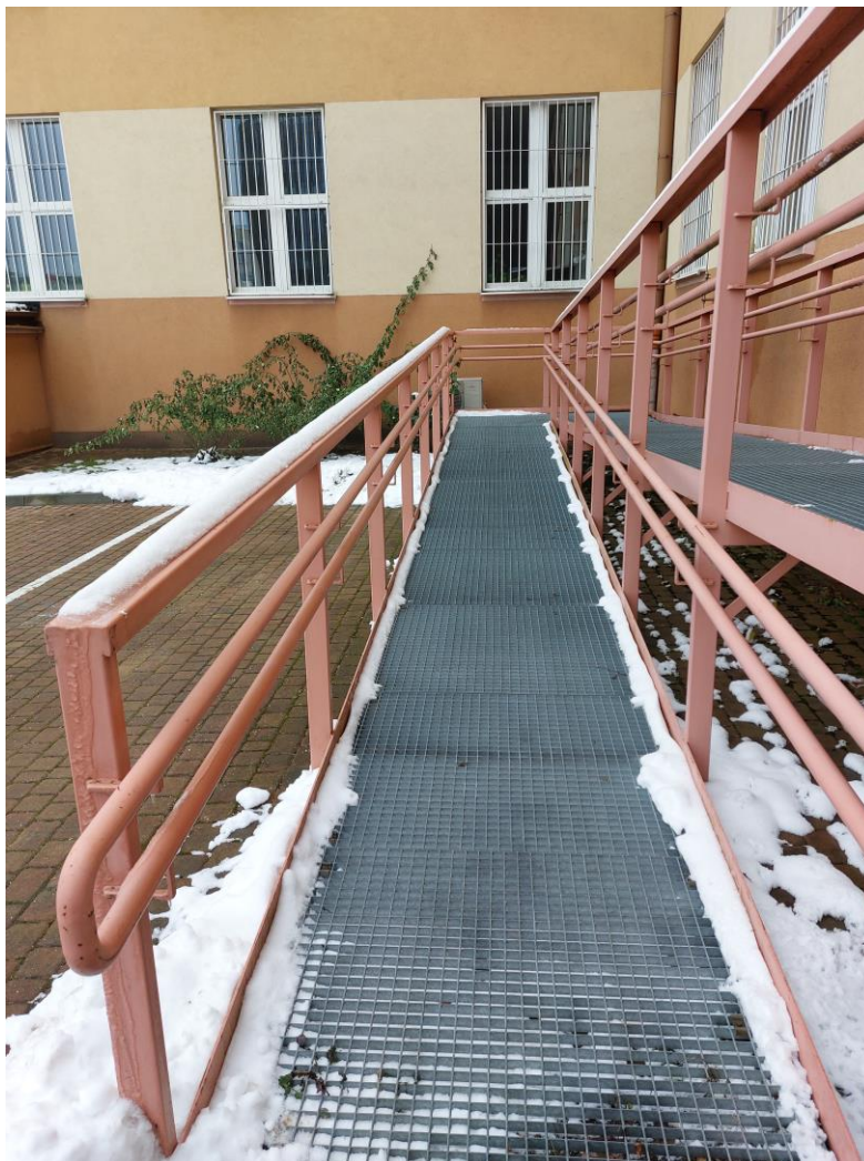
Zdj. 7. Pochylnia przy budynku Wydziału Filozoficzno-Historycznego Uniwersytetu Łódzkiego
