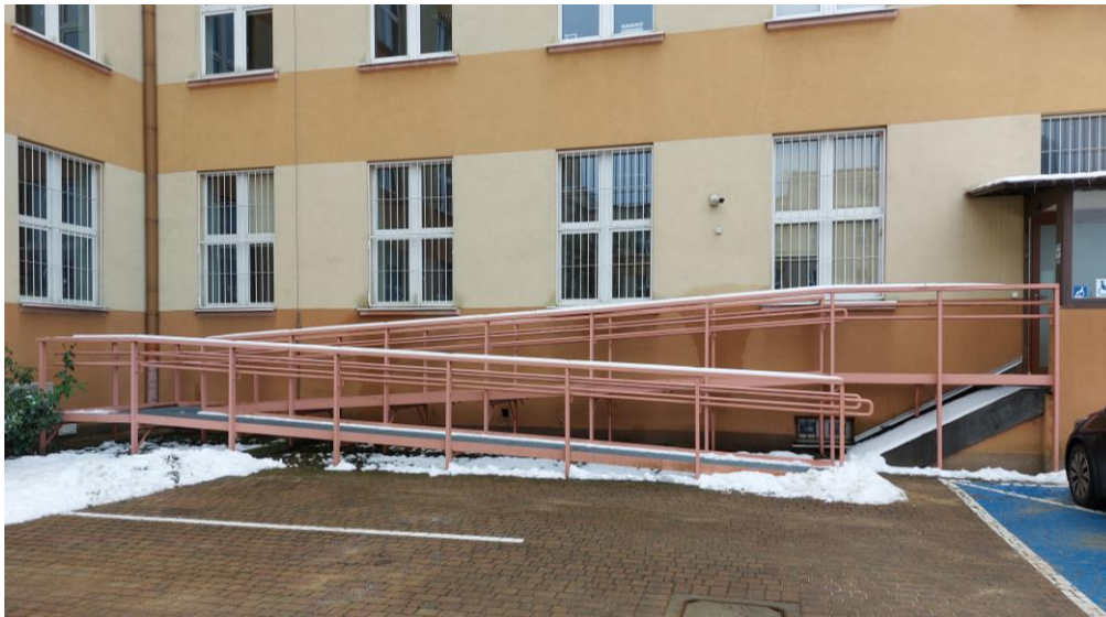
Zdj. 6. Pochylnia przy budynku Wydziału Filozoficzno-Historycznego Uniwersytetu Łódzkiego
