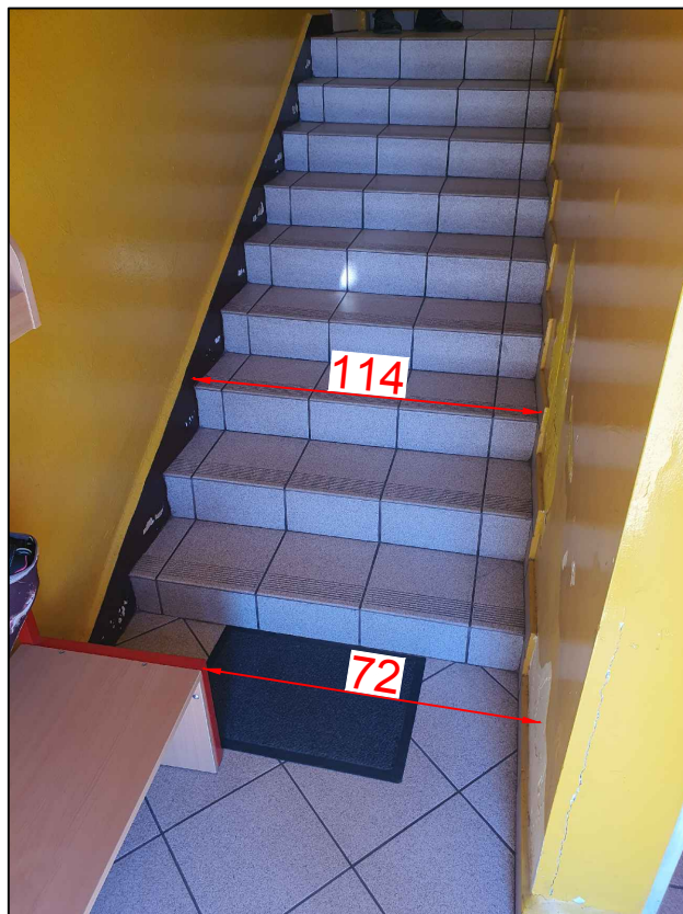
FOT. 1 Zawężona szerokość biegu na parter w klatce schodowej K2
