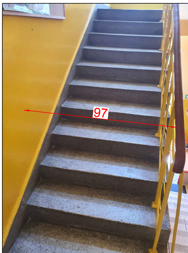
FOT. 2 Zawężona szerokość biegu na piętro w klatce schodowej K2
