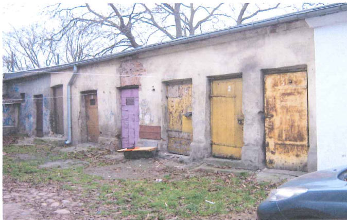
Widok komórek murowanych w granicy południowej. Podlegać będą przebudowie.
