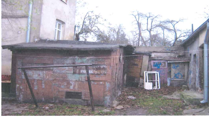
Widok komórek w granicy wschodniej. Podlegać będą rozbiórce.
