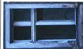
Zbliżenie – stare i wymienione okno
