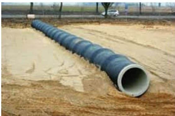
Fot. 6. Zmontowana część przelotowa przepustu
