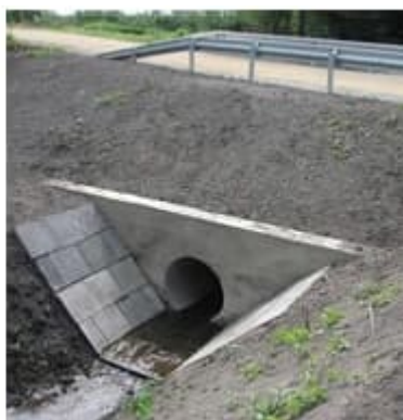
Fot. 8. Przykłady umocnienia skarp i dna rowu w sąsiedztwie wylotu przepustu
