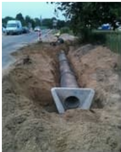
Fot. 7. Przepust z zamontowanym elementem wylotu
