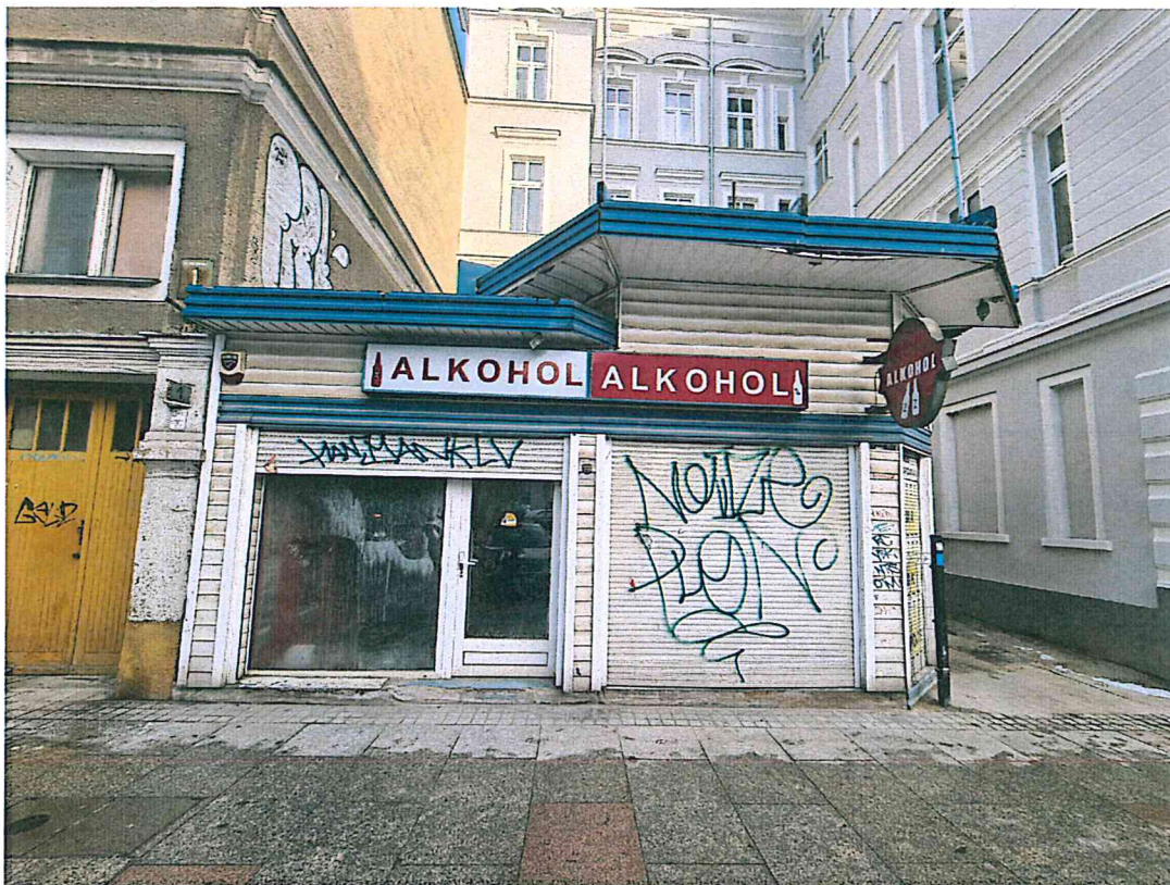
ZDJĘCIE NR1. ELEWACJA FRONTOWA I SZCZYTOWA
