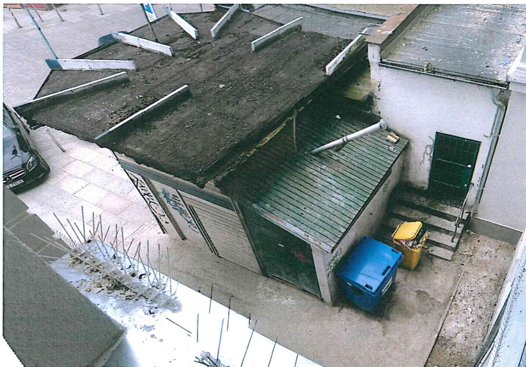
ZDJĘCIE NR4. DACH I ELEWACJE TYLNE
