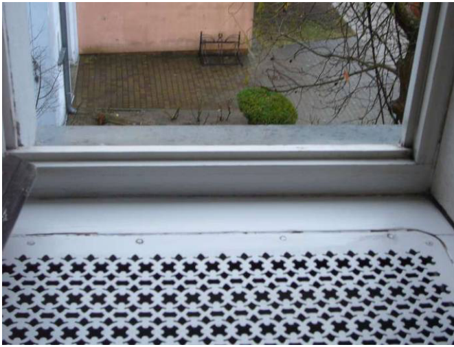
Istn. okno O2a - widok od wewnątrz-oryginalna kratka nawiewna stalowa (pom. nr 2.3 - pom. gospodarcze)
