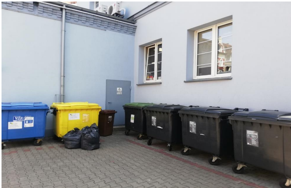
Zdj. 3. Budynek trafostacji przy budynku Starostwa z drzwiami bez odporności ogniowej usytuowanymi przy oknach pomieszczeń biurowych. Pojemniki z tworzywa na odpady bezpośrednio pod oknami.
