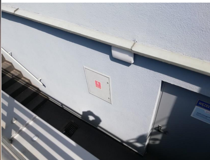
Zdj. 16. Miejsce usytuowania przeciwpożarowego wyłącznika prądu
