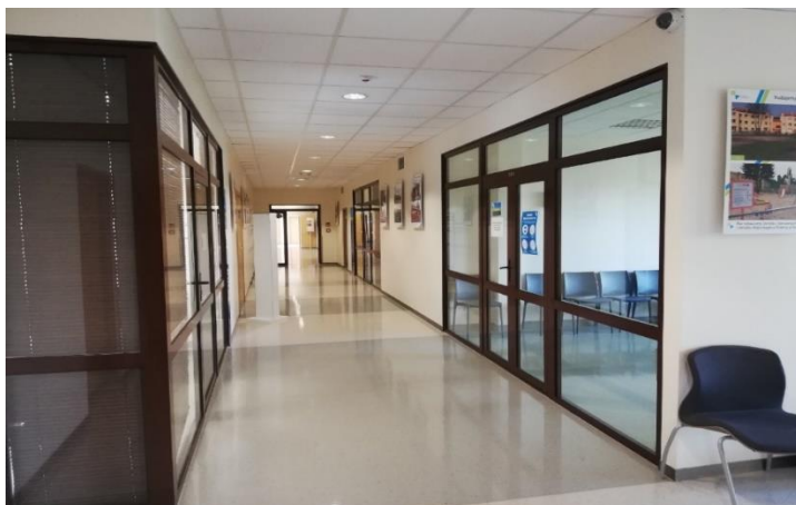
Zdj. 13. Korytarz w kierunku klatki B – przeszklenia stanowiące obudowę poziomej drogi ewakuacji
