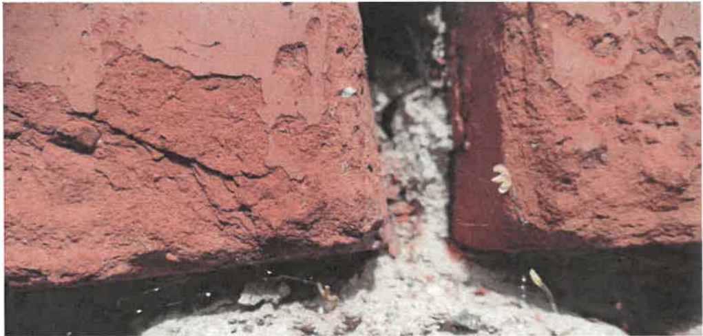
17. Fragmentarycznie zachowana, mocno osłabiona historyczna spoina. Cokół elewacji południowej.
