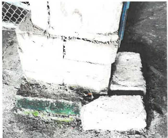
28. Zarośnięty mchem i glonami wewnętrzny kanał w posadzce piwnicy.
