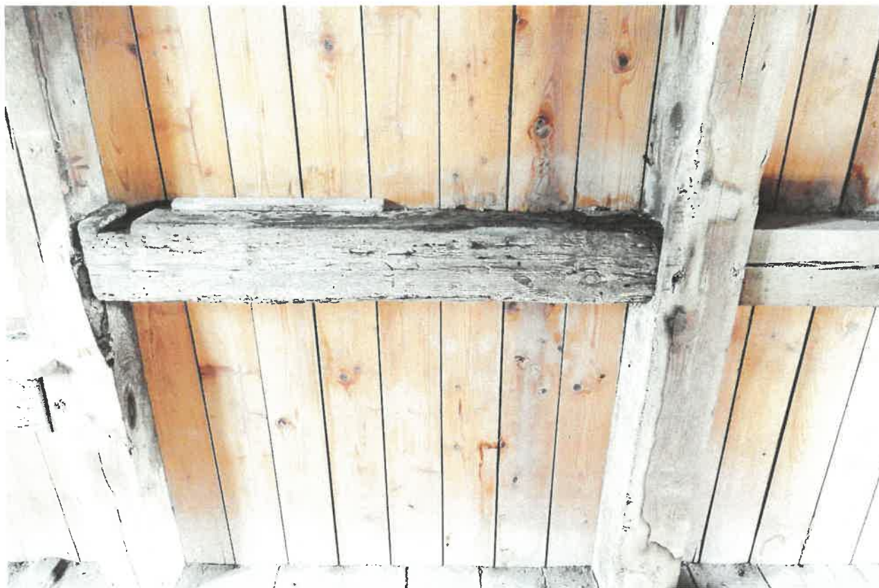
19. Oryginalna belka konstrukcji rygła obudowana współczesnym materiałem.
