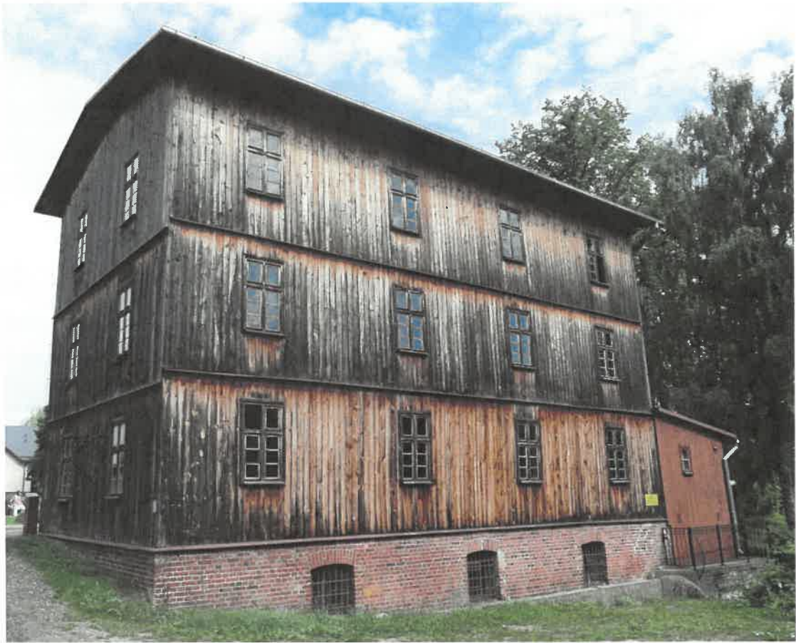
11. Elewacja południowa z widocznymi zabytkowymi kratami w oknach ceglano cokołu.
