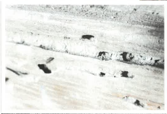
22. Uszkodzone historyczne deskowanie podłogi we wnętrzu budynku.
