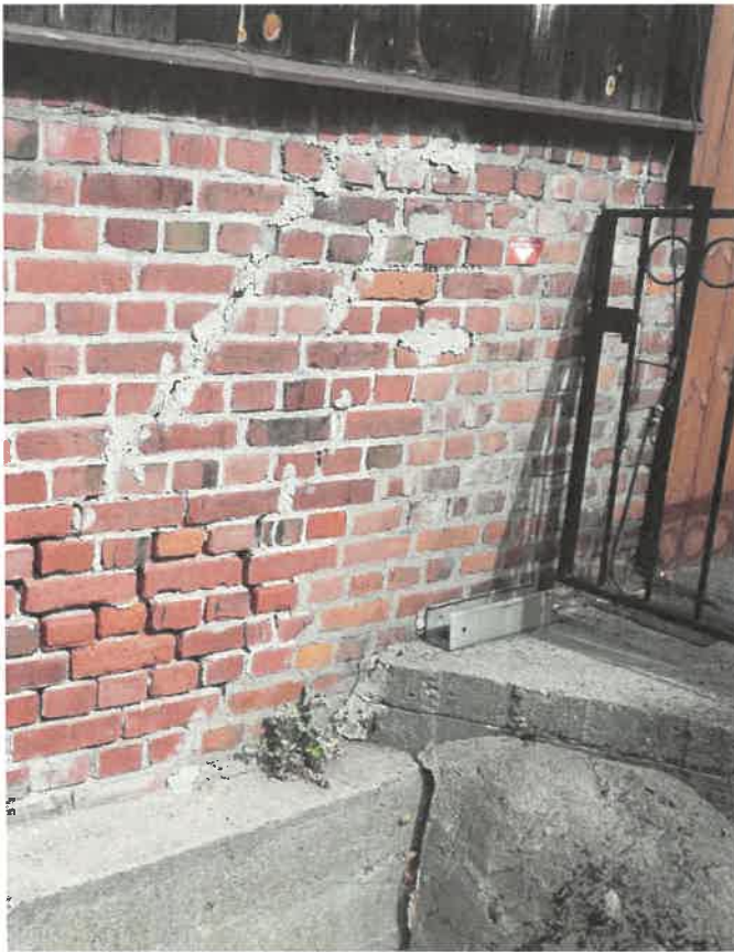
16. Oryginalne, zniszczone cegły i wykruszona spoina pod którą widoczna jest pierwotna zaprawa murarska
