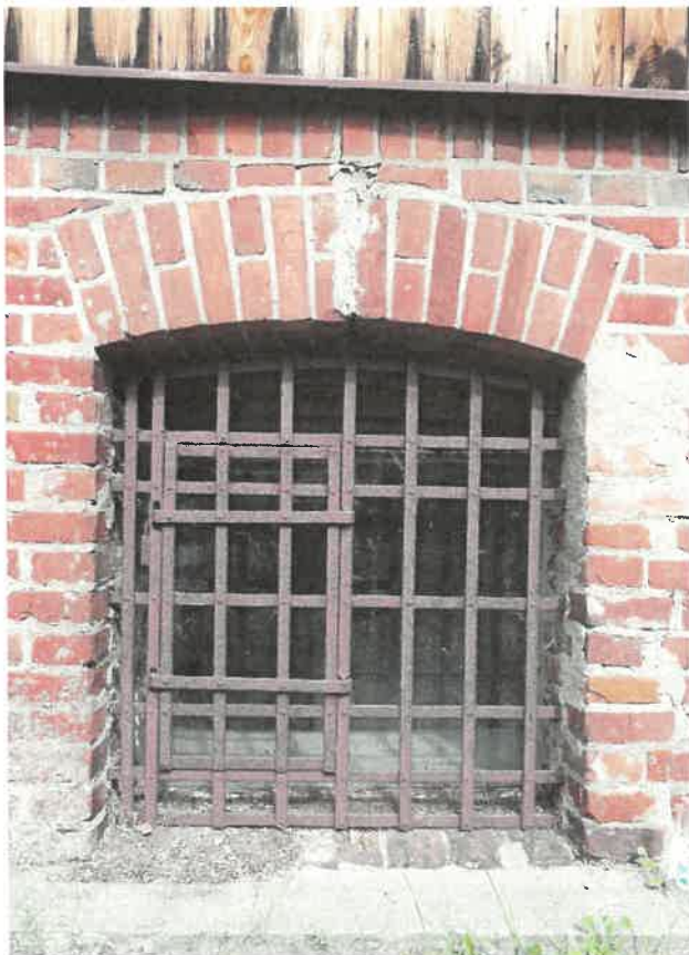
12 i 13. Zbliżenie na zabytkowe kraty i sposób wtórnego montażu/remontu w węgarach okiennych.
