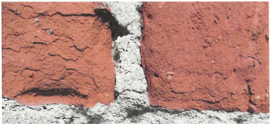
17. Fragmentarycznie zachowana, mocno osłabiona historyczna spoina. Cokół elewacji południowej.
