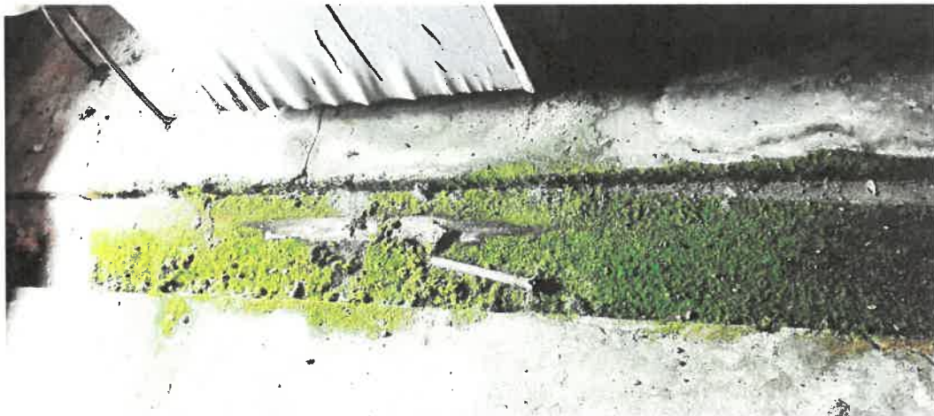
28. Zarośnięty mchem i glonami wewnętrzny kanał w posadzce piwnicy.
