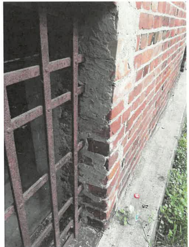
12 i 13. Zbliżenie na zabytkowe kraty i sposób wtórnego montażu/remontu w węgarach okiennych.
