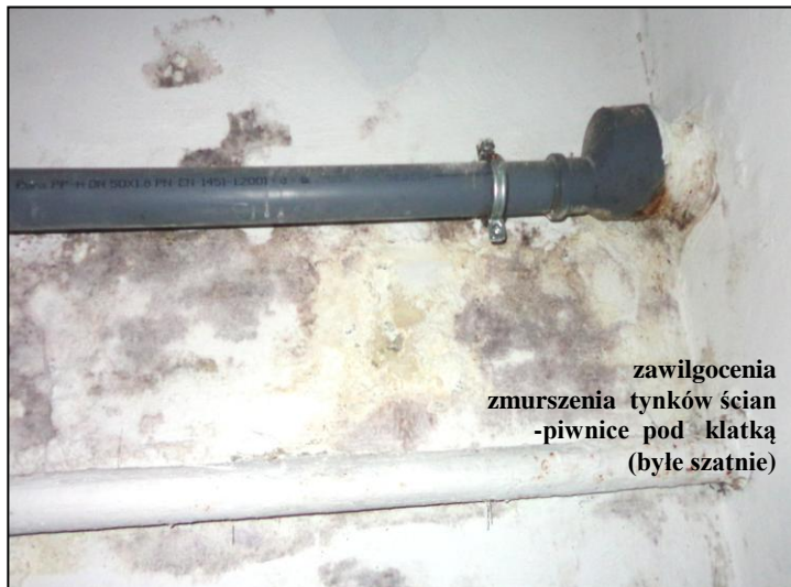
zawilgocenia zmuśrzenia tynków ścian i stropu (pomieszczenie konserwatora)
