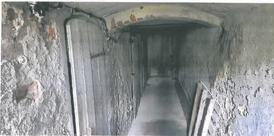
Foto. 15 Zdjęcie wykonane podczas kontroli pomieszczeń piwnicznych pod budynkiem starej szkoły.
