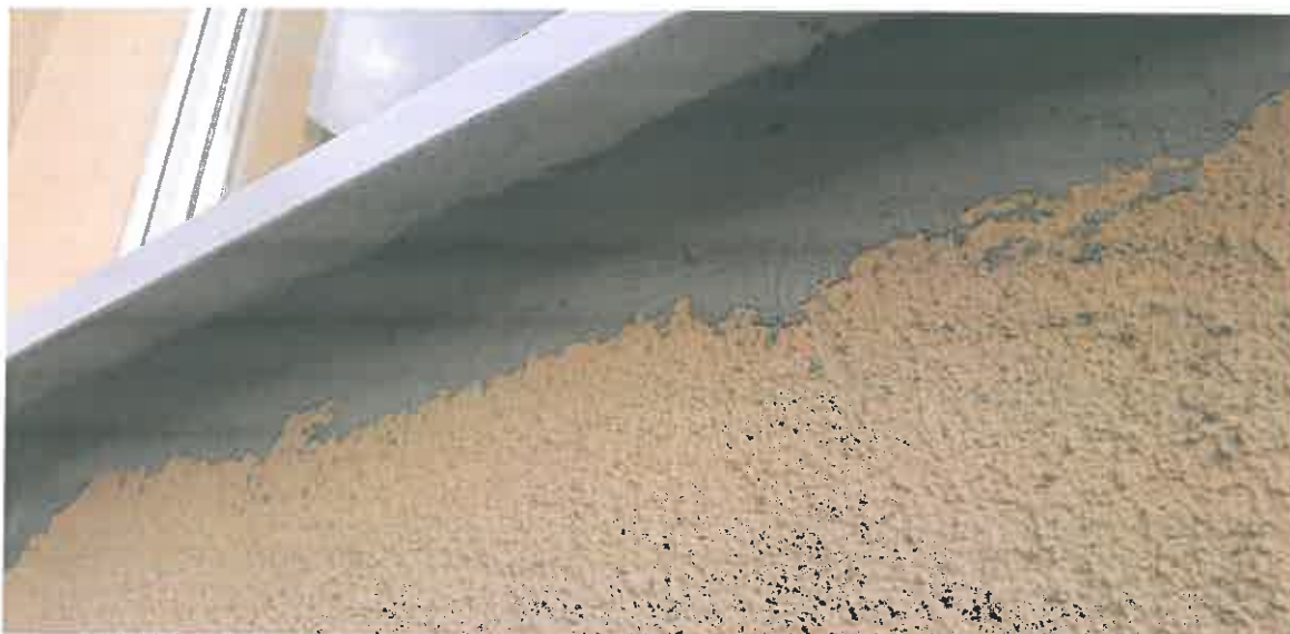
Fot. 5. W trakcie kontroli sprawdzono również wszystkie szczeliny pod parapetami okien. Były one dobrze zabezpieczone i nie stanowiły miejsc potencjalnego gniazdowania ptaków.
