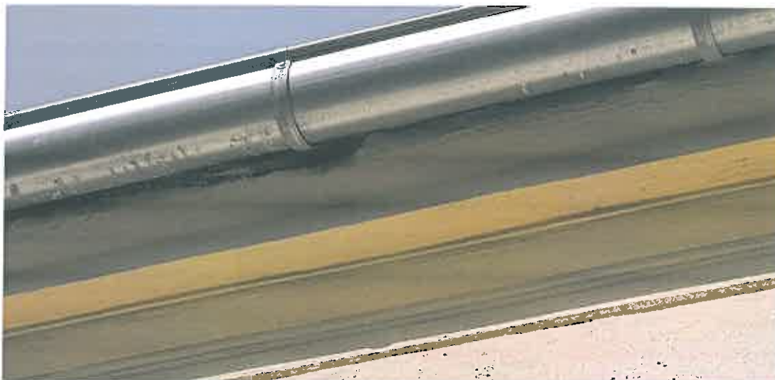
Fot. 9. Zdjęcie pokazujące przykładową jedną z szczelin zajętych przez wróble na południowej elewacji budynku.
