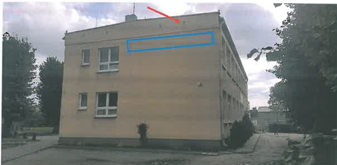
Fot. 2. Widok na elewację północną inwentaryzowanego budynku. Czerwoną strzałką zaznaczono miejsce gniazdowania wróbli. Niebieska ramka wyznacza przestrzeń w której preferuje się montaż skrzynek lęgowych.
