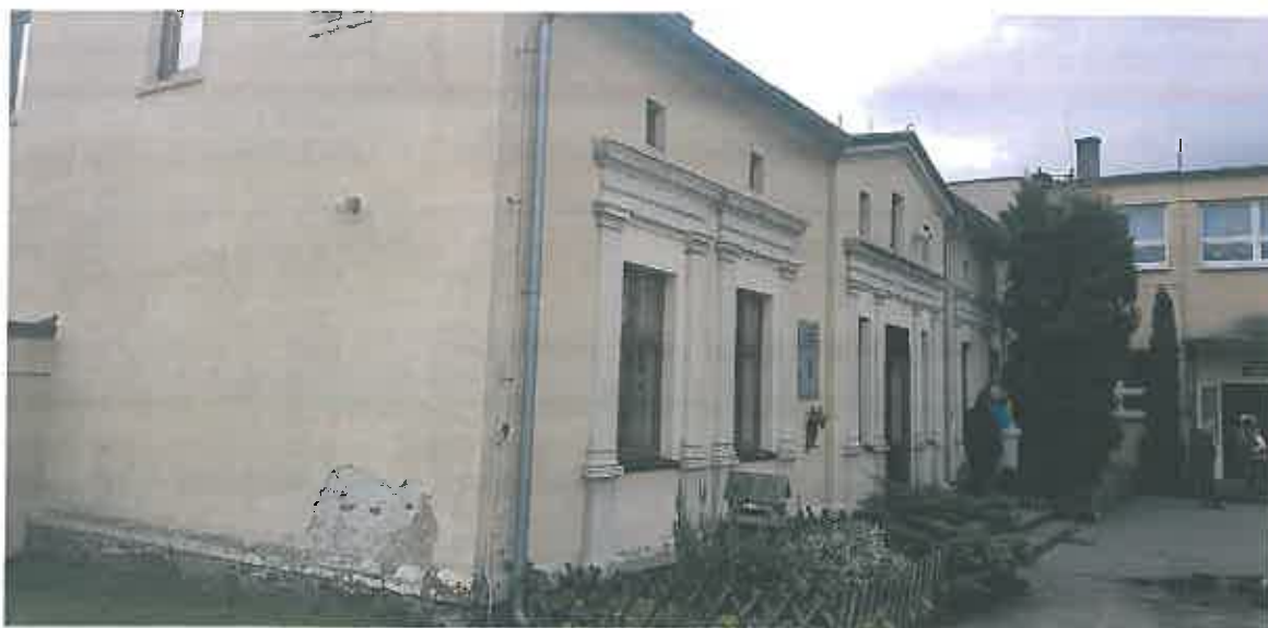
Fot. 6. Widok na północną elewację inwentaryzowanego budynku starej szkoły.
