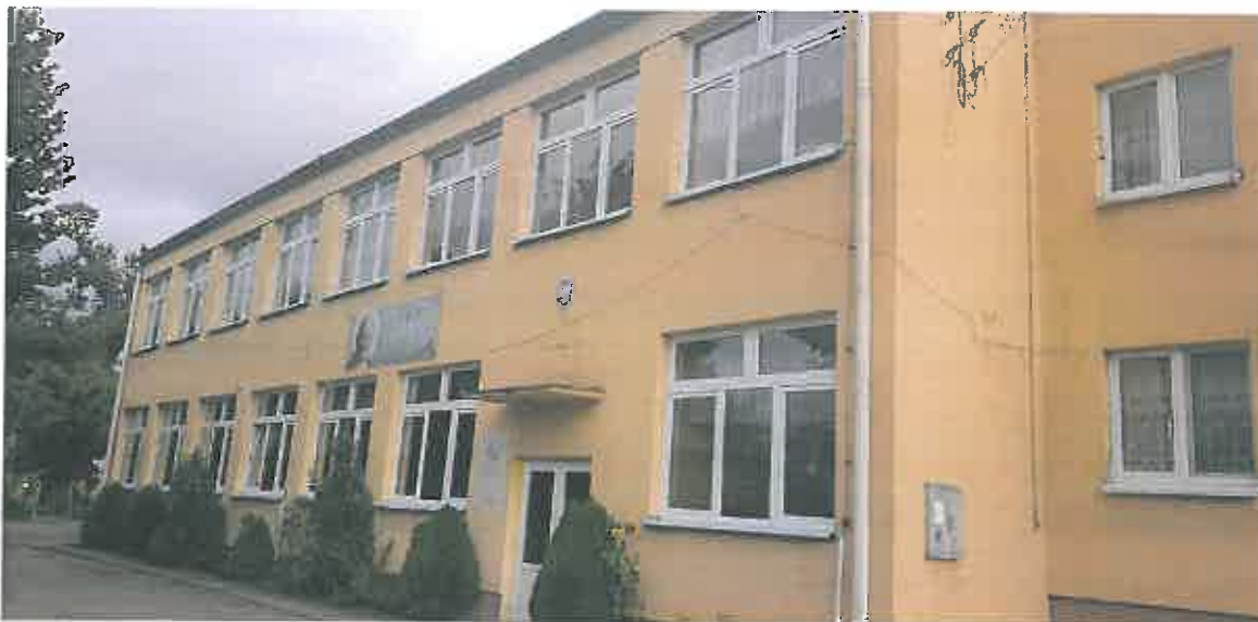
Fot. 1. Widok na elewację zachodnią kontrolowanego budynku nowej szkoły.
