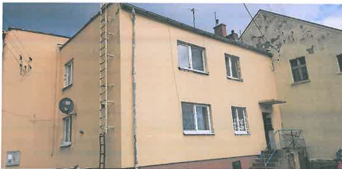
Fot. 10. Widok na budynek mieszkalny znajdujący się na połączeniu dwóch obiektów. Obiekt ten nie jest objęty opracowaniem.
