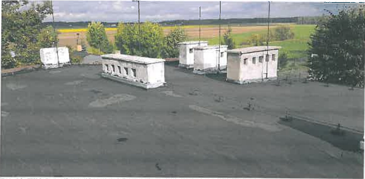
Fot. 11. Widok na skontrolowaną przestrzeń dachu budynku nowej szkoły.
