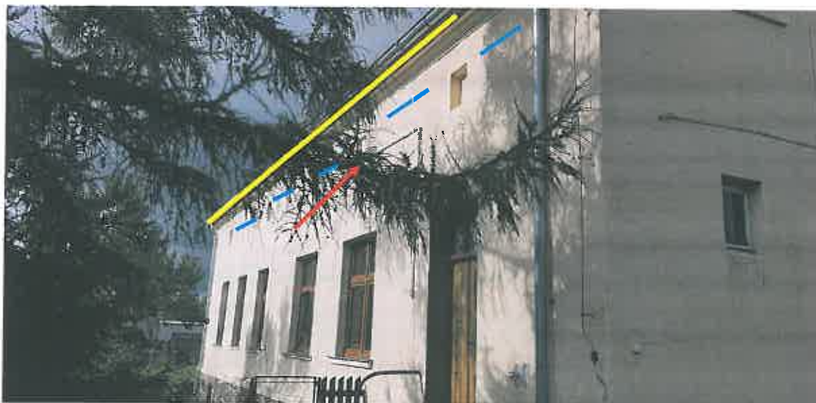
Fot. 8. Widok na południową elewację inwentaryzowanego budynku starej szkoły. Żółtą linią wskazano miejsce, gdzie stwierdzono przestrzeń zajętą łącznie przez 12 par wróbla zwyczajnego. Niebieskie linie wyznaczają przestrzeń gdzie preferuje się montaż skrzynek lęgowych.
