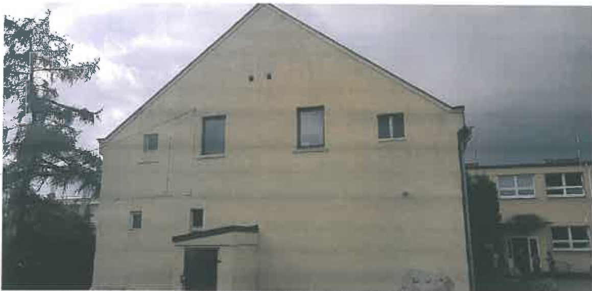
Fot. 7. Widok na wschodnią elewację inwentaryzowanego budynku starej szkoły.
