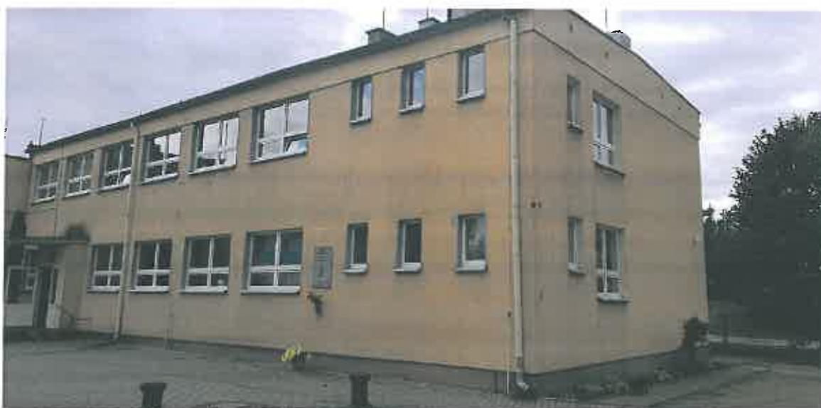
Fot. 4. Widok na północną i wschodnią elewację inwentaryzowanego budynku nowej szkoły.
