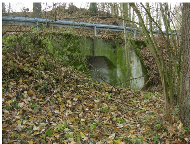
Fot. 2. Widok mostu od strony dolnej wody.
