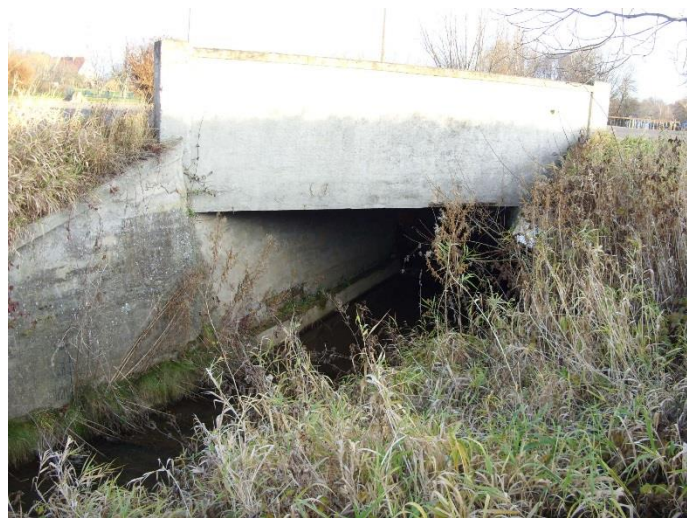
Fot. 1. Widok mostu od strony górnej wody.
