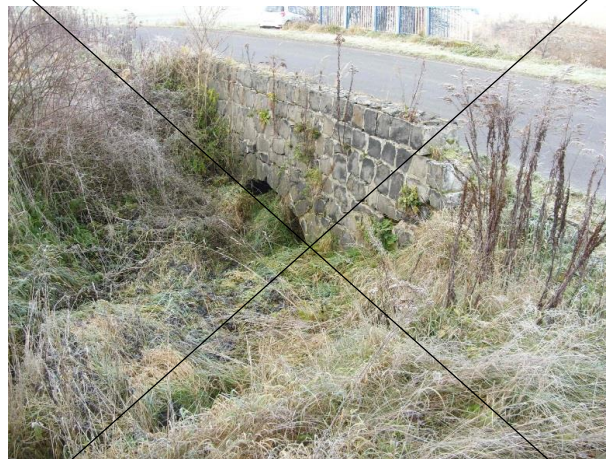
Fot. 2. Widok mostu od strony górnej wody.
