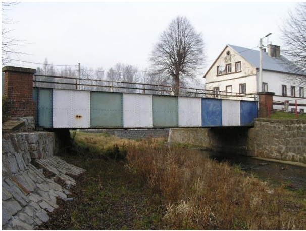
Fot. 1. Widok mostu od strony górnej wody.
