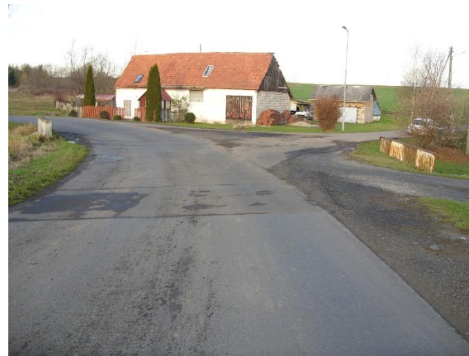
Fot. 4. Widok mostu od strony m. Gościszów.
