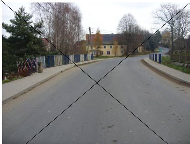
Fot. 4. Widok mostu od strony m. Lubań.
