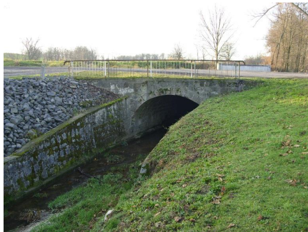
Fot. 2. Widok mostu od strony dolnej wody.
