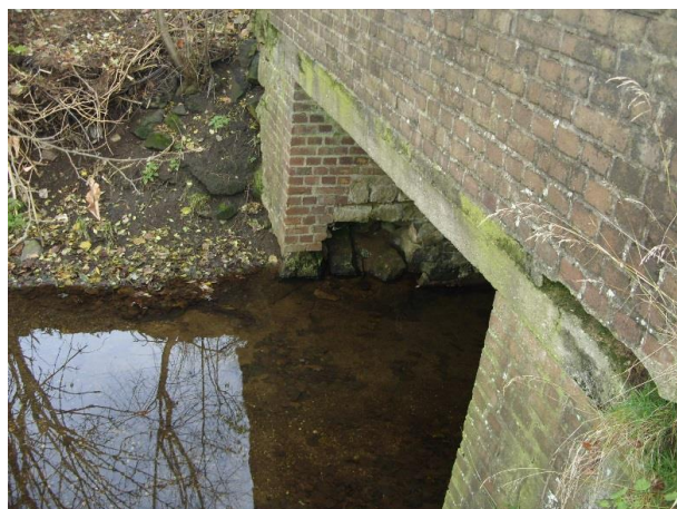
Fot. 2. Widok mostu od strony dolnej wody.
