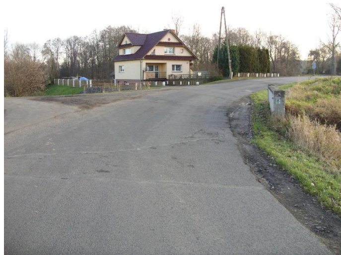
Fot. 3. Widok mostu od strony m. Męciszów.
