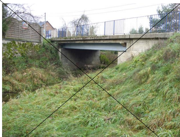
Fot. 2. Widok mostu od strony górnej wody.
