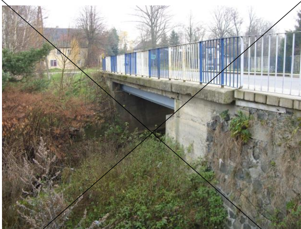
Fot. 1. Widok mostu od strony dolnej wody.
