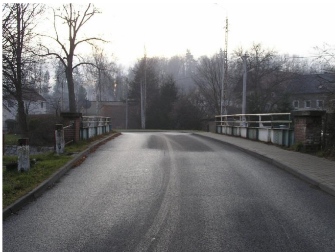
Fot. 3. Widok mostu od strony centrum m. Leśna.
