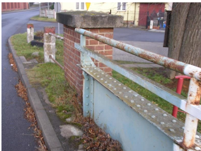
Fot. 7. Widoczne zanieczyszczenia i wegetacja roślinności na chodniku przy środku dźwigara głównego. Widoczne ubytki powłok antykorozyjnych oraz korozja powierzchniowa na elementach balustrady stalowej.
