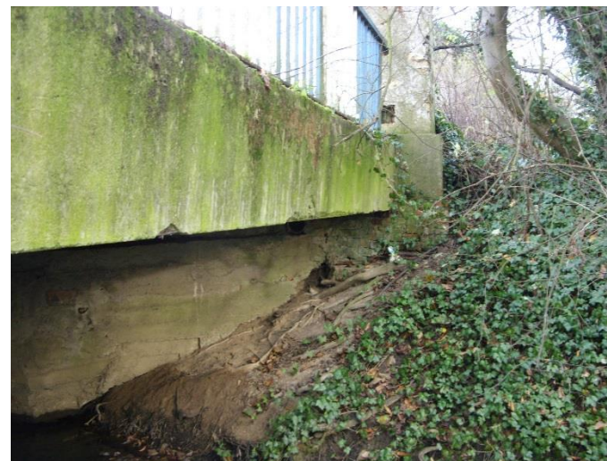
Fot. 8. Widoczne zanieczyszczenia na gzymsie.
