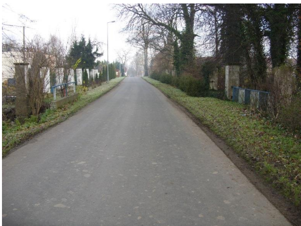
Fot. 3. Widok mostu od strony m. Lubań.
