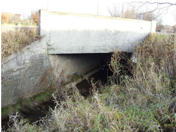
Fot. 1. Widok mostu od strony górnej wody.
