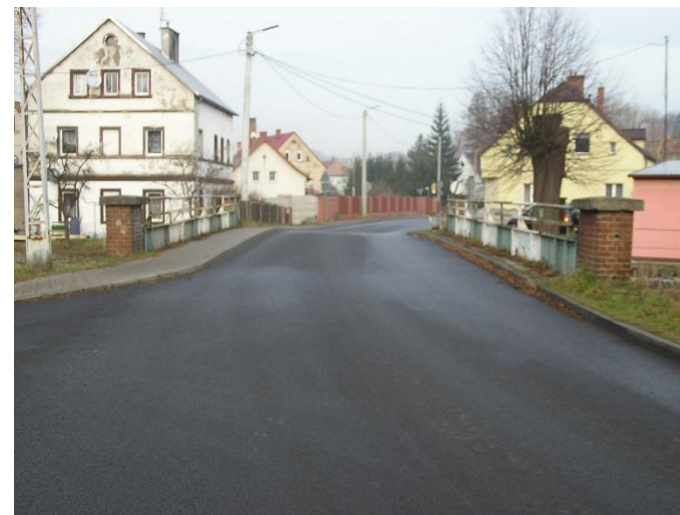
Fot. 4. Widok mostu od strony m. Miłoszów (granica z Czechami).
