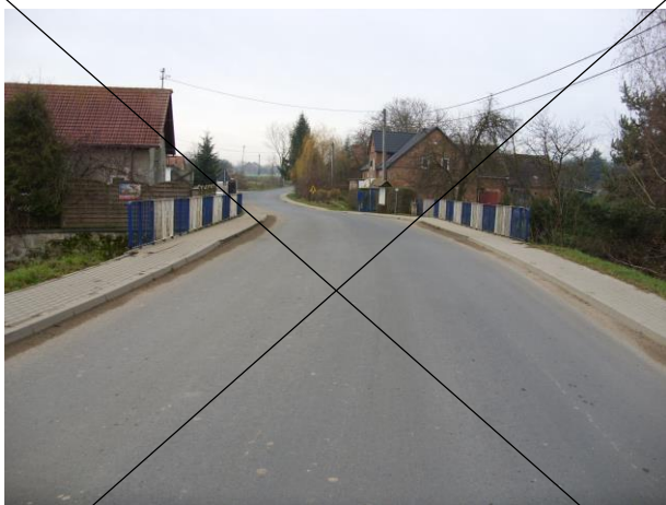
Fot. 3. Widok mostu od strony m. Męciszów.
