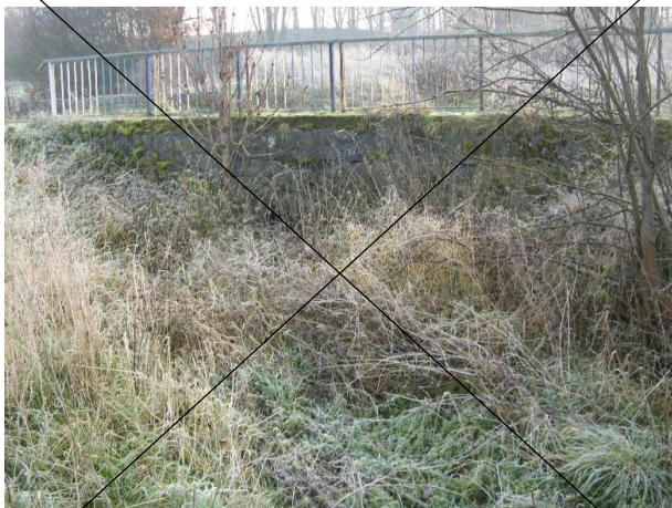
Fot. 1. Widok mostu od strony dolnej wody.
