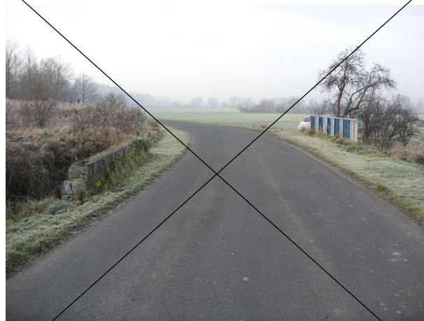
Fot. 4. Widok mostu od strony m. Nowogrodziec.
