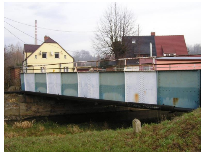
Fot. 2. Widok mostu od strony dolnej wody.
