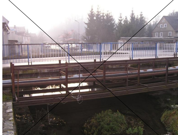
Fot. 2. Widok mostu od strony dolnej wody.
