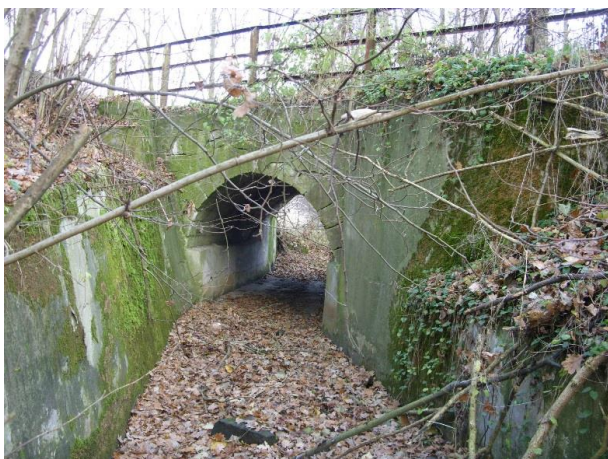
Fot. 1. Widok mostu od strony górnej wody.
