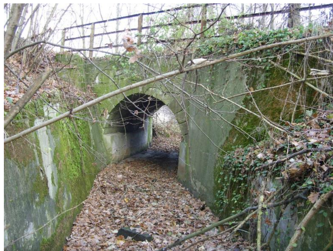
Fot. 1. Widok mostu od strony górnej wody.
