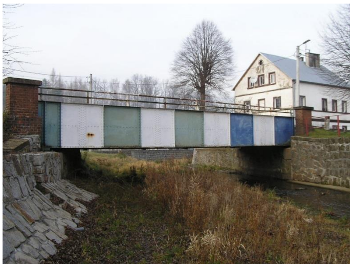
Fot. 1. Widok mostu od strony górnej wody.
