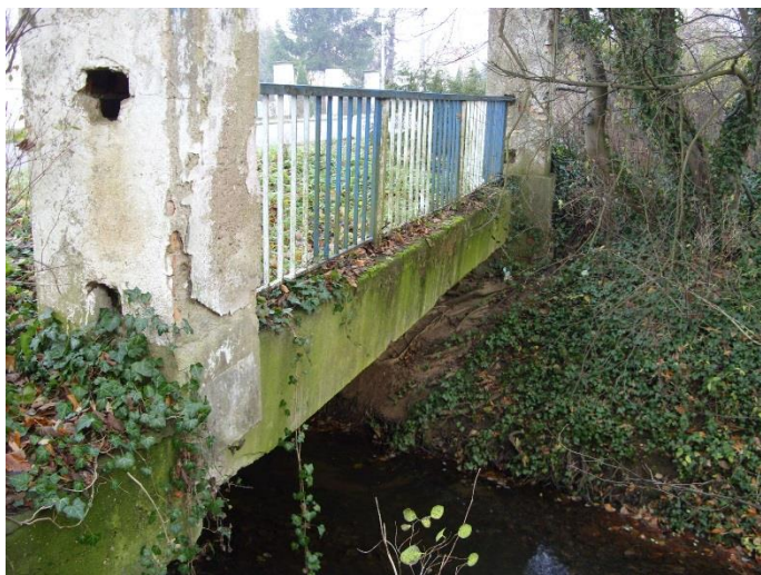
Fot. 1. Widok mostu od strony górnej wody.
