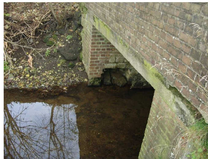
Fot. 2. Widok mostu od strony dolnej wody.
