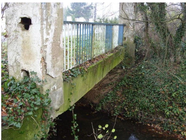
Fot. 1. Widok mostu od strony górnej wody.
