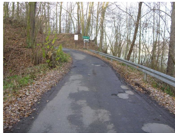
Fot. 4. Widok mostu od strony m. Nowogrodzic.
