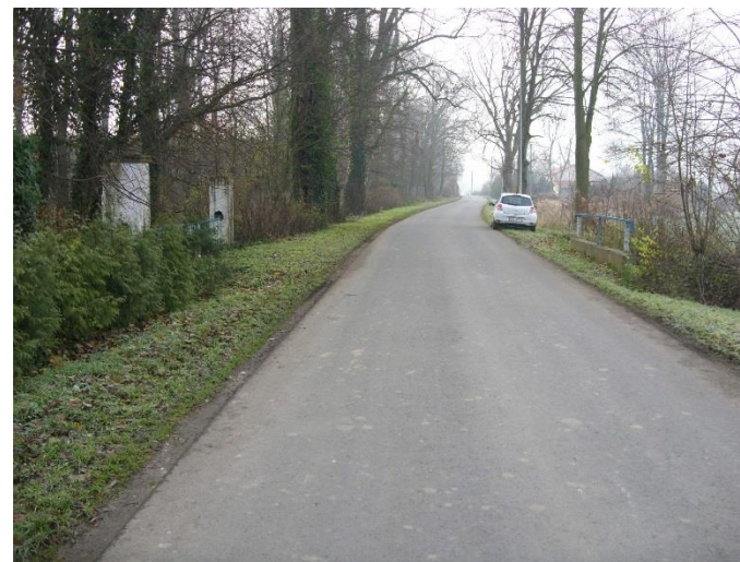
Fot. 4. Widok mostu od strony m. Nowogrodzic.
