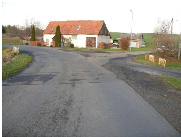
Fot. 4. Widok mostu od strony m. Gościszów.
