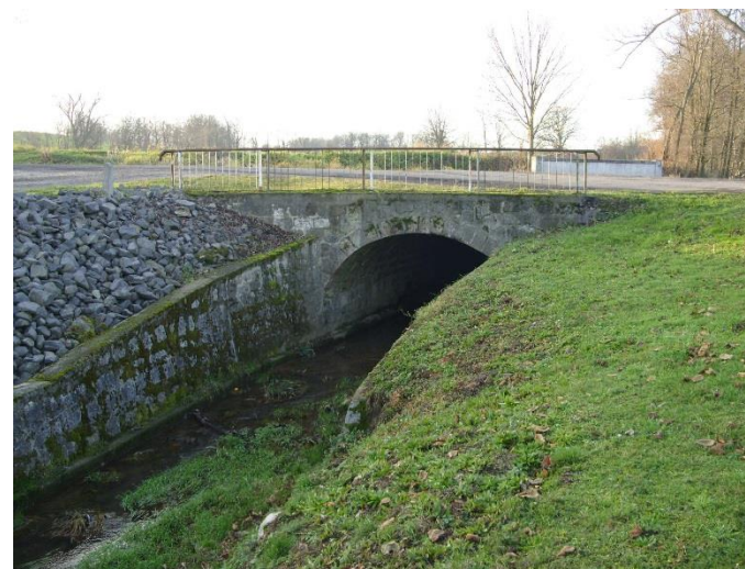
Fot. 2. Widok mostu od strony dolnej wody.
