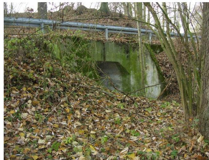
Fot. 2. Widok mostu od strony dolnej wody.
