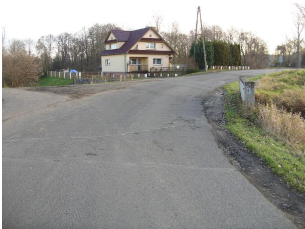
Fot. 3. Widok mostu od strony m. Mściszów.
