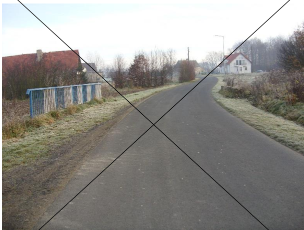
Fot. 3. Widok mostu od strony m. Lubań.
