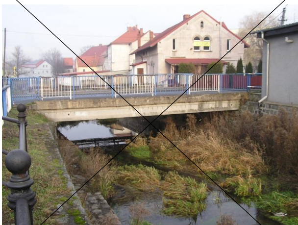
Fot. 1. Widok mostu od strony górnej wody.
