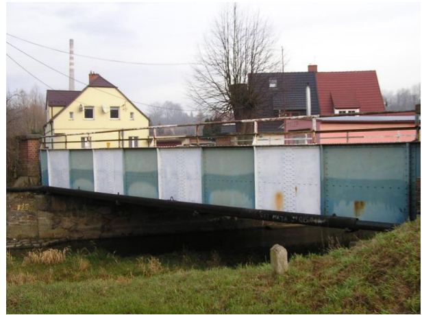
Fot. 2. Widok mostu od strony dolnej wody.
