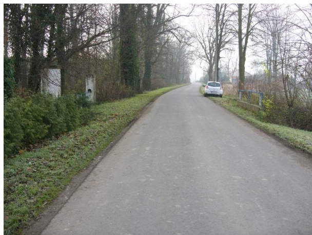
Fot. 4. Widok mostu od strony m. Nowogrodzic.
