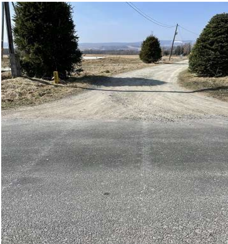
Zdj. nr 1 Km 0+000 Początek projektowanego odcinka drogi
