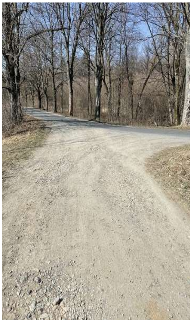
Zdj. nr 6 Koniec projektowanego odcinka km 0+870
