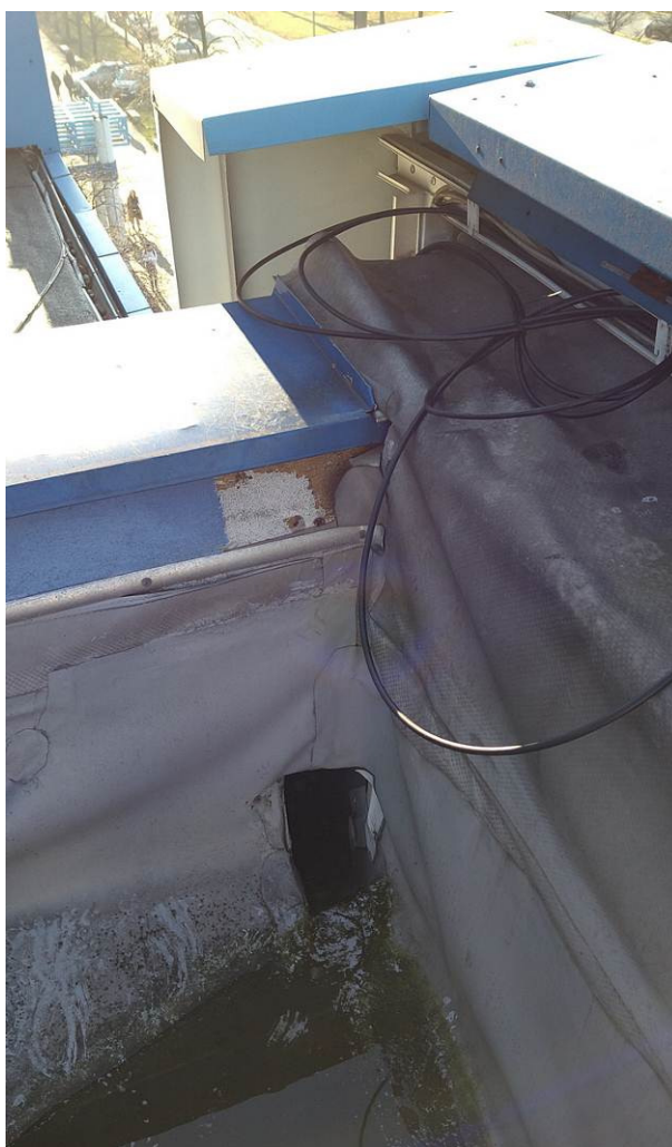
Elementy wystające z połaci wzdłuż attyki elewacji zachodniej, przelew w pld.-zach. narożniku.
