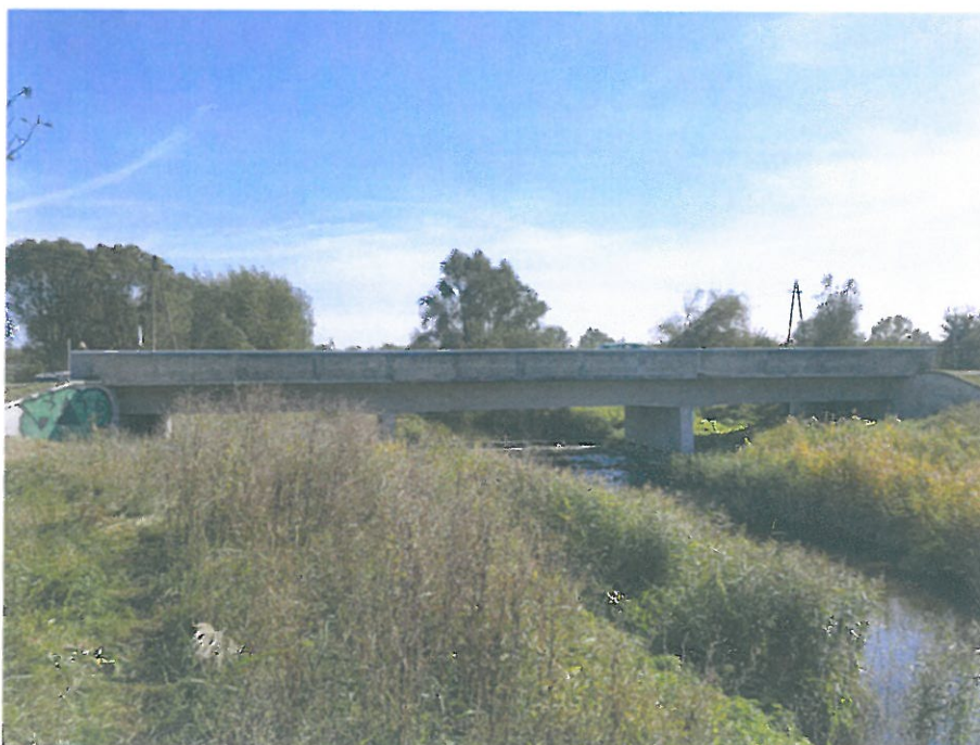
Widok od strony dolnej wody
