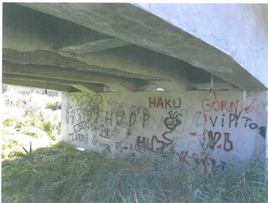
Spód przęsła w części dojazdowej strona południowa
