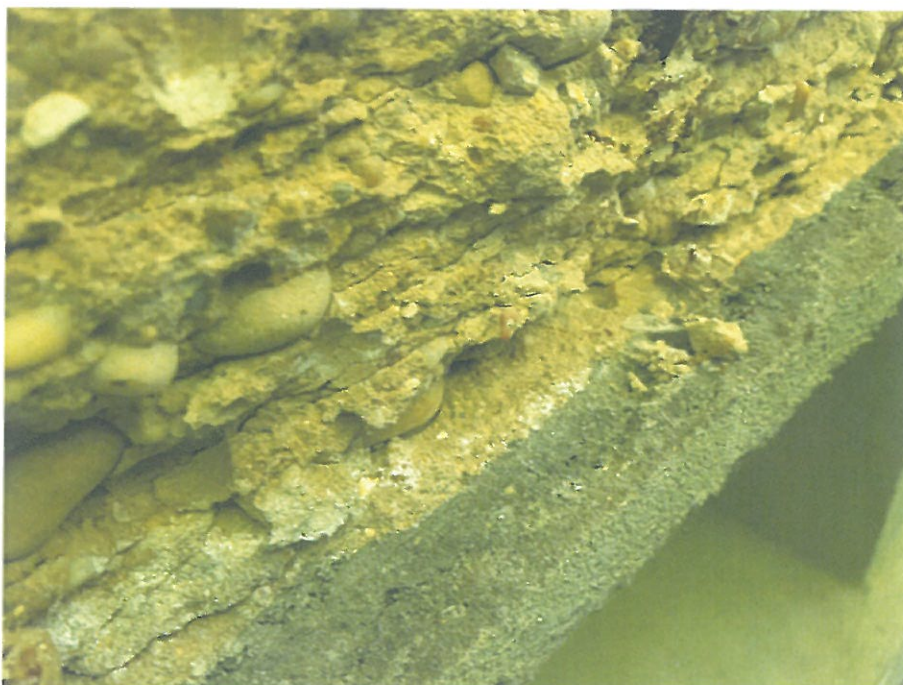
Widok stanu technicznego betonu płaszczka oraz stanu technicznego betonu istniejącej konstrukcji
