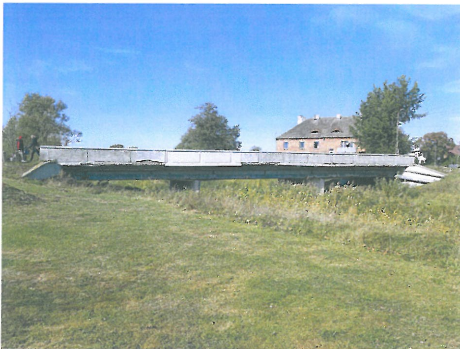
Widok od strony górnej wody
