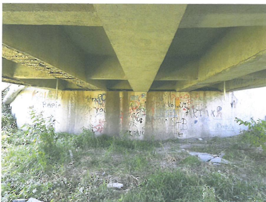
Spód przęsła w części dojazdowej strona północna
