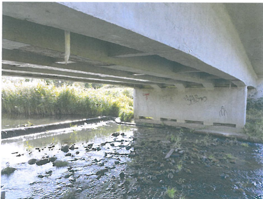
Spód przęsła w części nurtowej
