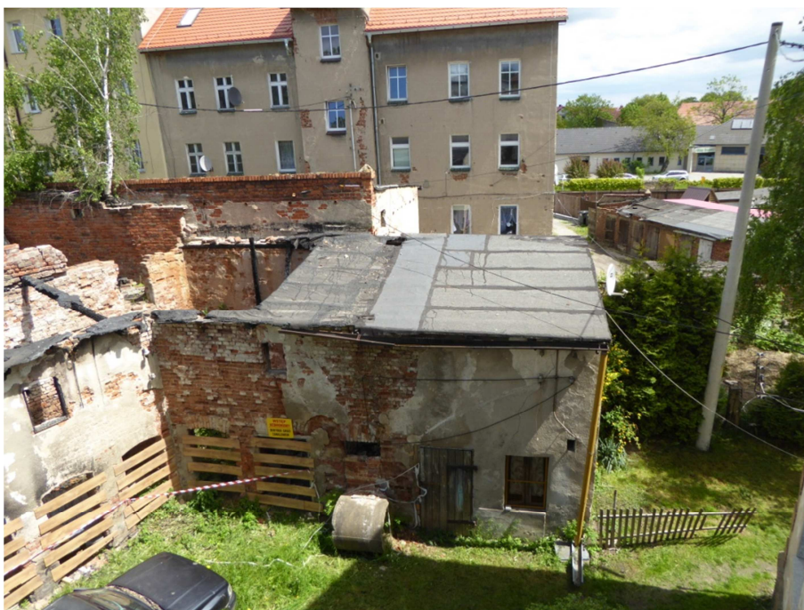
2. Budynek przeznaczony do rozbiórki – część południowa.
