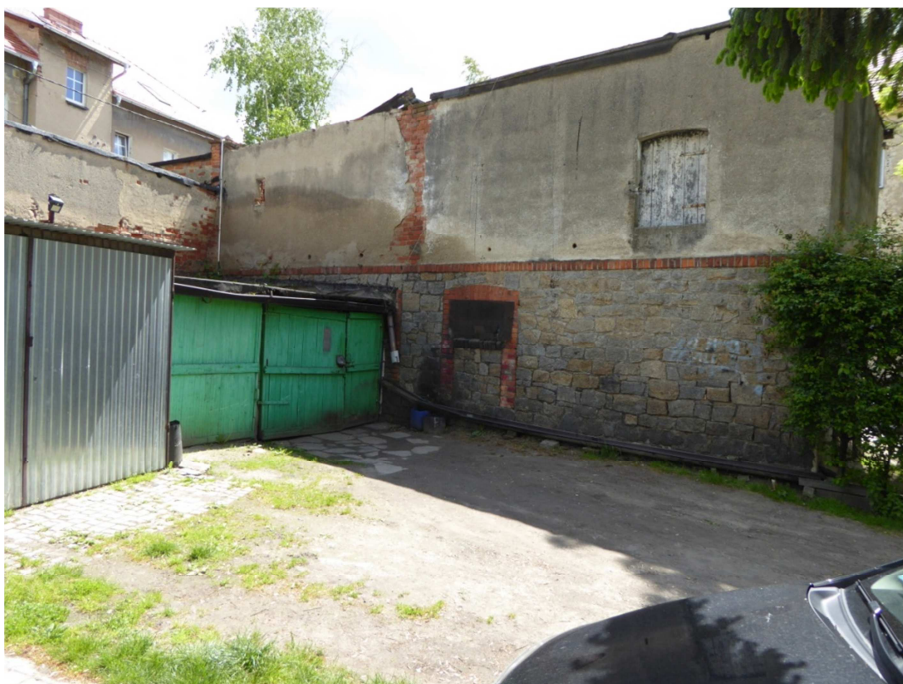
1. Mur kamienny przeznaczony do pozostawienia oraz garaż przeznaczony do zabezpieczenia.
