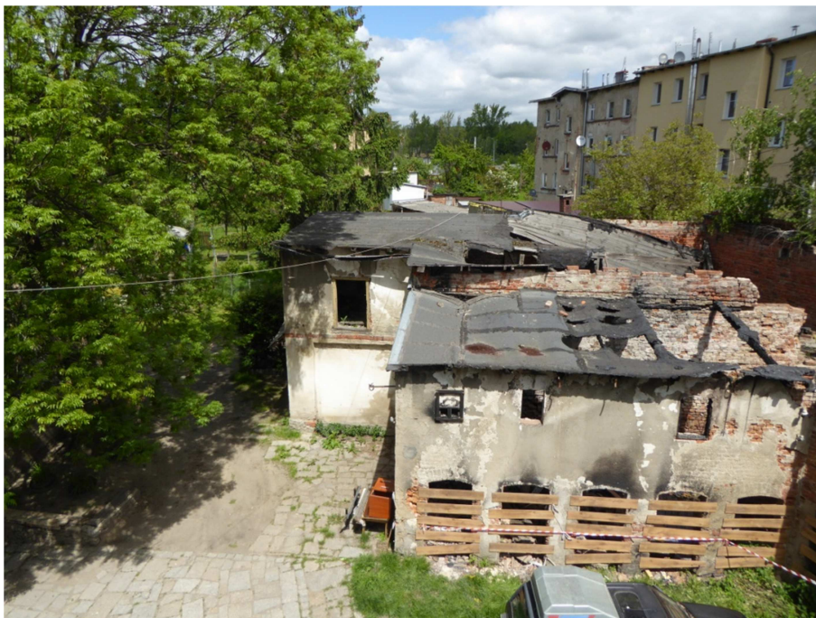
3. Budynek przeznaczony do rozbiórki – część północna.
