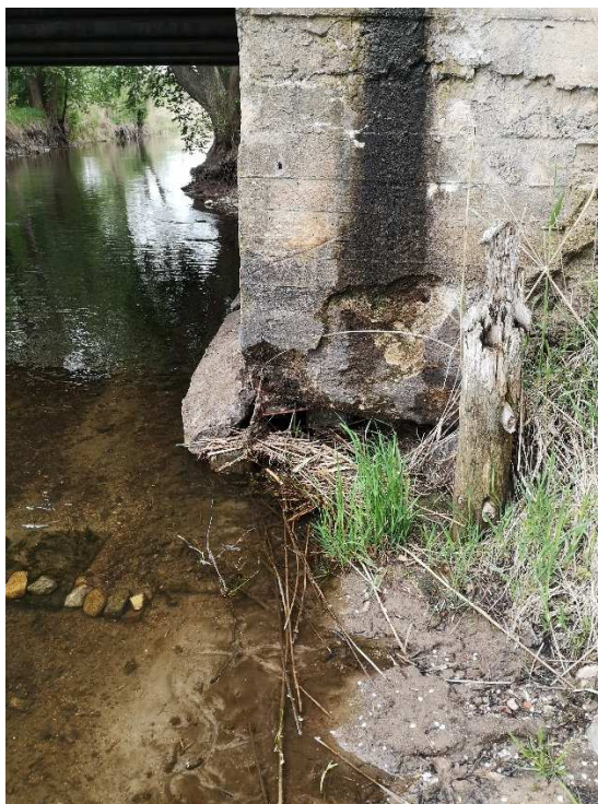
Zdj. 1. Erozja na południowo-zachodnim przyczółku mostu.
