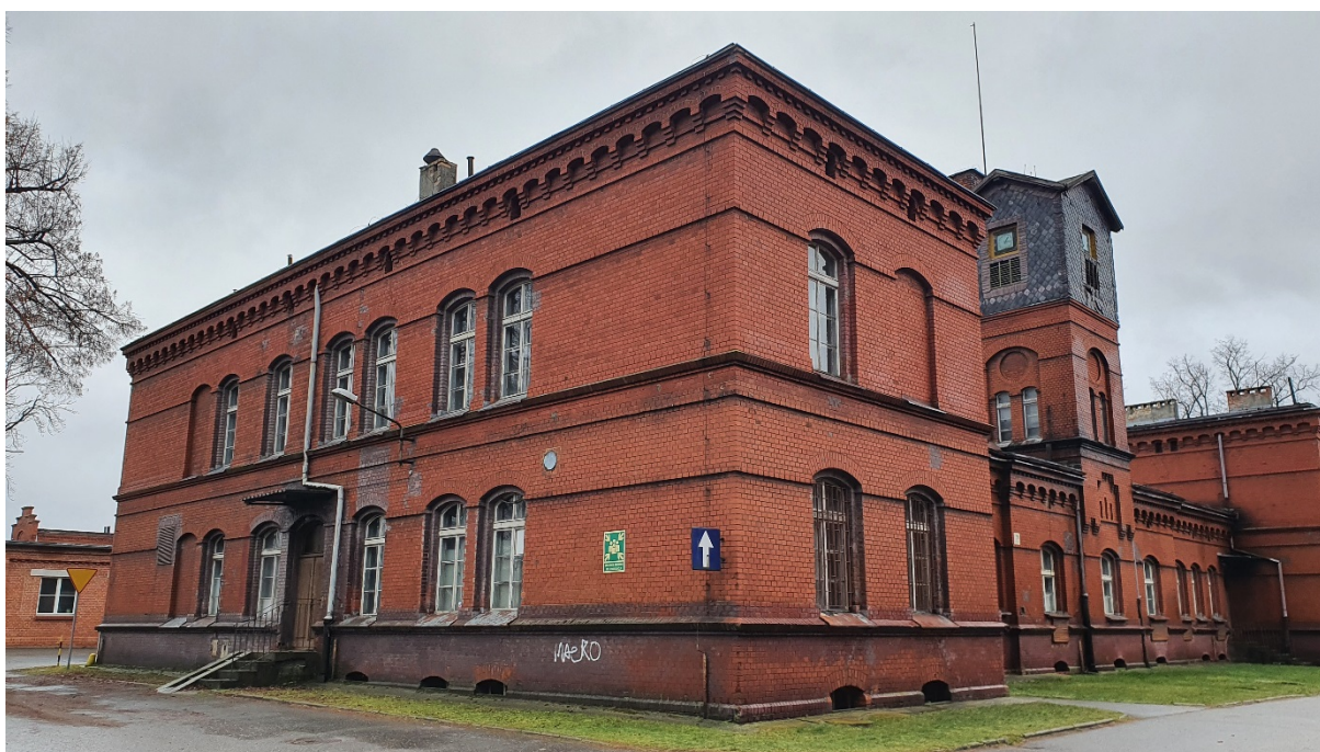
Widok elewacji północno-zachodniej. [fotografia stan na 10.03.2022 r.]
