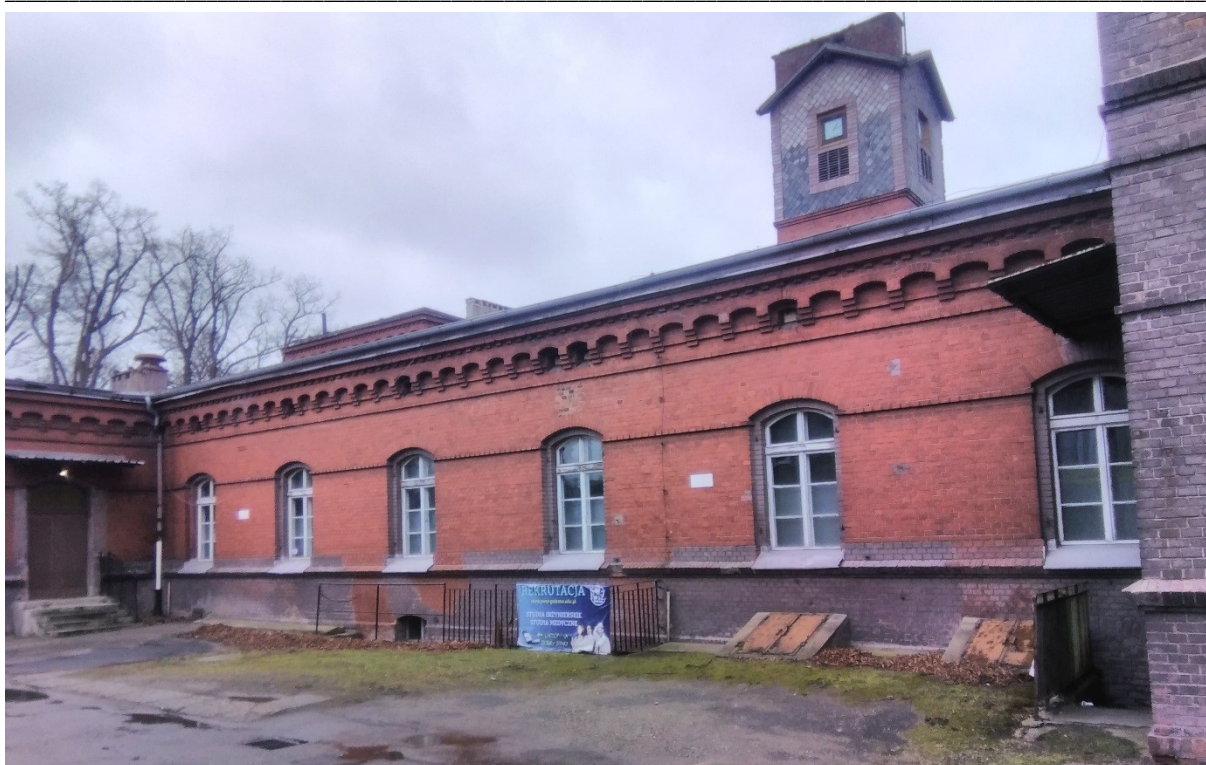
Widok elewacji wschodniej. [fotografia stan na 10.03.2022 r.]
