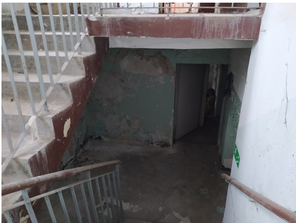
Widok schodów do piwnicy. [fotografia stan na 10.03.2022 r.]
