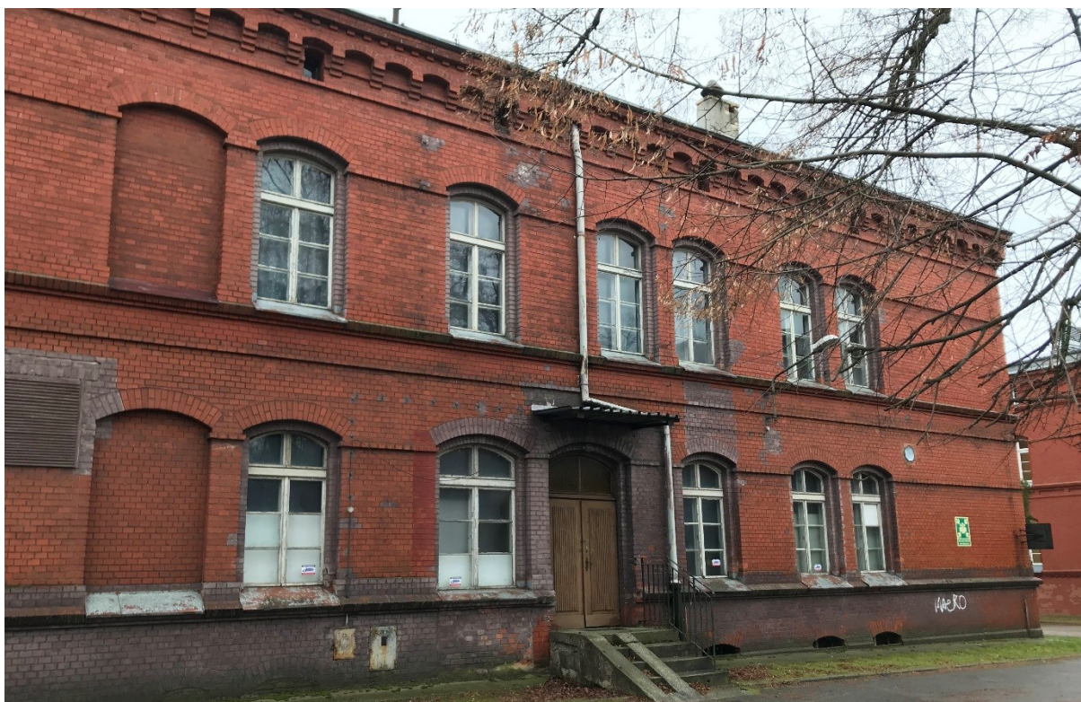
Widok elewacji północnej. [fotografia stan na 10.03.2022 r.]
