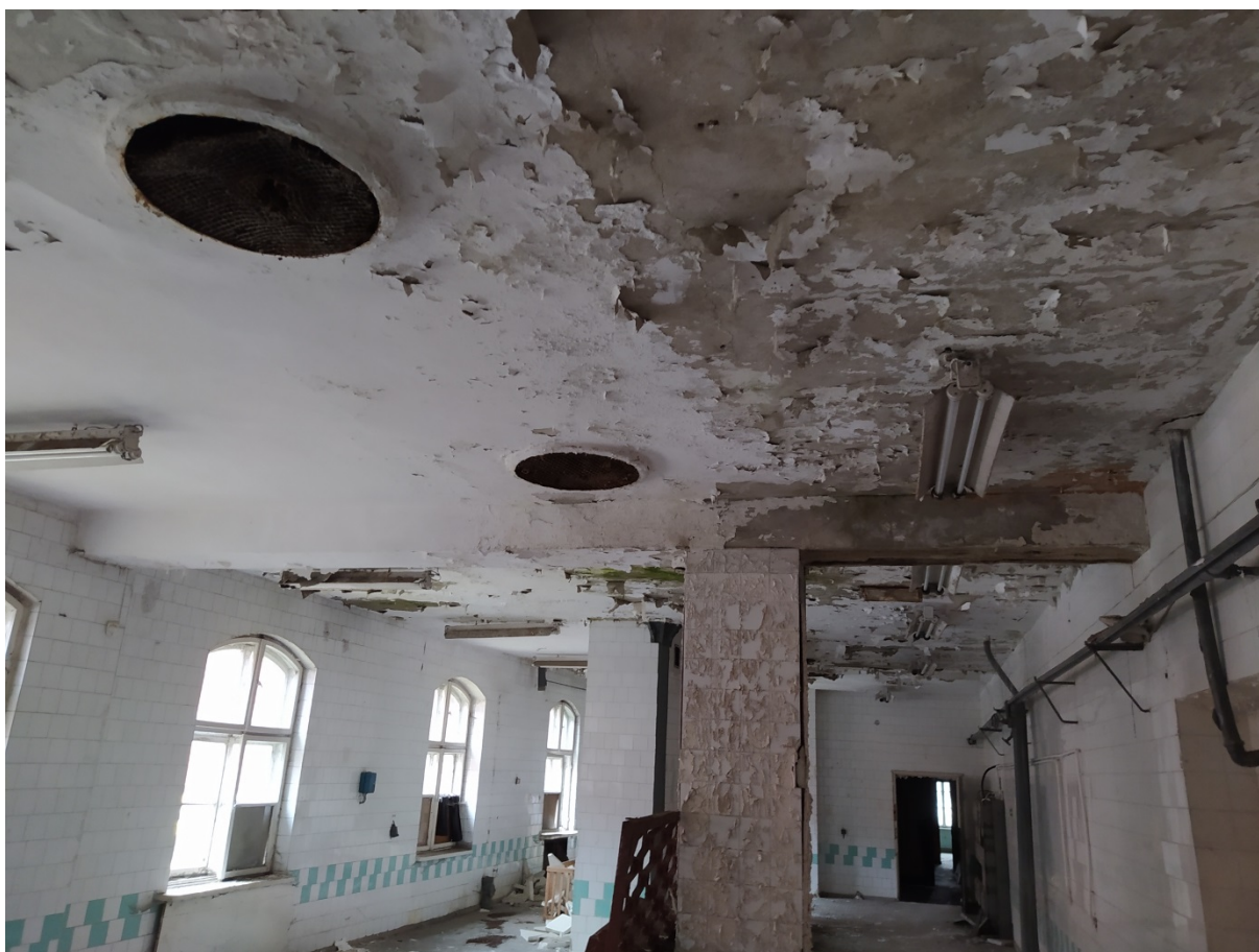
Widok stropów nad parterem
