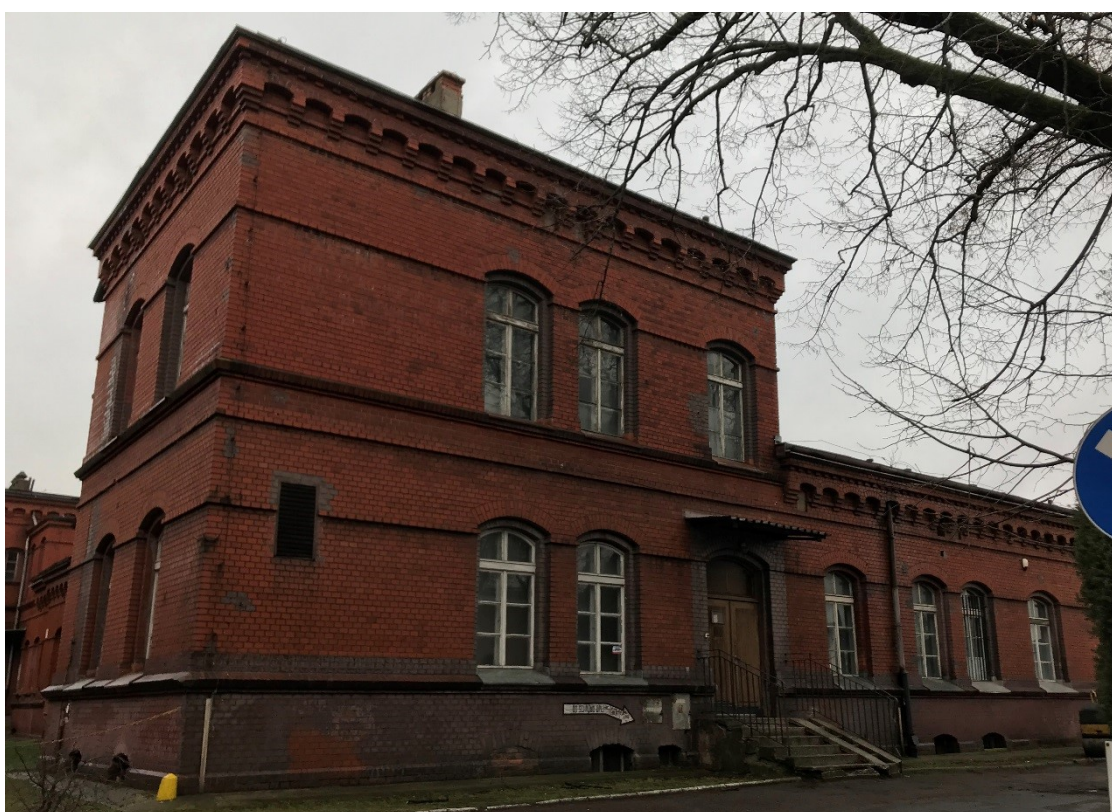
Widok elewacji południowej. [fotografia stan na 10.03.2022 r.]
