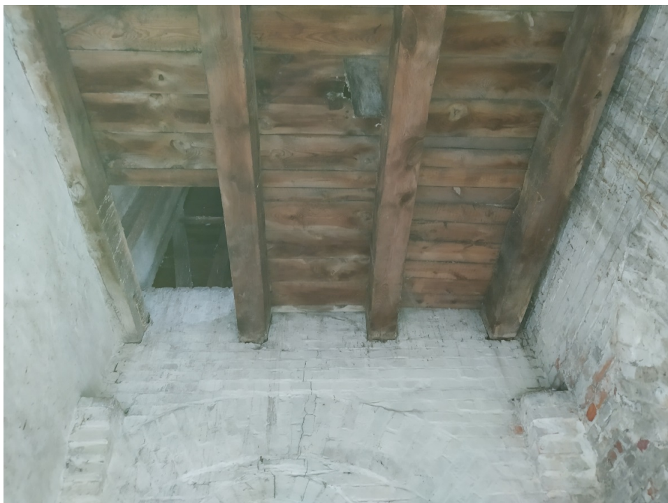
Widok konstrukcji stropu wieży. [fotografia stan na 10.03.2022 r.]
