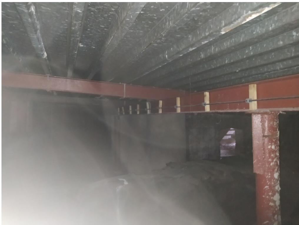
Konstrukcja stropodachu w części środkowej budynku. [fotografia stan na 10.03.2022 r.]
