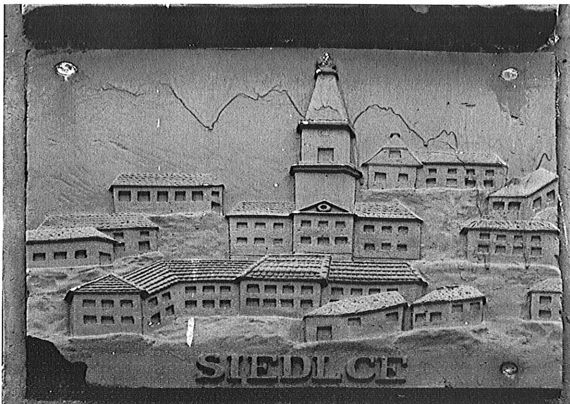
Fot. 7. Pomnik Traktu Brzeskiego. Zacieki farby na powierzchni płyciny. Widoczny także ubytek fragmentu płaskorzeźby i zabrudzenia powierzchni.
