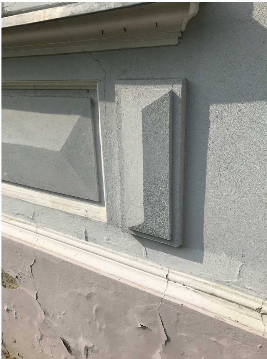
Fot. 12. Detal boniowania pod oknami ryzalitów
