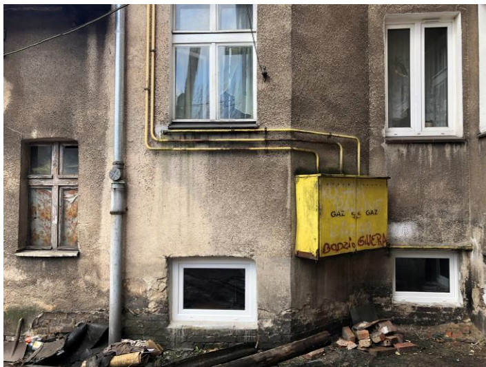
Zdjęcie nr 5 – Fragment elewacji północno – zachodniej – skrzynka gazowa i fragment instalacji gazowej na elewacji budynku – do przebudowy
