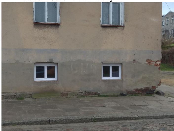
Zdjęcie nr 2 – Fragment elewacji frontowej (zachodniej) – Widoczne ubytki cokołu
