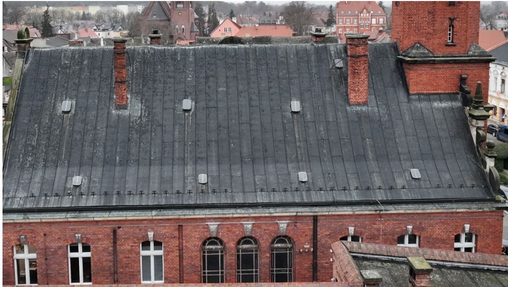
Fot. 8 Pokrycie dachu, widok od strony wschodniej.
