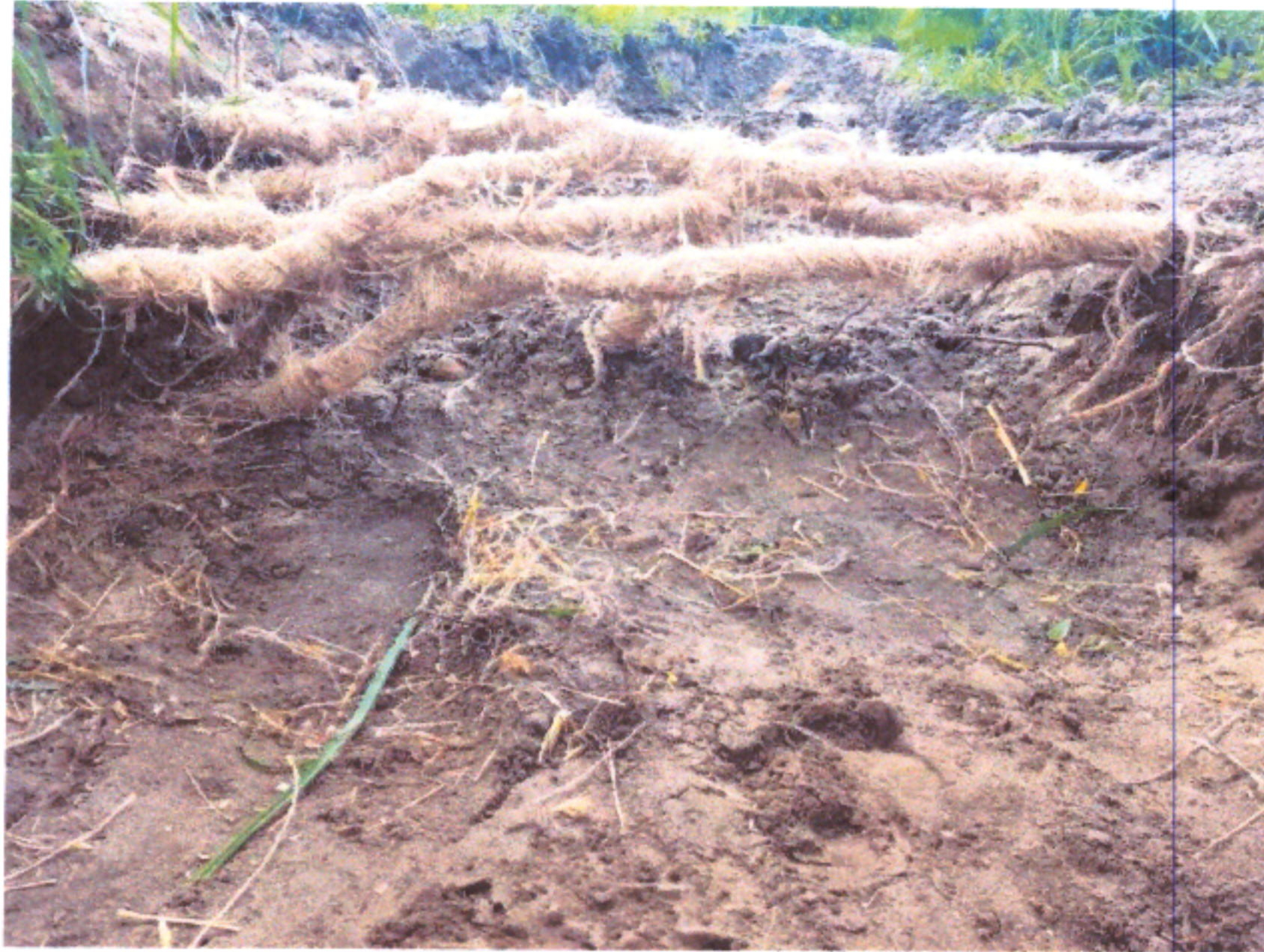
Rys. 3. Korzenie drzewa odsłonięte w wykopie, zabezpieczone przez prawidłowe „odłożenie” i owinięcie tkaniną jutową. Źródło: https://siedem-wierzb.pl/korzenie-drzew-podczas-prac-ziemnych-jak-chronic/
