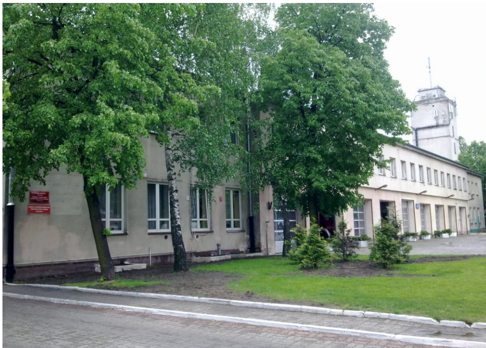
fot. nr 1: elewacja północno- zachodnia (od strony ul. Majdańskiej)
