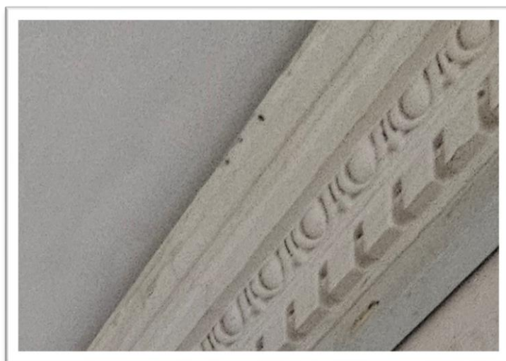
Fotografia 13 Stan istniejący – Hol ściana I piętro - detal wielokrotnie przemalowywany.
