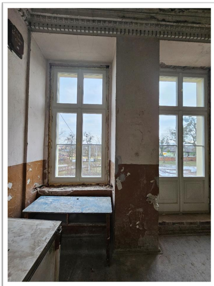
Fotografia 12 Stan istniejący – Hol ściana południowa I piętro - detale, okna.
