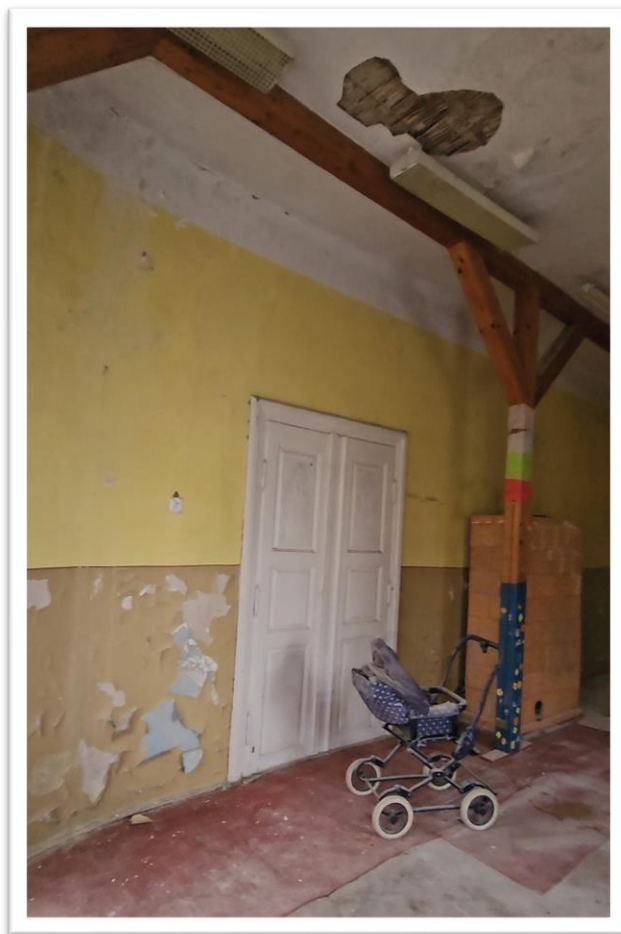
Fotografia 31 Stan istniejący (inwentaryzacja pom. 02 parter) wschód – Sala spotkań – podparcie stropu, zachowane drzwi
