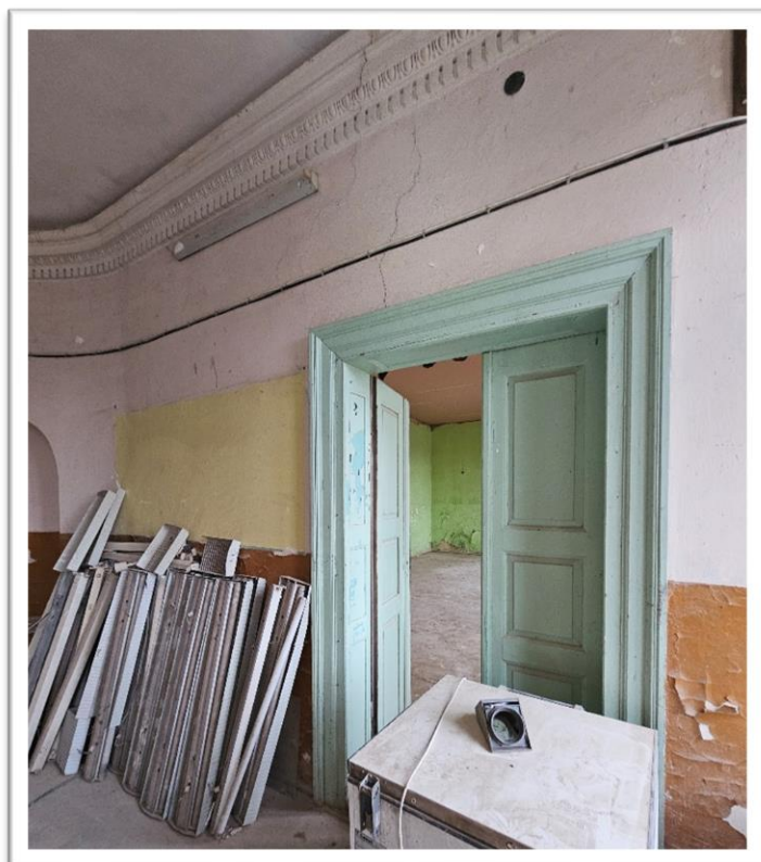
Fotografia 15 Stan istniejący – Hol ściana zachodnia I piętro – drzwi, detale, nisze.
