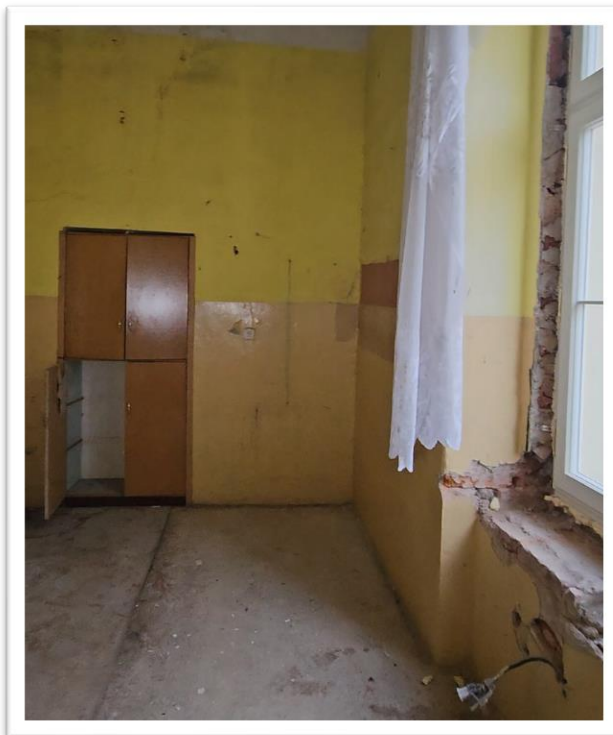
Fotografia 44 Stan istniejący (inwentaryzacja pom. 21 parter) – Zaplecze socjalne – widok stanu po adaptacji pomieszczeń na przedszkole.
