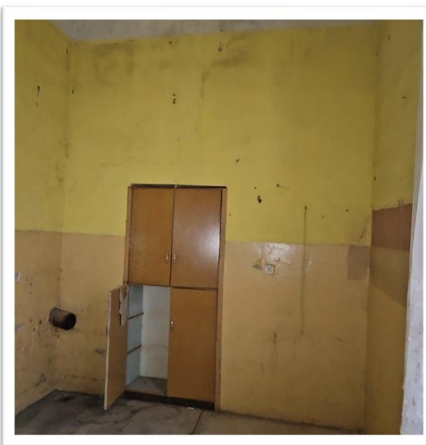
Fotografia 45 Stan istniejący (inwentaryzacja pom. 21 parter) – Zaplecze socjalne – widok stanu po adaptacji pomieszczeń na przedszkole.
