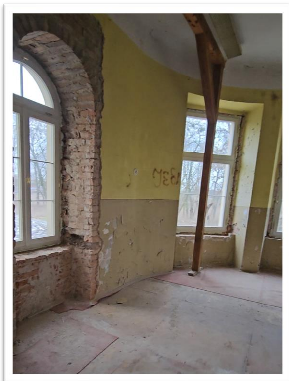
Fotografia 29 Stan istniejący (inventaryzacja pom. 02 parter) zachód – Sala spotkań – podparcie stropu, nowa stolarka okienna
