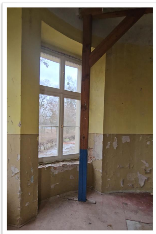
Fotografia 30 Stan istniejący (inventaryzacja pom. 02 parter) – Sala spotkań – podparcie stropu, nowa stolarka okienna
