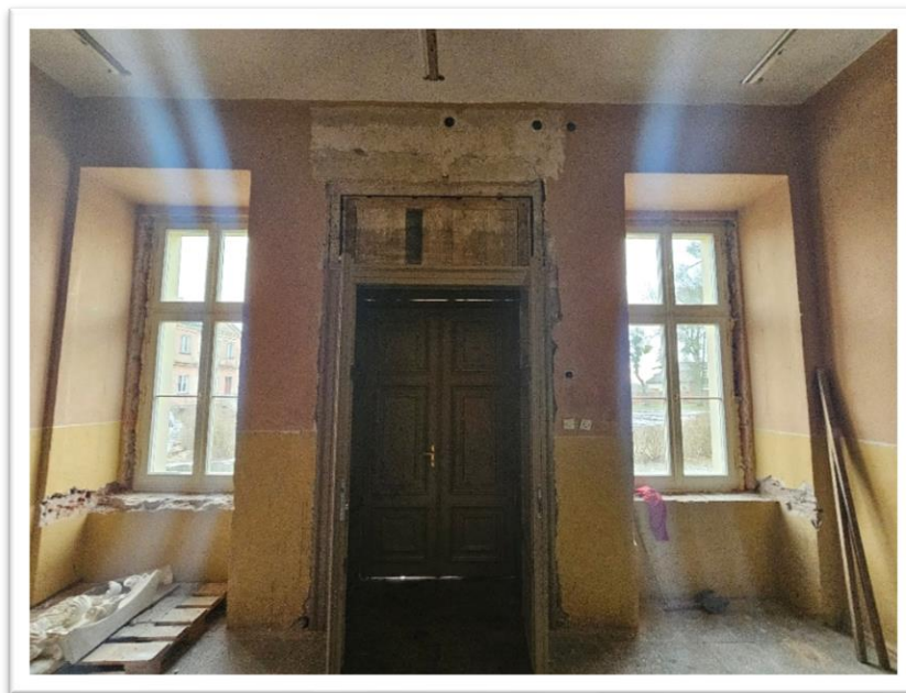
Fotografia 10 Stan istniejący – Hol ściana wschodnia parter - Schody wachlarzowe; drzwi, detale, nisze, lastriko.
