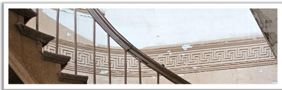
Fotografia 9 Stan istniejący – Hol ściana północna- detal
