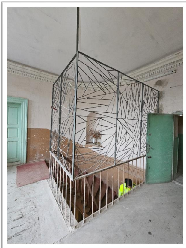
Fotografia 16 Stan istniejący – Hol ściana północno-wschodnia I piętro – trakt do likwidacji, detale, nisze.
