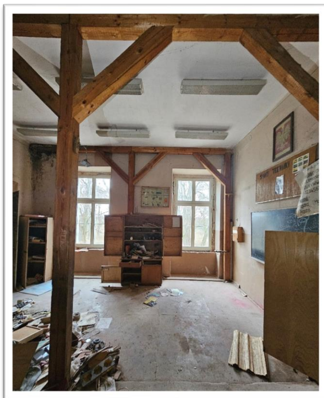
Fotografia 25 Stan istniejący (inventaryzacja pom. 03 parter) północ – Czytelnia – podparcie stropu.
