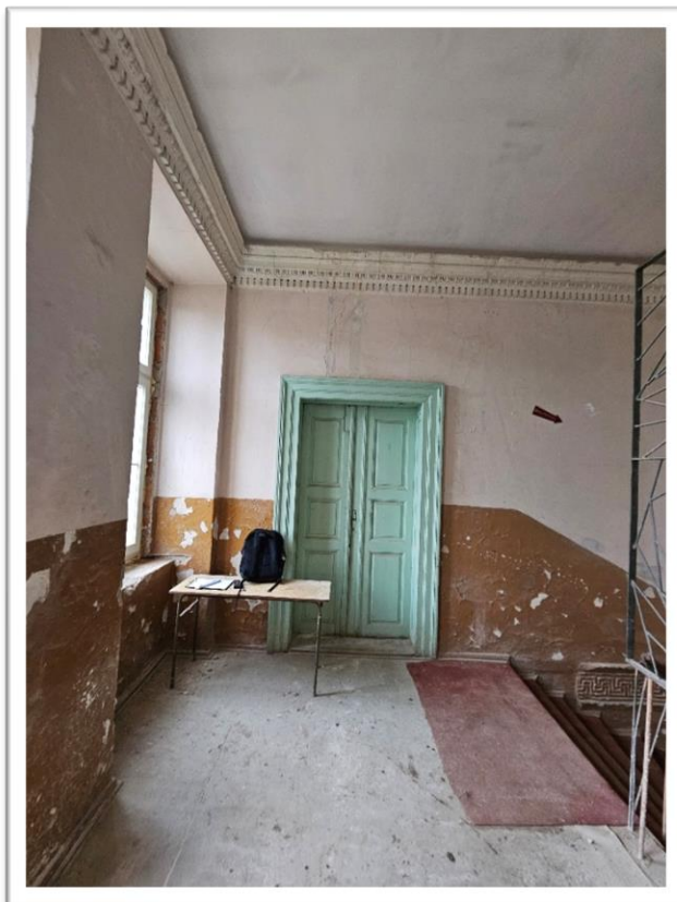
Fotografia 17 Stan istniejący – Hol ściana wschodnia I piętro – trakt do zachowania, detale, drzwi.
