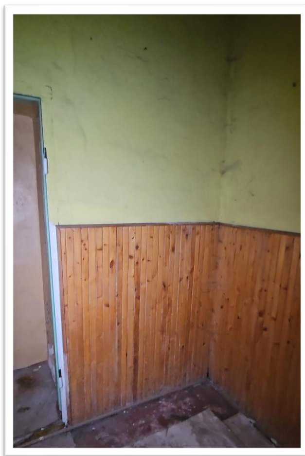
Fotografia 43 Stan istniejący (inventaryzacja pom. 22 parter) – łazienki – widok stanu po adaptacji pomieszczeń na przedszkole.
