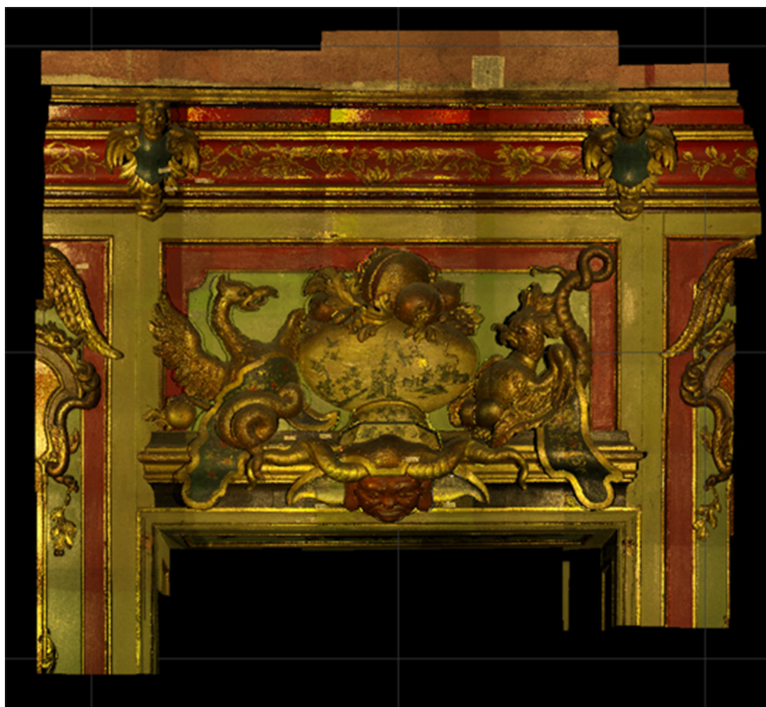
Ilustracja 3.76. Przykładowy fragment złożony z połączonych kart pomiarowych. Fot. R. Sitnik
