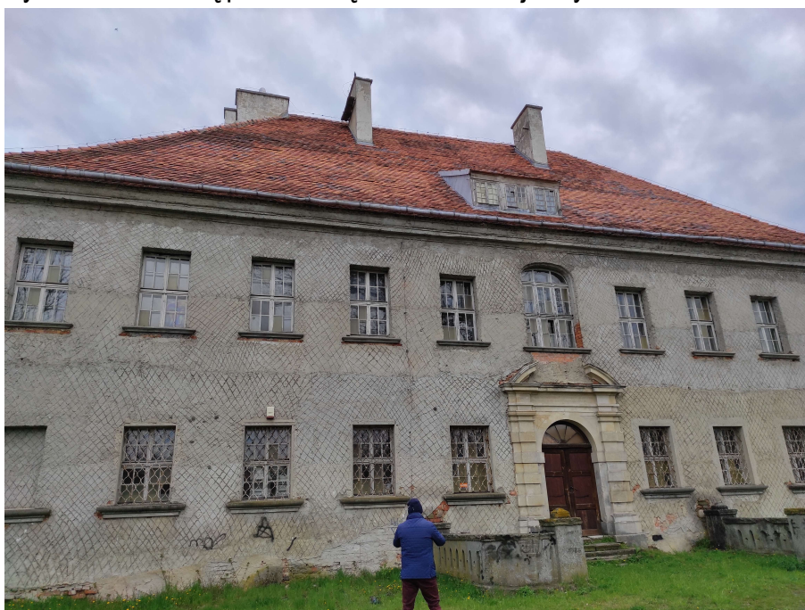
fot. fasada (obramowania okien, gzymsy)
