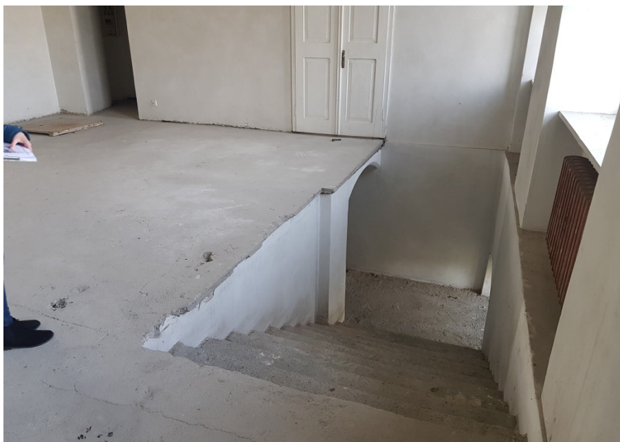
fot. klatka schodowa
