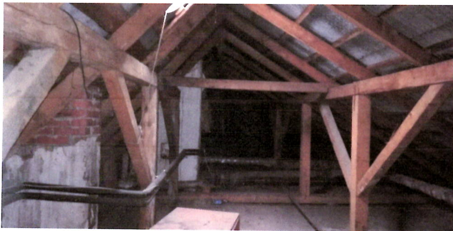
Fot. 16. Poddasze nieużytkowe - drewniana płatwiowo-krokwiowa konstrukcja dachu.
