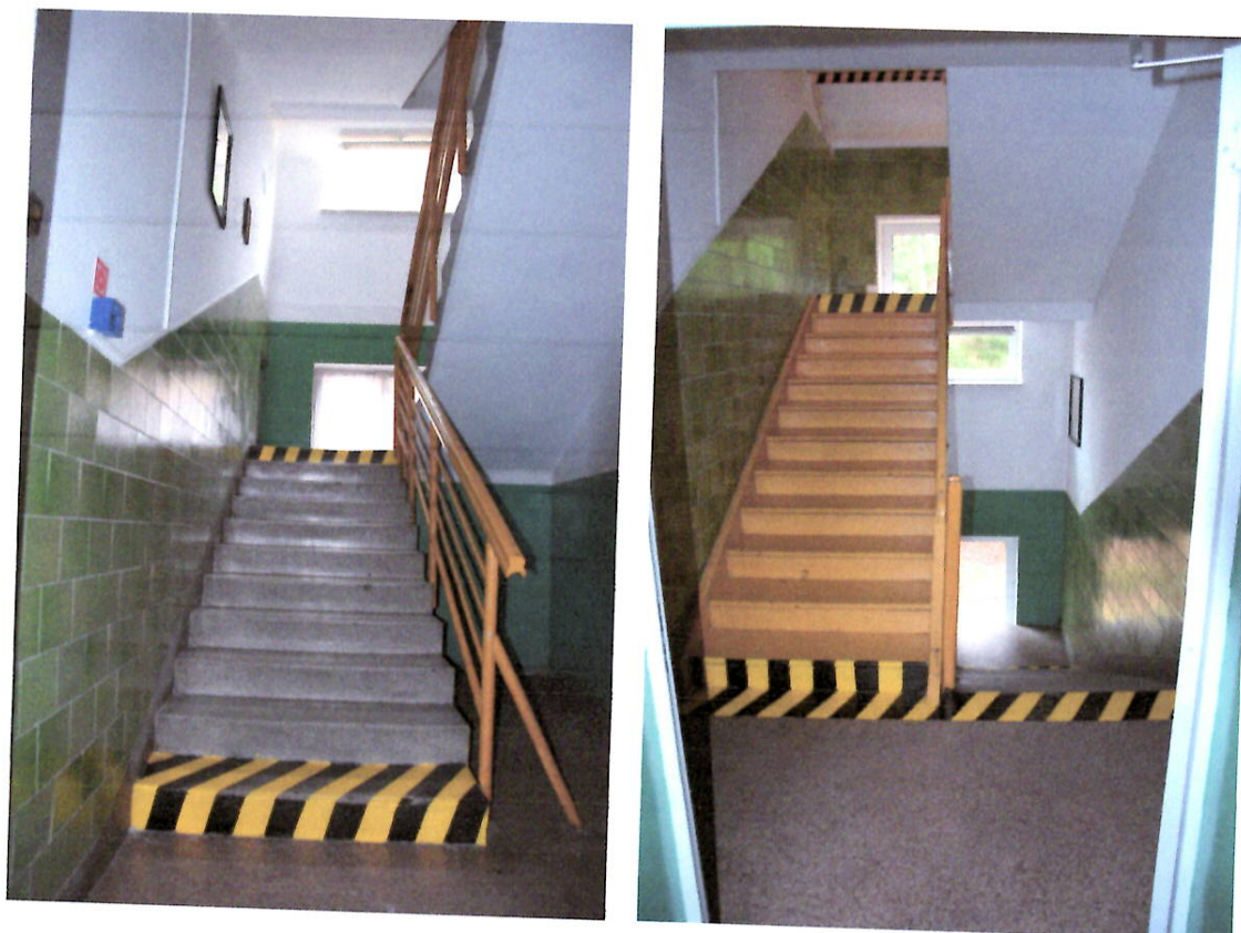
Fot. 14, 15. Budynek j.w. – Wewnętrzna klatka schodowa – schody z parteru na I piętro i na II piętro budynku.
