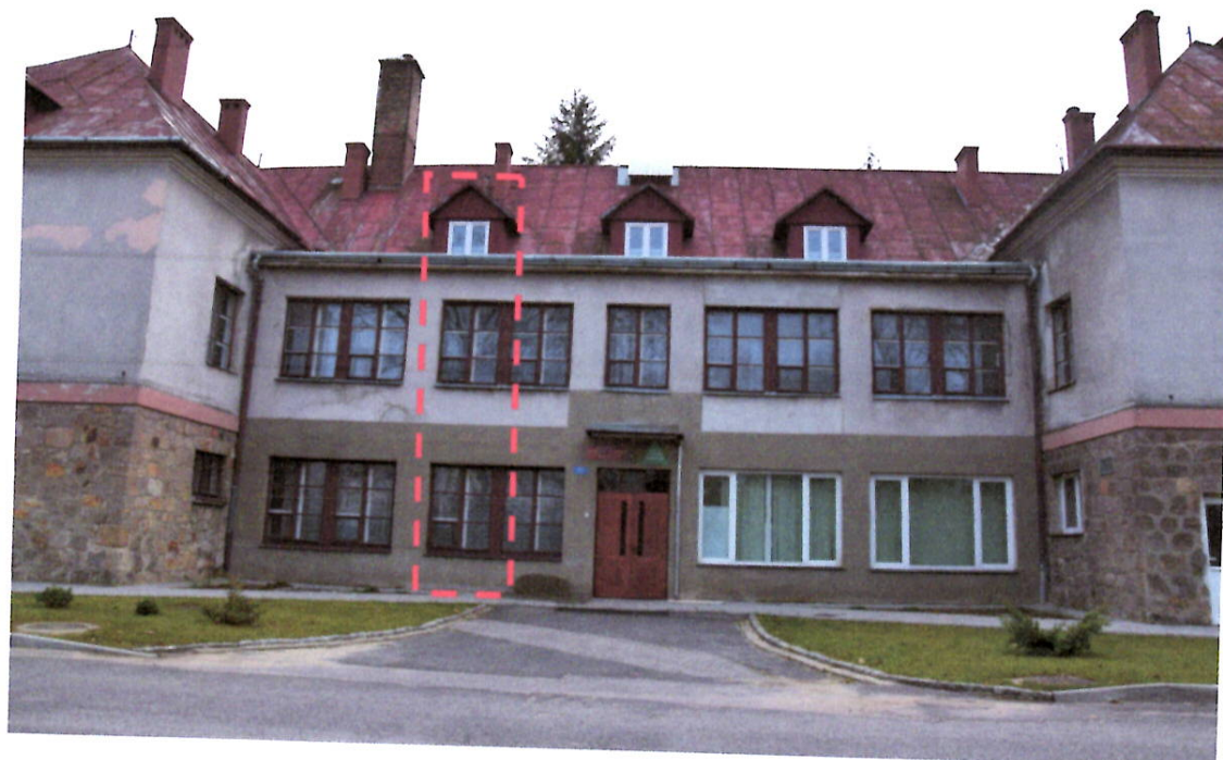
Fot. 4. Budynek j.w. , elewacja frontowa - oznaczenie lokalizacji projektowanego wewnętrznego szybu windowego.
