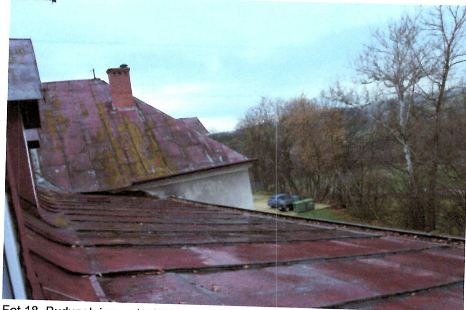
Fot. 17. Dach budynku - pokrycie z blachy ocynkowanej płaskiej na rąbek stojący – wyraźnie widoczne uszkodzenia blachy (ślady korozji) oraz ochronnych powłok malarskich.
