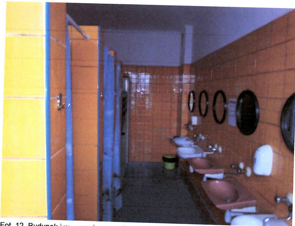
Fot. 12. Budynek j.w. - pomieszczenia sanitarne na I piętrze do przebudowy - stan istniejący.
