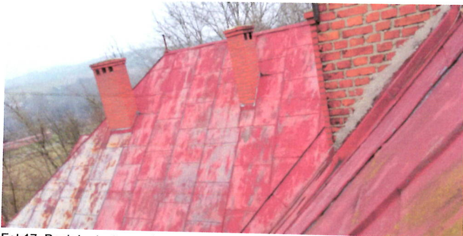
Fot. 17. Dach budynku - pokrycie z blachy ocynkowanej płaskiej na rąbek stojący – wyraźnie widoczne uszkodzenia blachy (ślady korozji) oraz ochronnych powłok malarskich.
