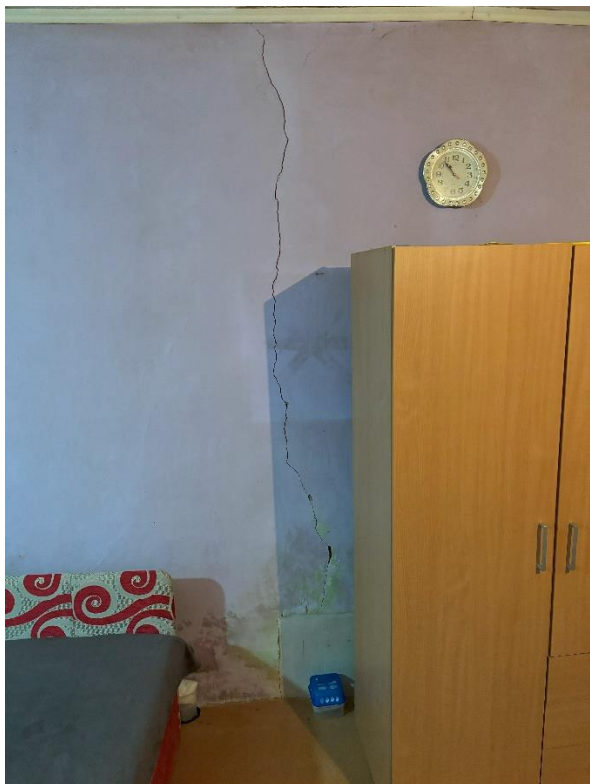
Rys. 14 Uszkodzona ściana - piętro
