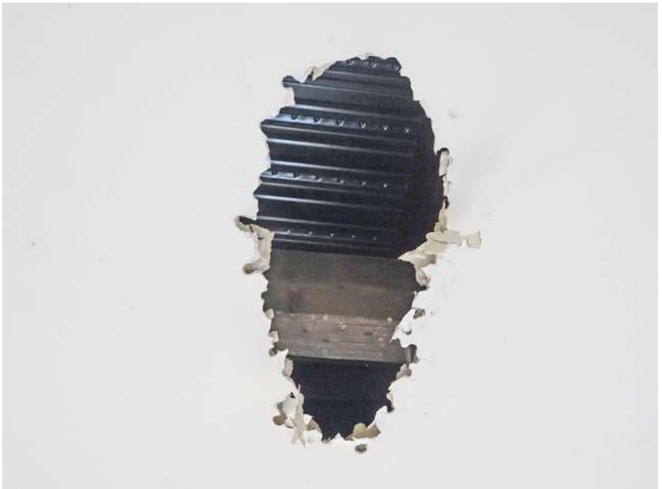
Fot. 28. Budynek nr 6a Szpitala Specjalistycznego im. dra J. Babińskiego SPZOZ w Krakowie. Strop pod częścią poddasza. Stan przed konserwacją. Widoczny stan techniczny konstrukcji stropu. Fot. M. Domańska.
