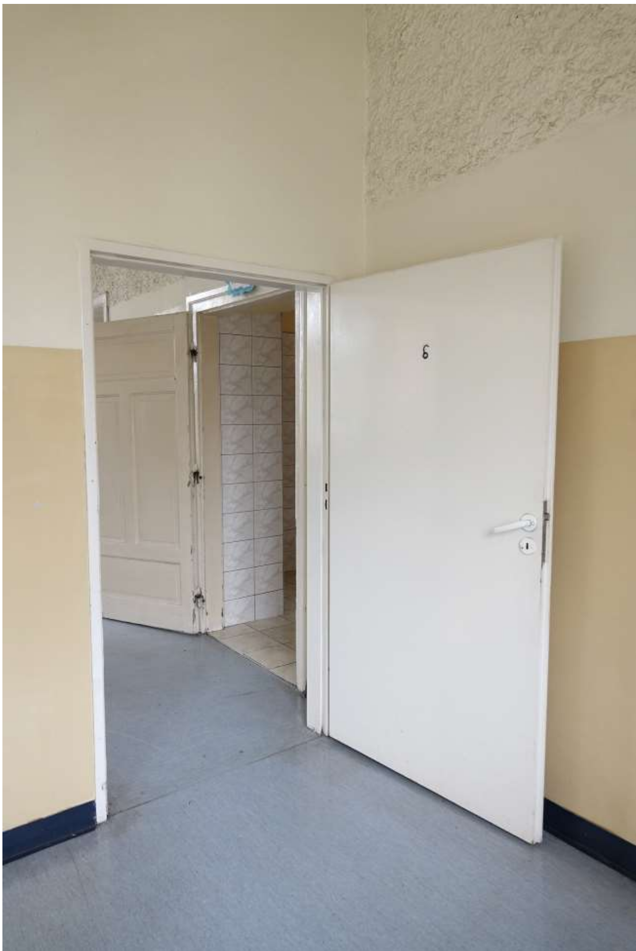
Fot. 44. Budynek nr 6a Szpitala Specjalistycznego im. dra J. Babińskiego SPZOZ w Krakowie. Wnętrze budynku Stan przed konserwacją. Widoczny obecny stan techniczno-estetyczny stolarki drzwiowej oraz tynków wewnętrznych.
