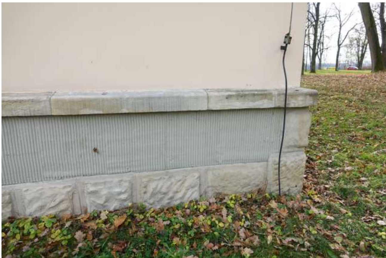
Fot. 22. Budynek nr 6a Szpitala Specjalistycznego im. dra J. Babińskiego SPZOZ w Krakowie. Elewacja płd. Stan przed konserwacją. Widoczny obecny stan techniczno-estetyczny budynku. Fot. M. Domańska.
