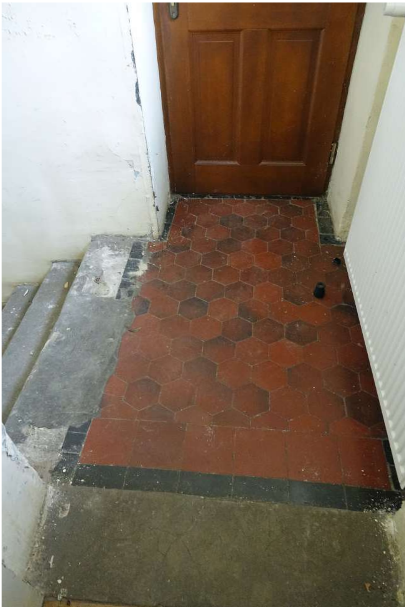
Fot. 40. Budynek nr 6a Szpitala Specjalistycznego im. dra J. Babińskiego SPZOZ w Krakowie. Wnętrze budynku. Stan przed konserwacją. Widoczny nieestetyczne tynki na ścianach. Zniszczone oryginalne posadzki kamionkowe. Fot. M. Domańska.
