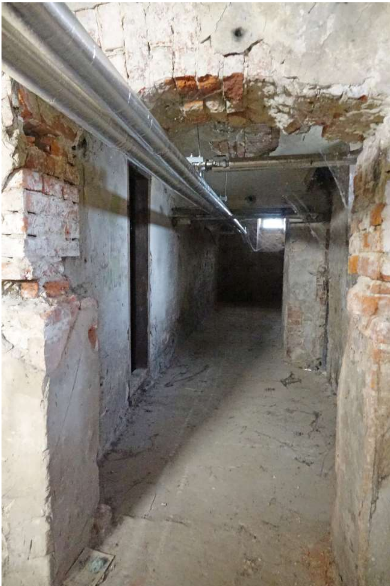
Fot. 56. Budynek nr 6a Szpitala Specjalistycznego im. dra J. Babińskiego SPZOZ w Krakowie. Wnętrze budynku. Stan przed konserwacją. Widoczny bardzo zły stan tynków w piwnicy. Fot. M. Domańska.
