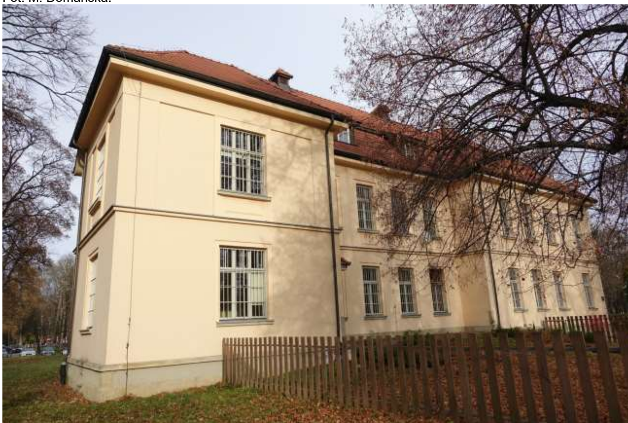
Fot. 19. Budynek nr 6a Szpitala Specjalistycznego im. dra J. Babińskiego SPZOZ w Krakowie. Elewacje wsch. i pld. Stan przed konserwacją. Widoczny obecny stan techniczno-estetyczny budynku. Fot. M. Domańska.
