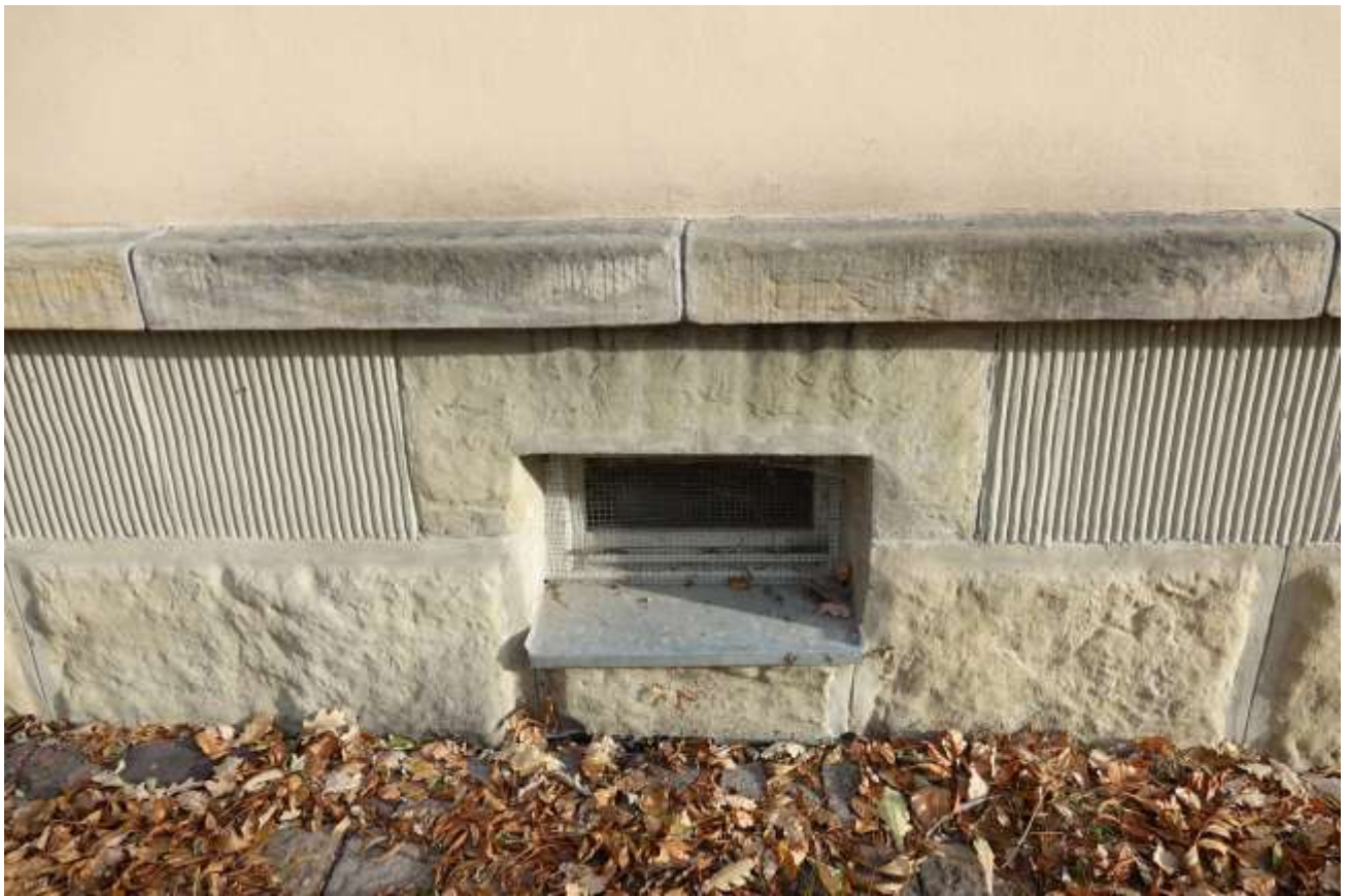
Fot. 20. Budynek nr 6a Szpitala Specjalistycznego im. dra J. Babińskiego SPZOZ w Krakowie. Elewacja płd. Stan przed konserwacją. Widoczny obecny stan techniczno-estetyczny budynku. Fot. M. Domańska.
