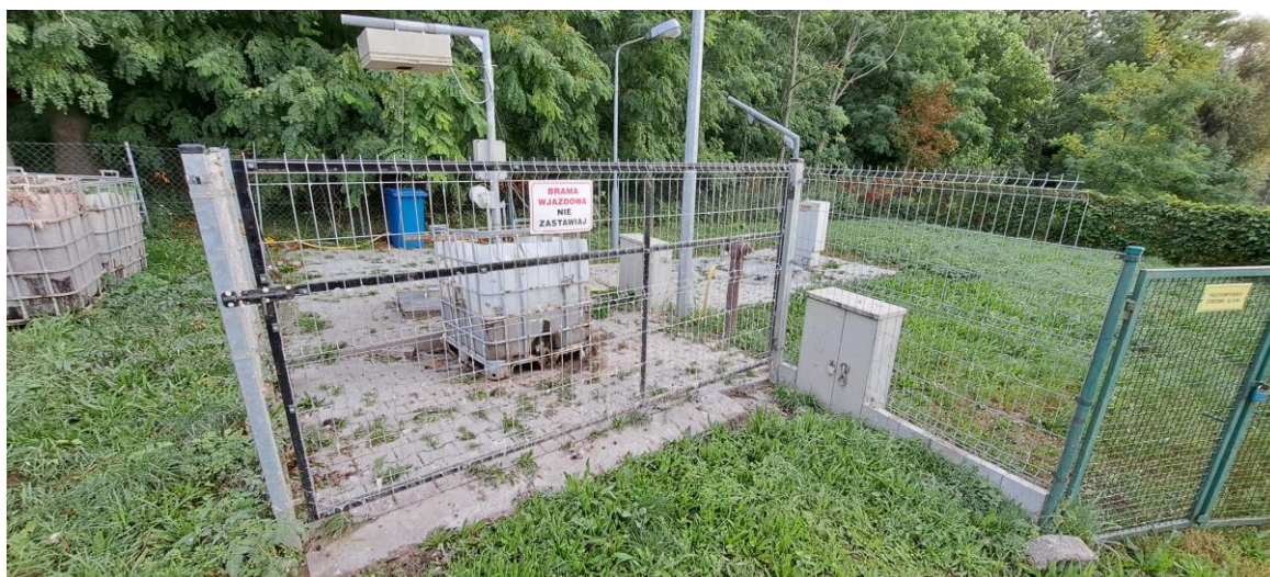
Zdjęcie terenu istniejącej przepompowni
