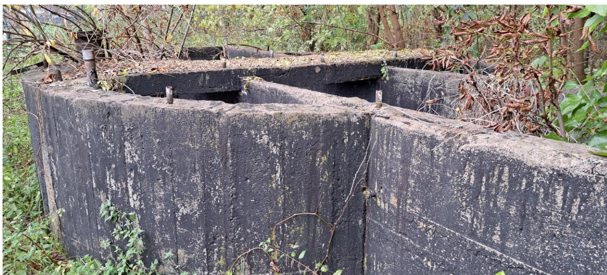
Zdjęcie istniejącego żelbetowego zbiornika Imhoffa – do rozbiórki.
