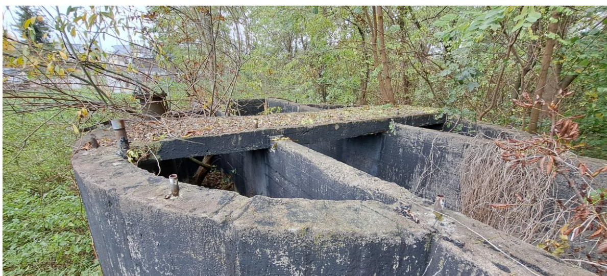
Zdjęcie istniejącego żelbetowego zbiornika Imhoffa – do rozbiórki.
