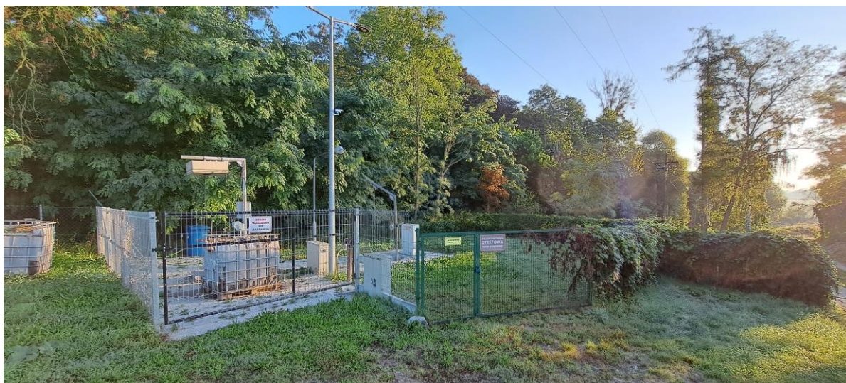
Zdjęcie terenu istniejącej przepompowni
