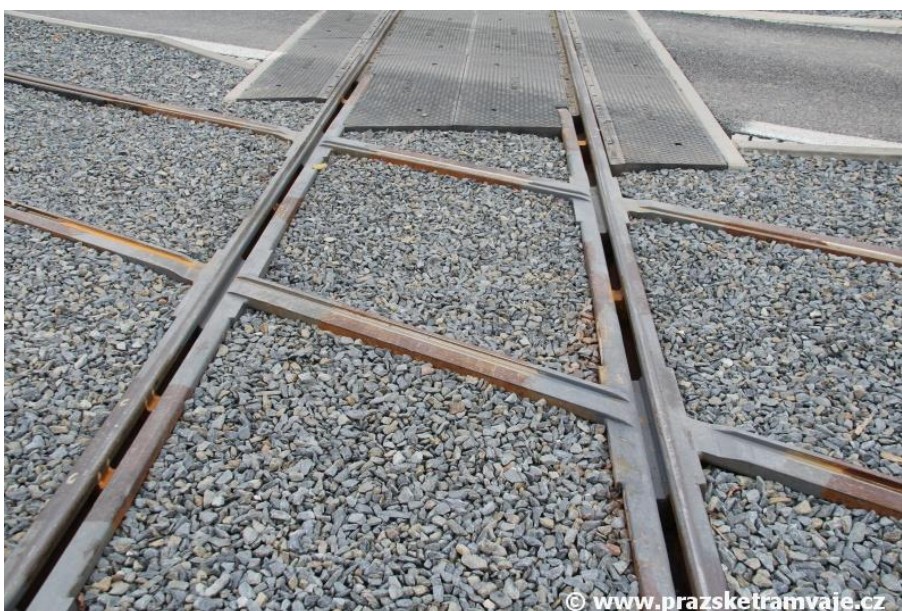
Rys. 7.2.5.2. Rozwiązanie „B” – skrzyżowanie torów kolejowych (pionowo na rysunku) z przejazdem tramwajów (poziomo na rysunku) obrzeżem koła po główce szyny toru kolejowego [Fot. Petr Špitálský, https://www.prazsketramvaje.cz , 2013]
