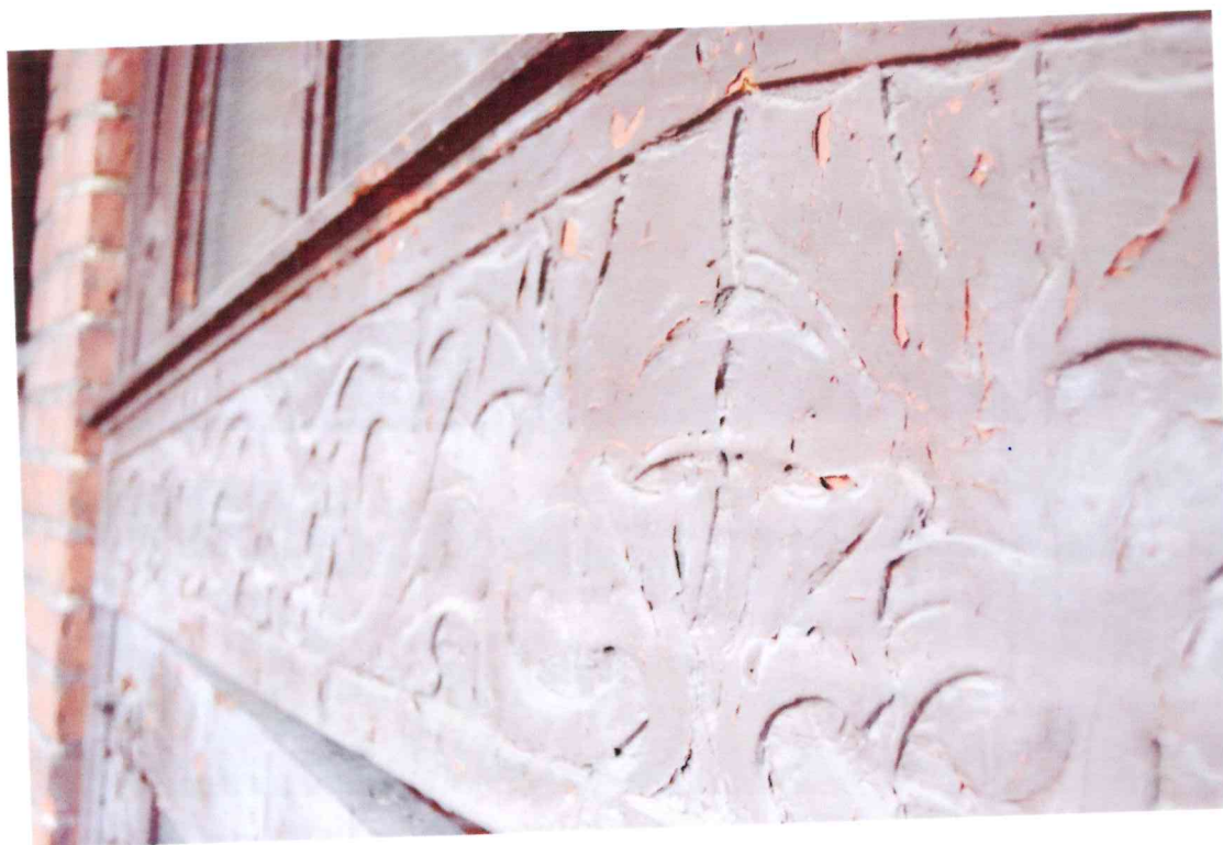
Fot.13 Stolarka drzwiowa- elewacja frontowa, zbliżenie- stan przed konserwacją. Fot. B. Kwasiborska
