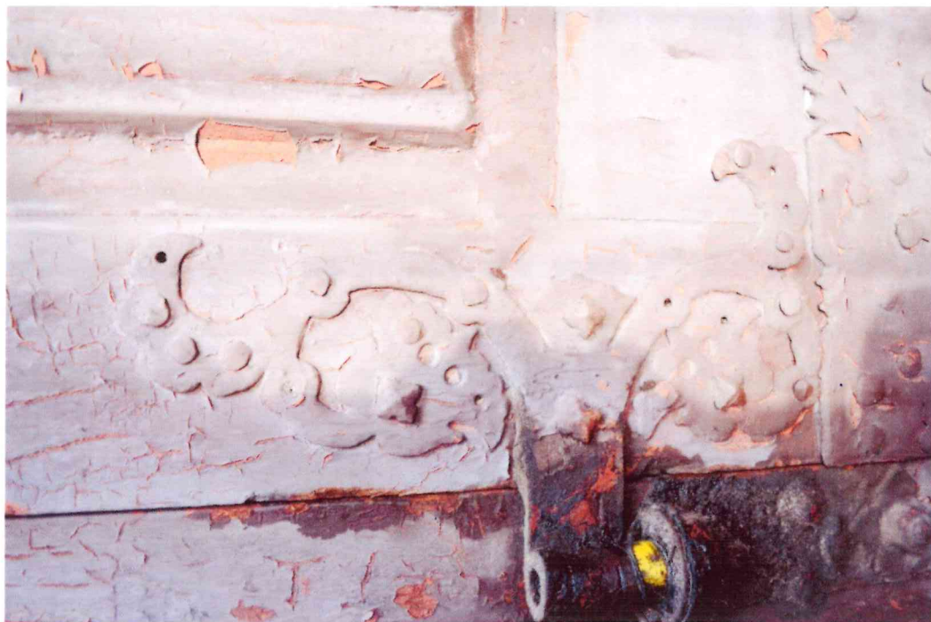
Fot.3 Stolarka drzwiowa- elewacja frontowa, zbliżenie na detal- stan przed konserwacją. Fot. B. Kwasiborska
