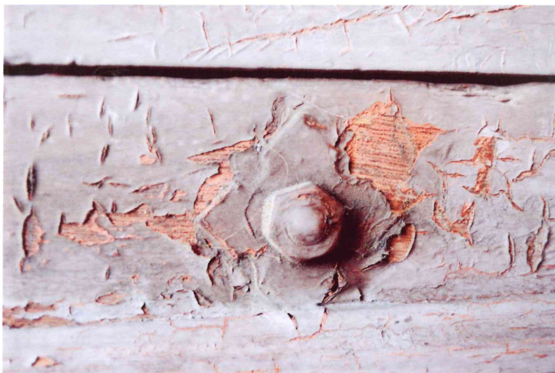
Fot.6 Stolarka drzwiowa- elewacja frontowa, zbliżenie na detal- stan przed konserwacją. Fot. B. Kwasiborska
