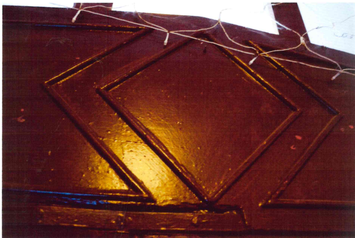
Fot.21 Stolarka drzwiowa- elewacja frontowa, zbliżenie na detal- stan przed konserwacją. Fot. B. Kwasiborska
