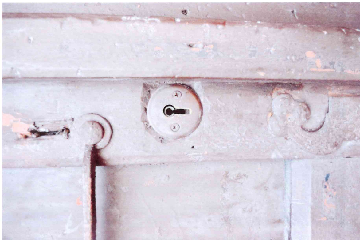
Fot.27 Stolarka drzwiowa- elewacja tylna, zbliżenie na detal- stan przed konserwacją. Fot. B. Kwasiborska
