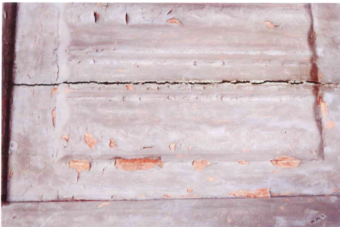
Fot.5 Stolarka drzwiowa- elewacja frontowa, zbliżenie na detal- stan przed konserwacją. Fot. B. Kwasiborska
