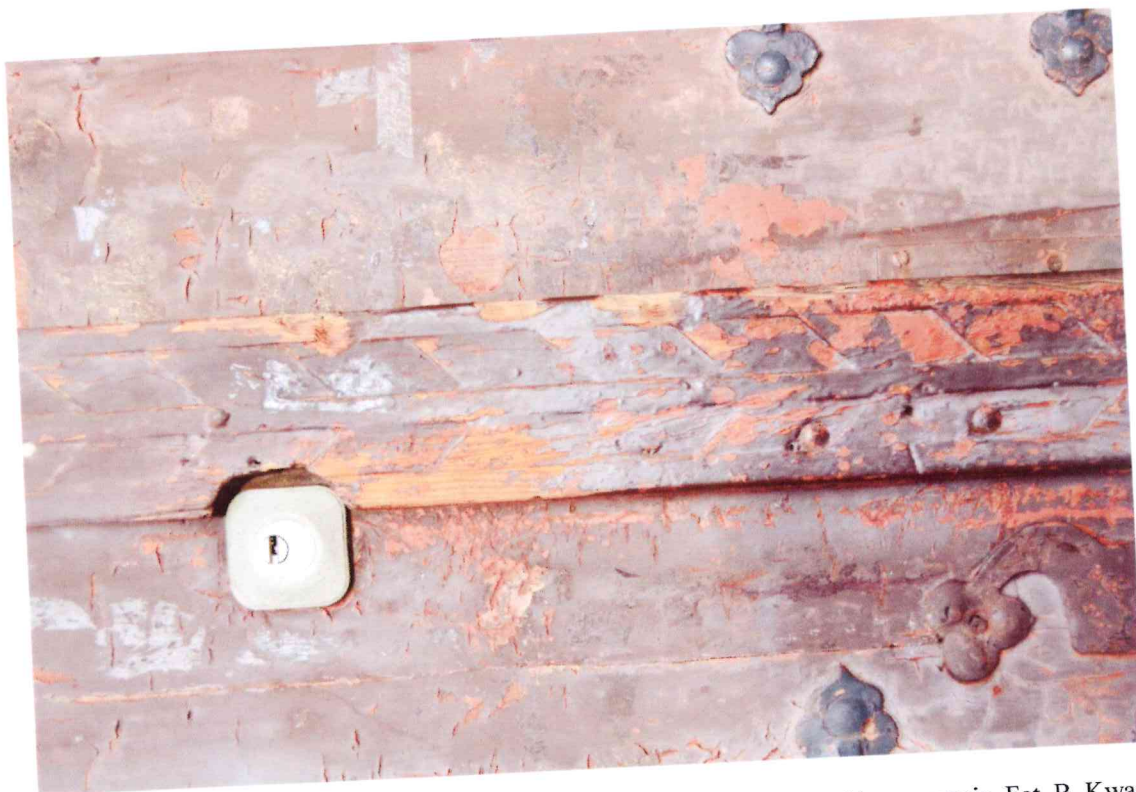
Fot.9 Stolarka drzwiowa- elewacja frontowa, zbliżenie na detal- stan przed konserwacją. Fot. B. Kwasiborska
