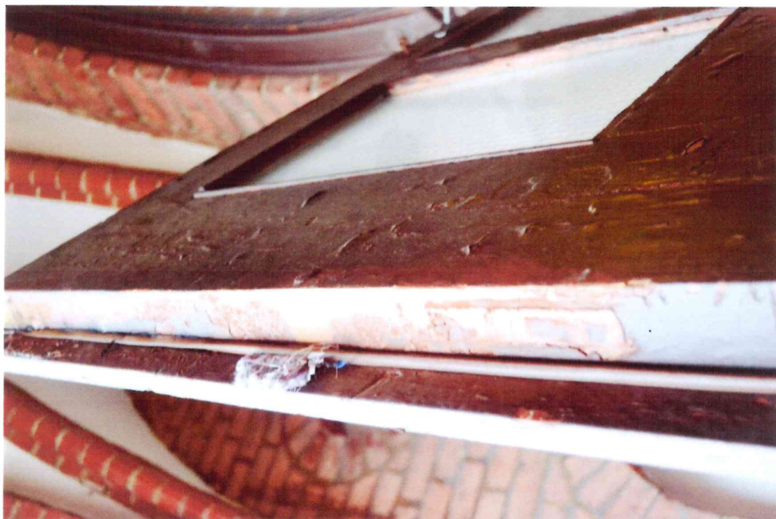
Fot.14 Stolarka drzwiowa- elewacja frontowa, zbliżenie- stan przed konserwacją. Fot. B. Kwasiborska
