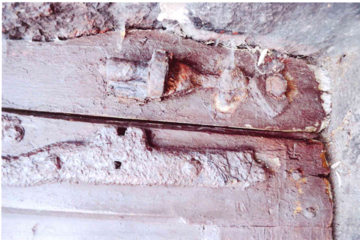
Fot.23 Stolarka drzwiowa- elewacja tylna, zbliżenie na detal- stan przed konserwacją. Fot. B. Kwasiborska
