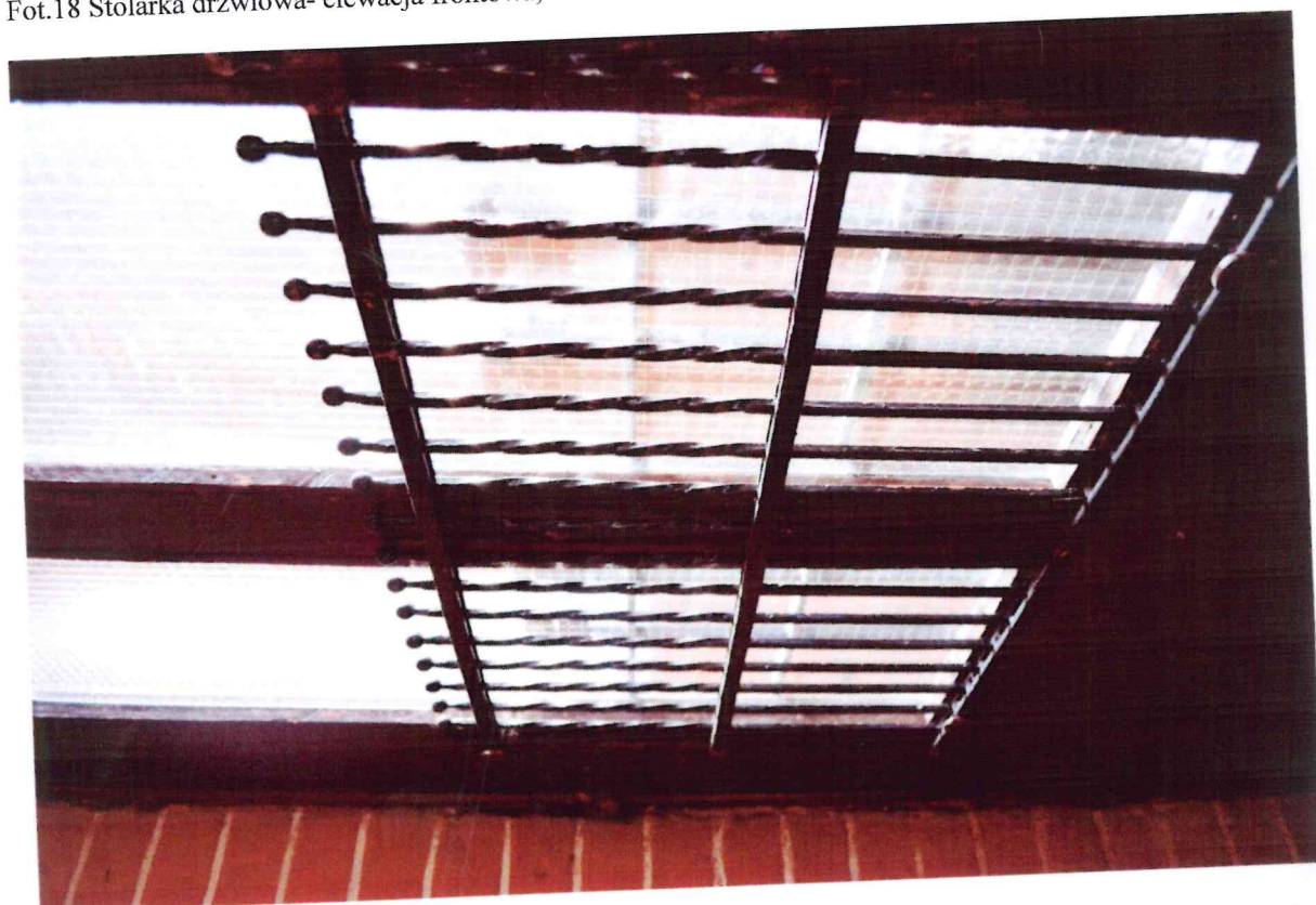
Fot.19 Stolarka drzwiowa- elewacja frontowa, zbliżenie na detal- stan przed konserwacją. Fot. B. Kwasiborska
