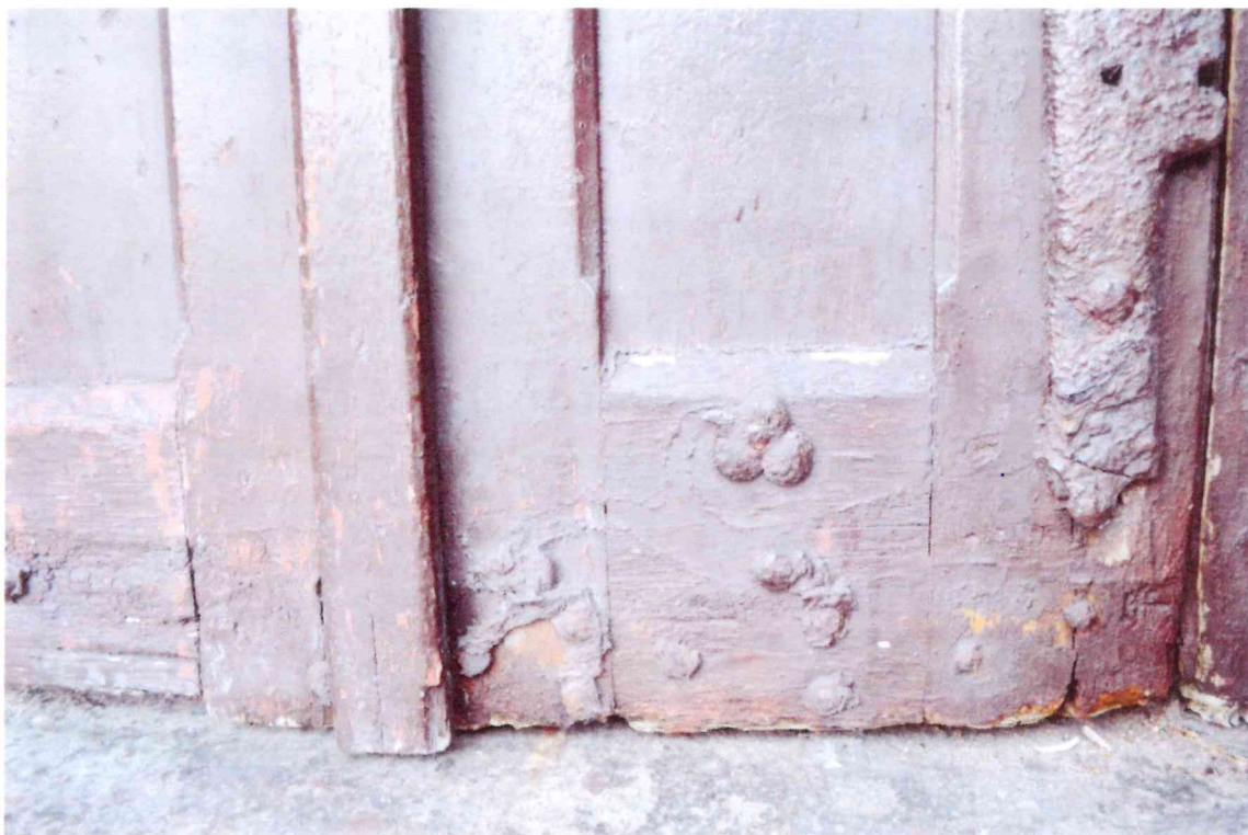
Fot.24 Stolarka drzwiowa- elewacja tylna, zbliżenie na detal- stan przed konserwacją. Fot. B. Kwasiborska
