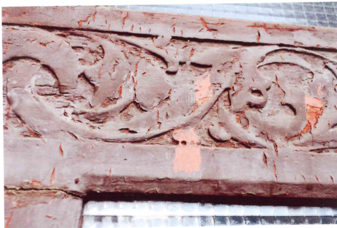
Fot.8 Stolarka drzwiowa- elewacja frontowa, zbliżenie na detal- stan przed konserwacją. Fot. B. Kwasiborska
