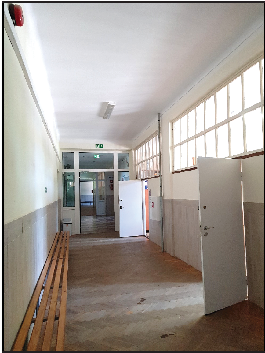
Fot.5. Korytarz szkolny Źródło: autor opracowania.
