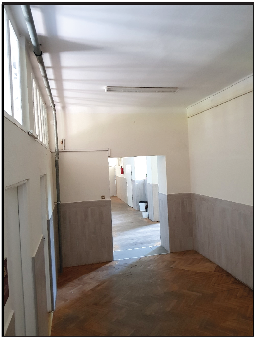
Fot.4. Łącznik między budynkami. Źródło: autor opracowania.
