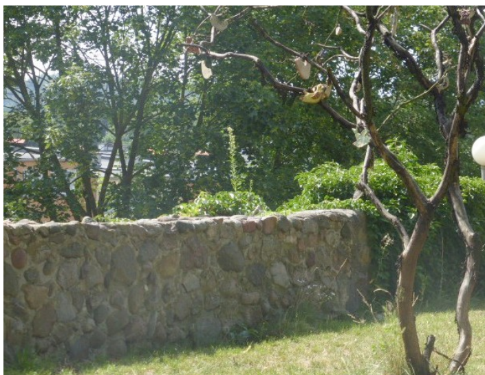
Fot.25 Mur od strony wewnętrznej
