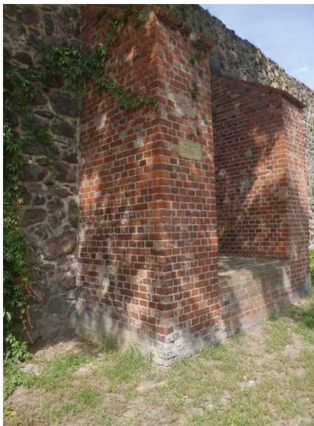
Fot.27 Partie ceglane odcinka piątego
