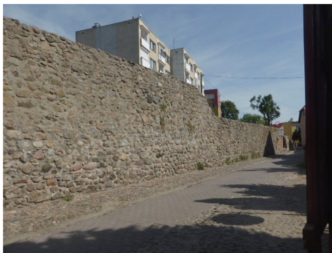
Fot.4 Widok na drugi odcinek murów
