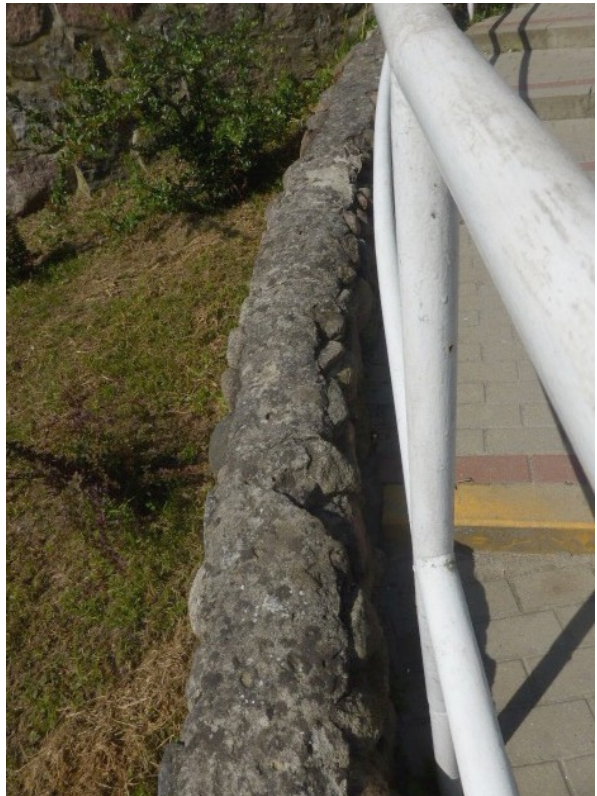
Fot.15 Zamknięcie muru cementem
