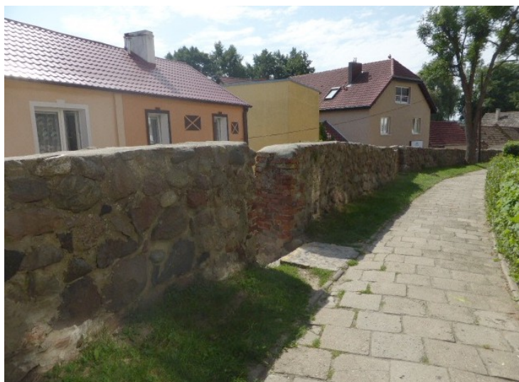
Fot.19 Górna partia odcinka drugiego
