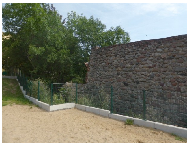
Fot.33 Zamknięcie muru od strony boiska
