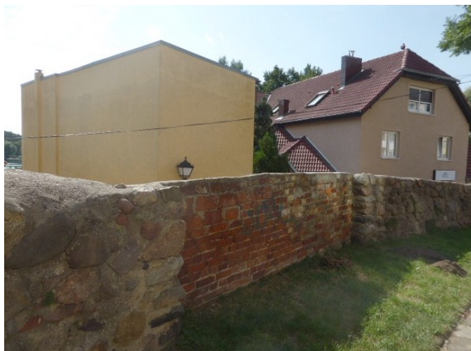
Fot.7 Widok od ścieżki na fragmnet ceglany
