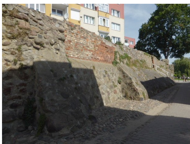
Fot.6 Krótki odcinek ceglany pomiędzy kamieniami granitowymi
