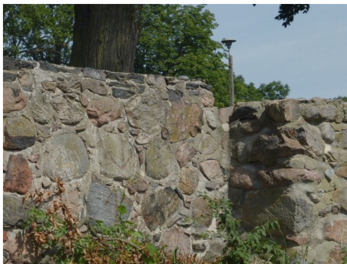
Fot.24 Mur granitowy odcinka czwartego
