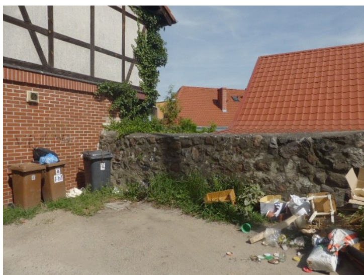
Fot.22 Odcinek trzeci odsłonięty
