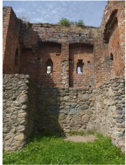
Fot.29 Czatownia odcinka piątego
