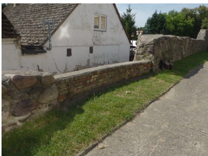
Fot.9 Fragment odcinka ceglanego
