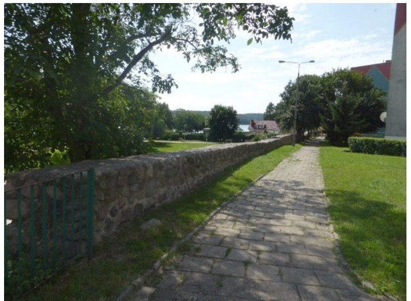
Fot.16 Widok na odcinek od strony ścieżki
