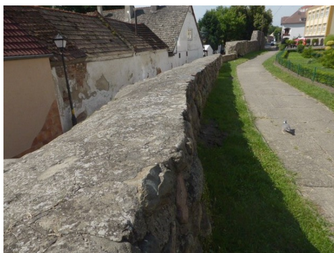
Fot.8 Zamknięcie muru od góry cementem
