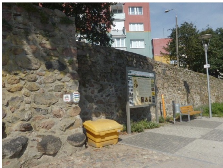
Fot.12 Widoczne na powierzchni murów glony i porosty
