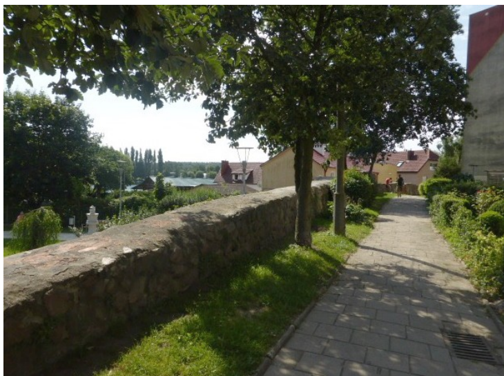
Fot.18 Widok korony murów zamkniętej cementem
