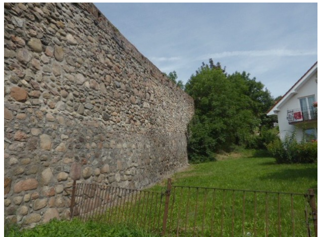
Fot.30 Fragment wysokiego muru granitowego
