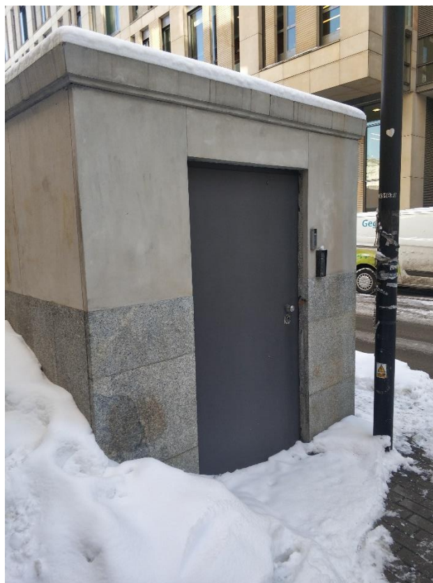
Rys. 1. Widok drzwi podlegających opracowaniu.
