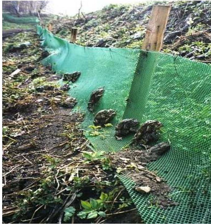
Rys. 20. Zabezpieczenia używane na etapie budowy.
