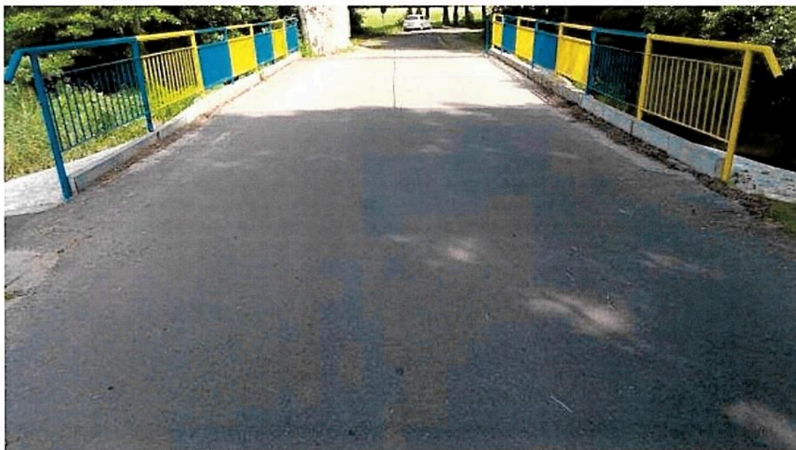
Fot. 1.7 Widok układu drogowego na obiekcie.
