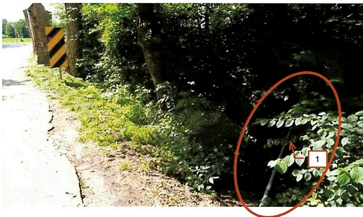
Fot. 2.65 Oznakowanie na dojeździe od strony północnej. Przewrócony znak drogowy (1).
