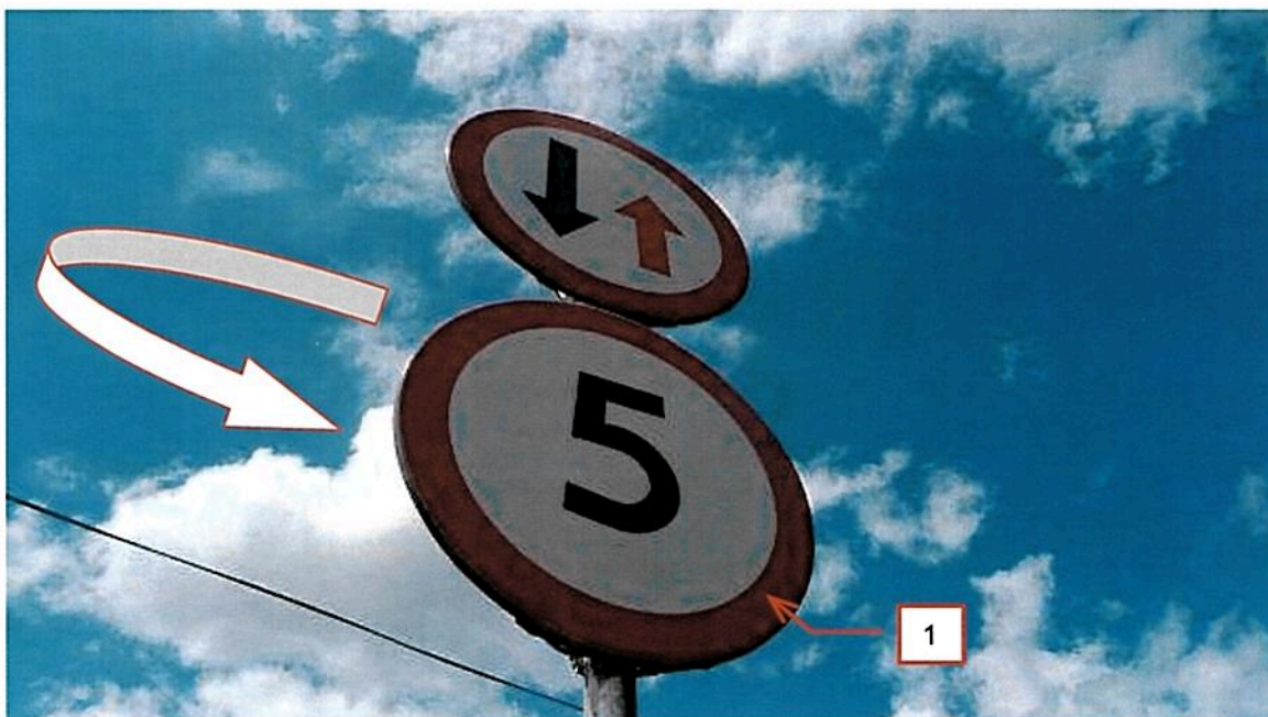
Fot. 2.64 Oznakowanie na dojeździe od strony południowej. Kierunek oznakowania uniemożliwiający odczytanie z nadjeżdżających pojazdów (1).
