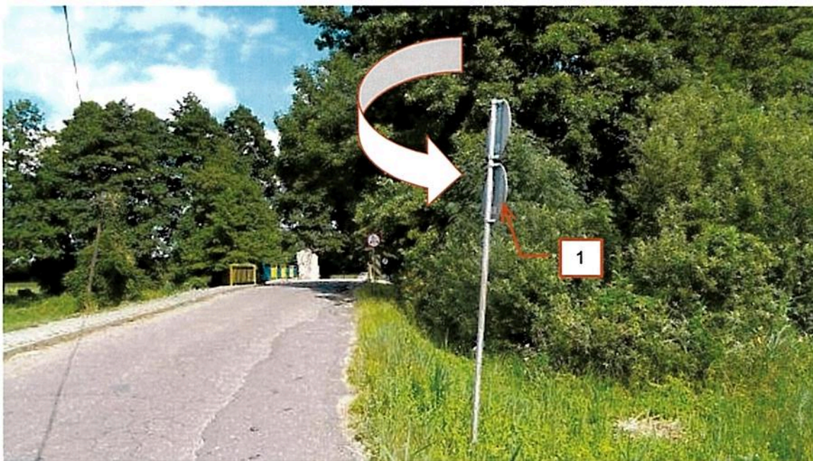
Fot. 2.63 Oznakowanie na dojeździe od strony południowej. Kierunek oznakowania pionowego uniemożliwiający jego odczytanie (1).
