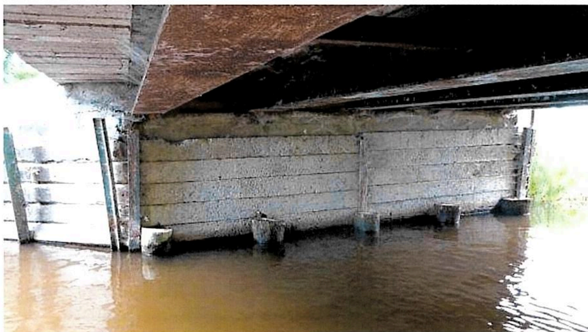
Fot. 1.5 Widok na przyczółek południowy mostu.
