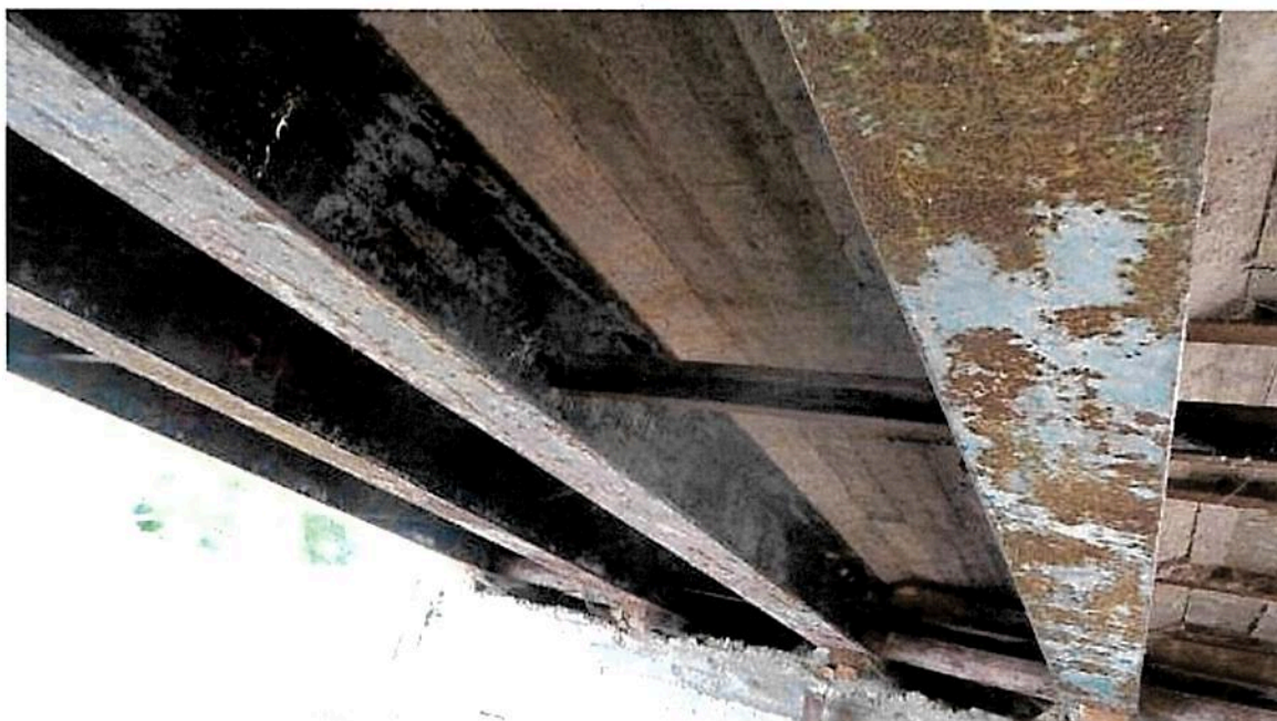
Fot. 1.3 Widok spodu ustroju nośnego.
