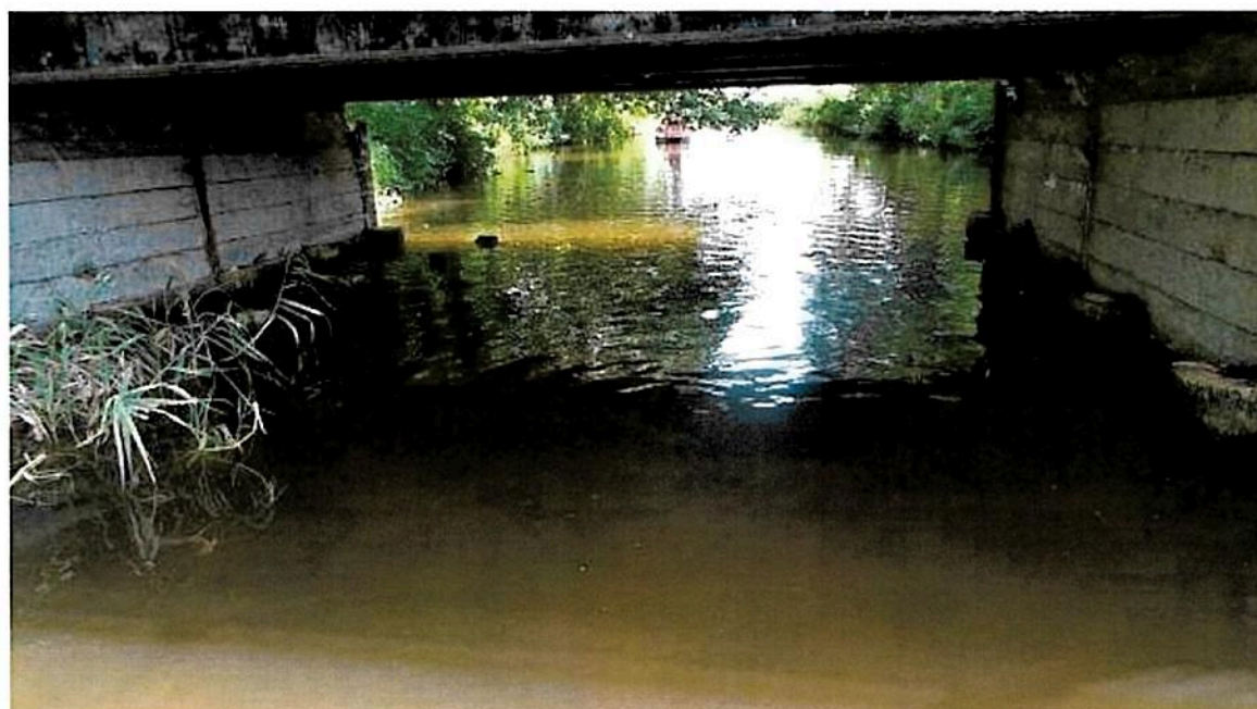
Fot. 1.6 Widok przestrzeni pod obiektem.
