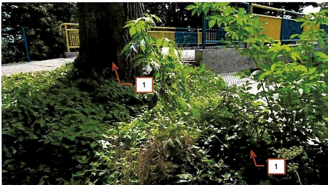
Fot. 2.5 Skarpa nasypu od strony północno-zachodniej. Wegetacja roślin (drzew, krzewów) na powierzchni nasypu (1).
