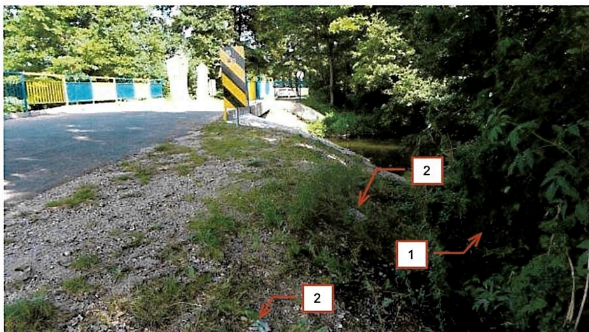
Fot. 2.2 Skarpa nasypu od strony południowo-wschodniej. Wegetacja roślin (drzew, krzewów) na powierzchni nasypu (1). Lokalne zanieczyszczenia (śmieci) (2).
