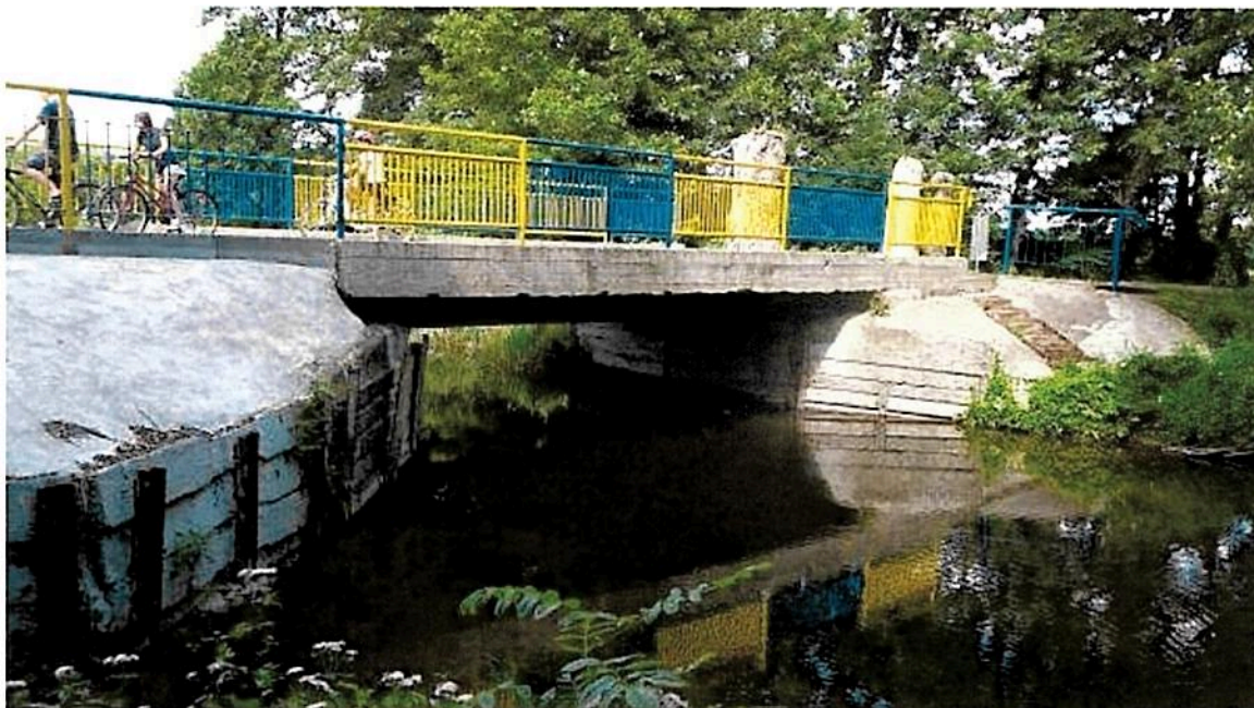
Fot. 1.1 Widok na obiekt od strony wschodniej.
