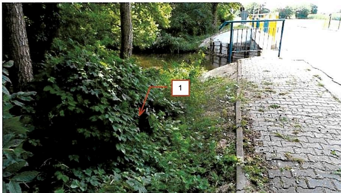
Fot. 2.4 Skarpa nasypu od strony północno-wschodniej. Wegetacja roślin (drzew, krzewów) na powierzchni nasypu (1).
