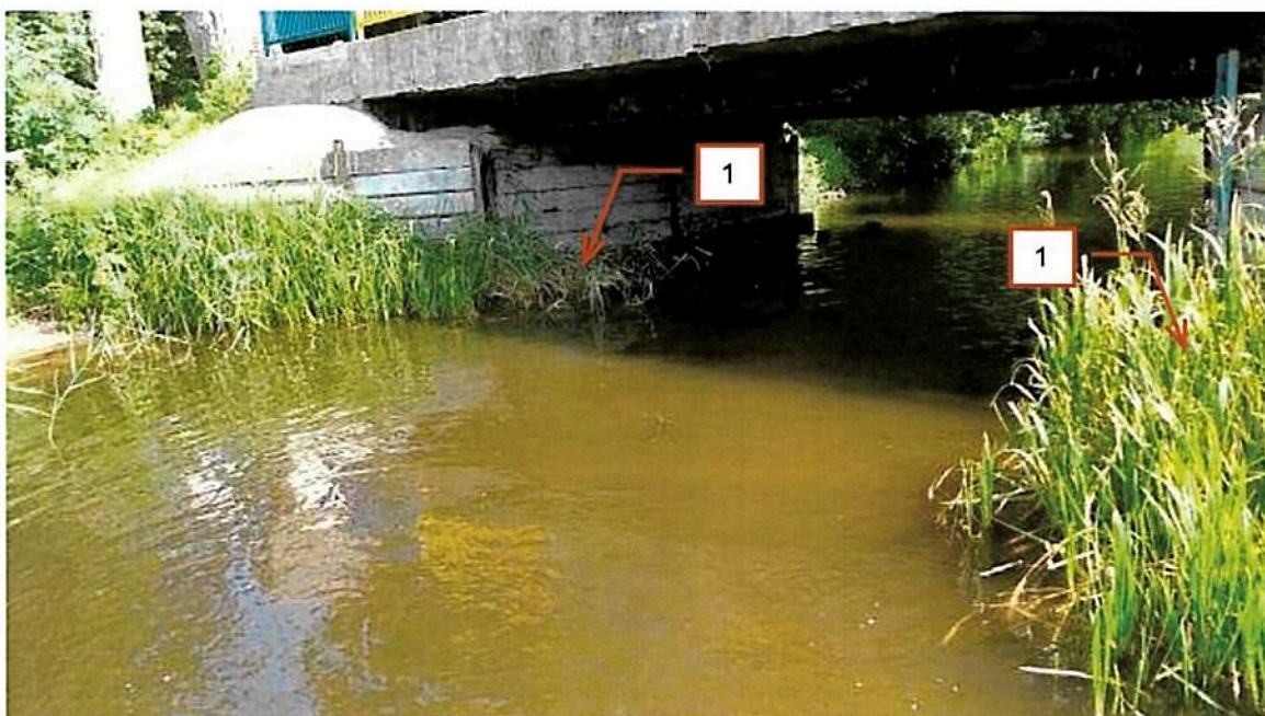
Fot. 2.62 Przestrzeń pod obiektem (widok od strony zachodniej). Wegetacja roślinności (1).
