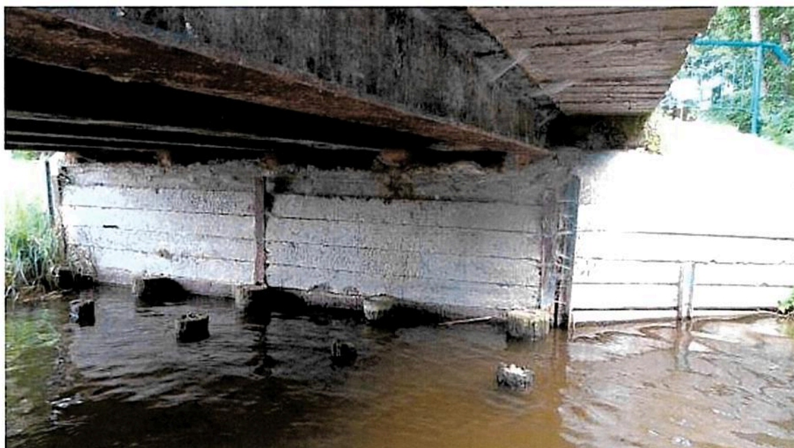
Fot. 1.4 Widok na przyczółek północny mostu.
