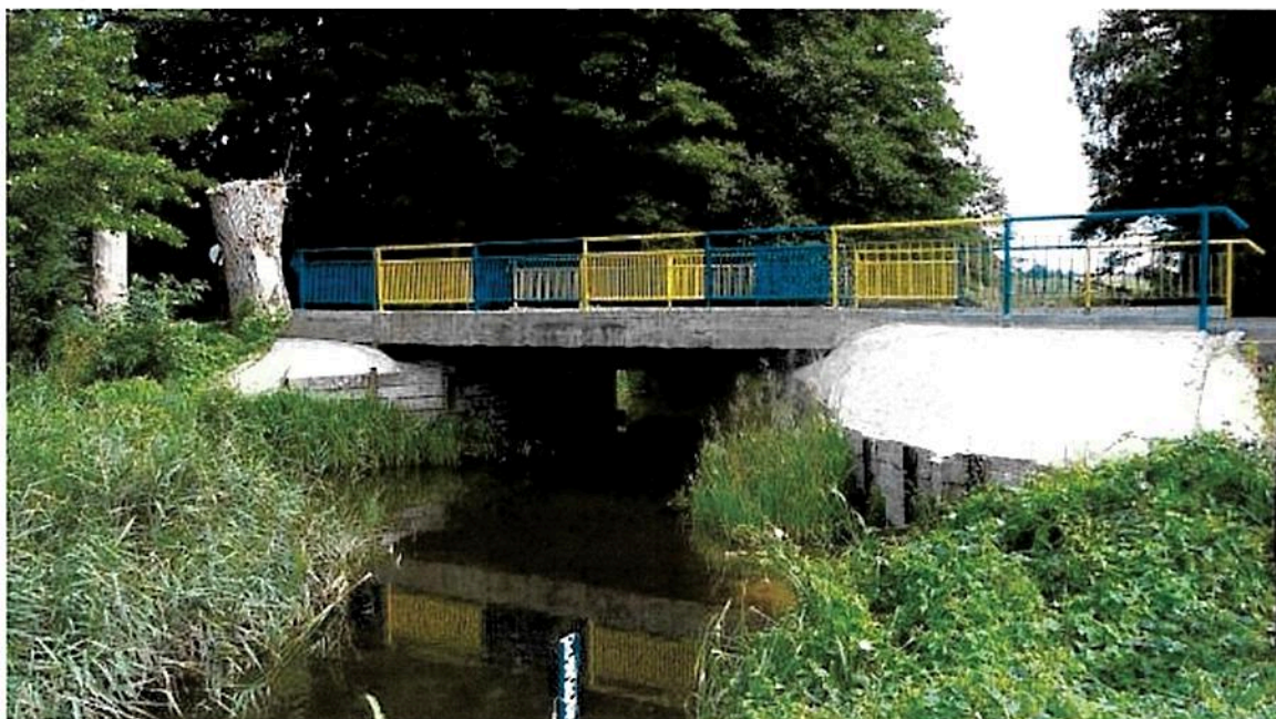
Fot. 1.2 Widok na obiekt od strony zachodniej.
