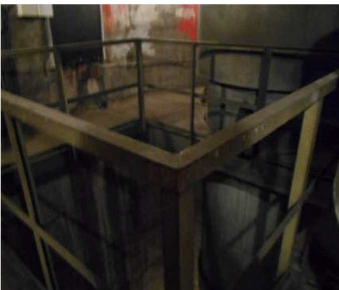
Fot. 24 - poziom 79,60m
