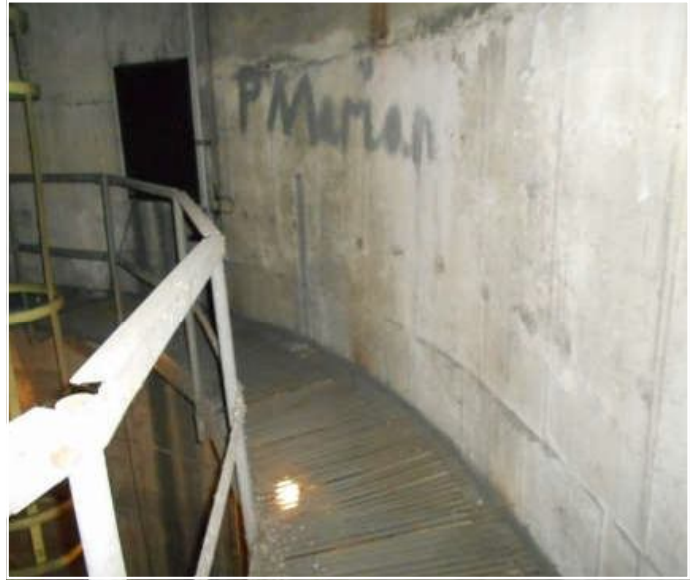
Fot. 9 - poziom 42,10m
