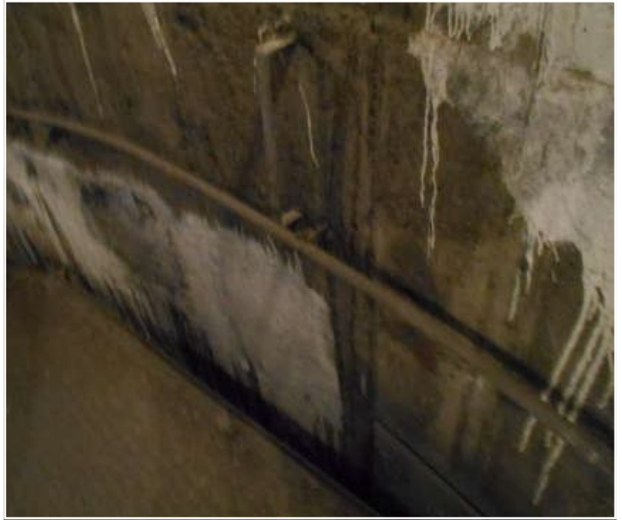
Fot. 27 - poziom 79,60m
