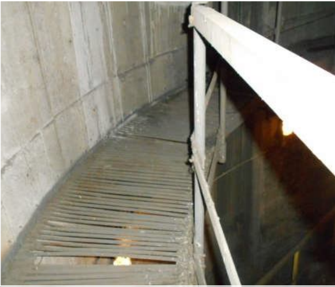
Fot. 8 - poziom 42,10m
