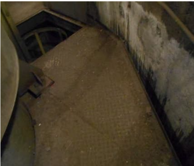
Fot. 28 - poziom 79,60m
