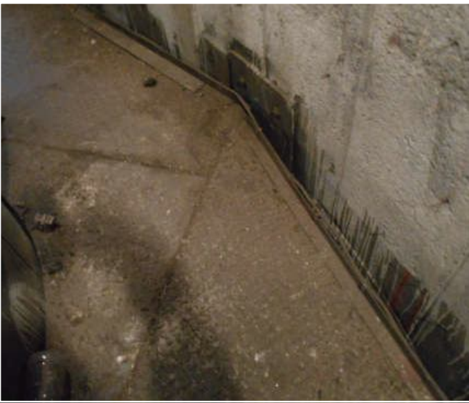
Fot. 32 - poziom 79,60m
