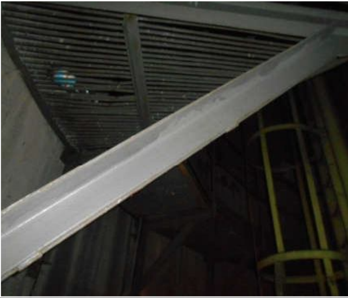
Fot. 15 - poziom 42,10m
