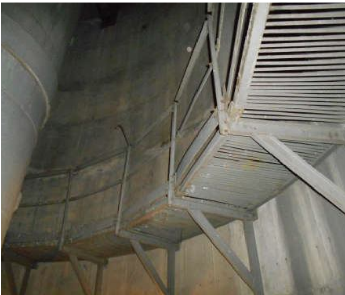
Fot. 4 - poziom 42,10m
