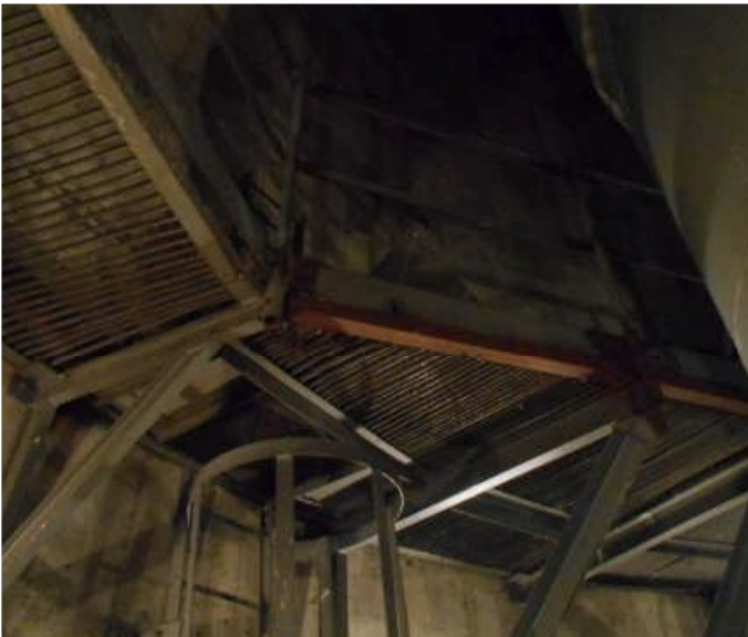
Fot. 6 - poziom 42,10m
