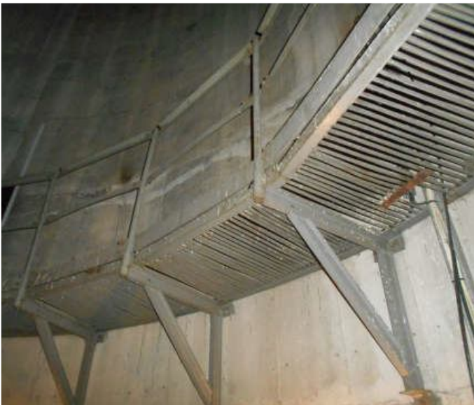
Fot. 5 - poziom 42,10m
