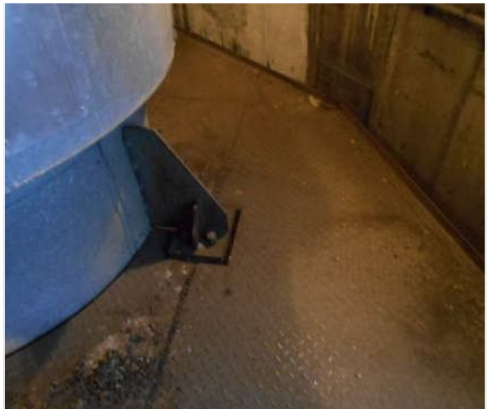
Fot. 29 - poziom 79,60m
