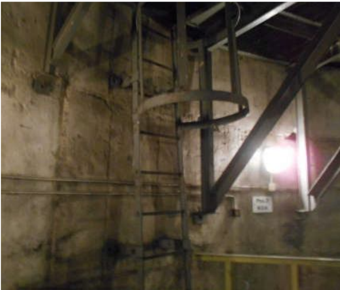
Fot. 19 - poziom 42,10m
