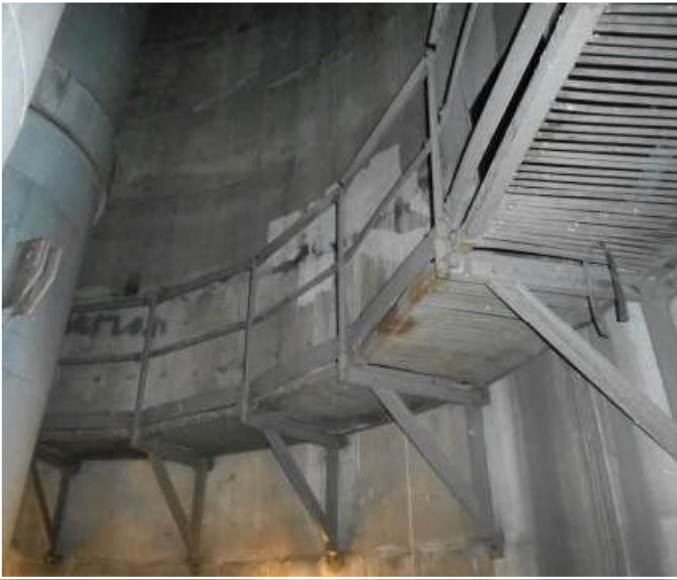
Fot. 3 - poziom 42,10m
