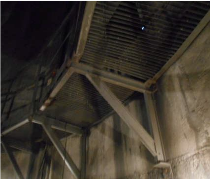
Fot. 14 - poziom 42,10m
