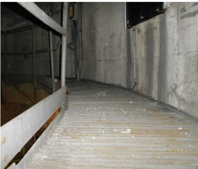
Fot. 12 - poziom 42,10m
