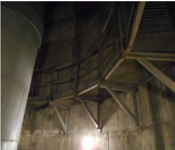
Fot. 17 - poziom 42,10m
