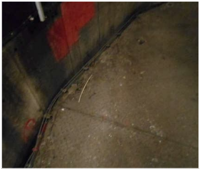
Fot. 33 - poziom 79,60m
