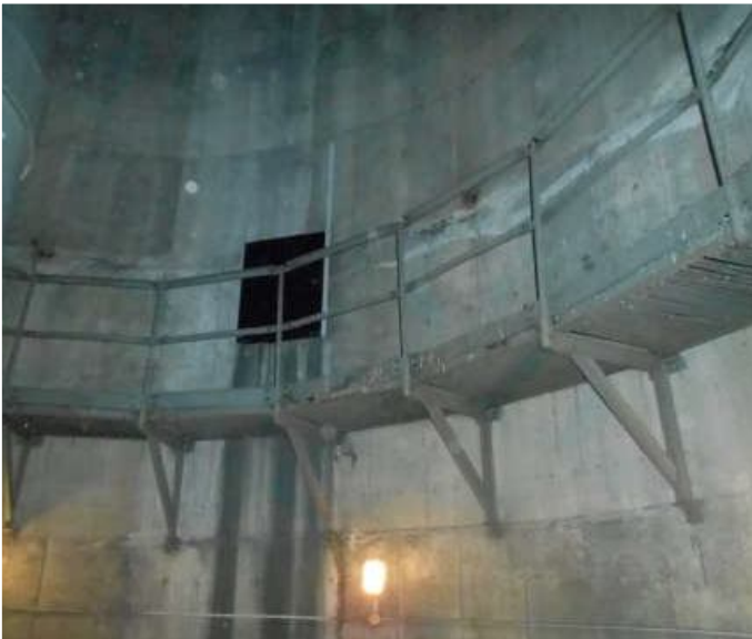
Fot. 7 - poziom 42,10m
