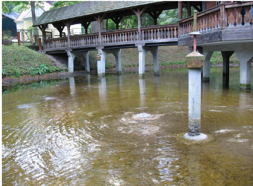
Fot.9 Widok na płytę denną stawu nad ujęciem (pod powierzchnią wody).
