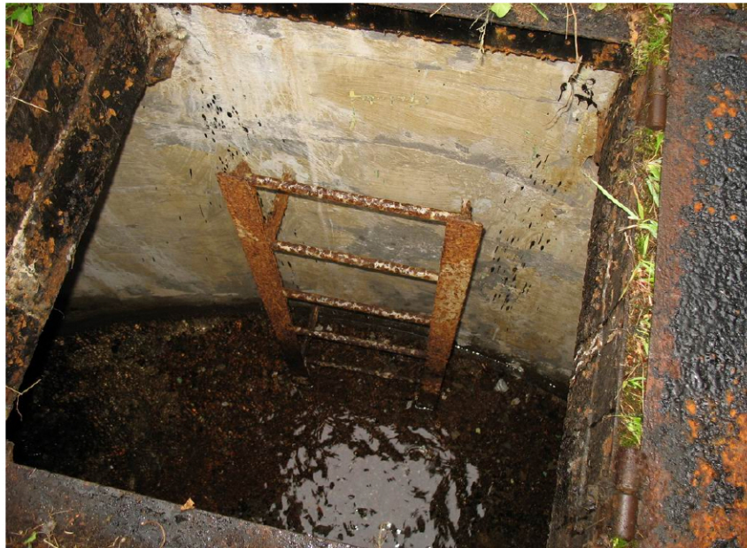
Fot.7 Widok na komorę ujęcia od środka
