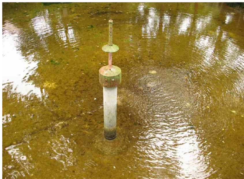
Fot.10 Widok na płytę denną stawu i odpowietrznik złoża ujęcia
