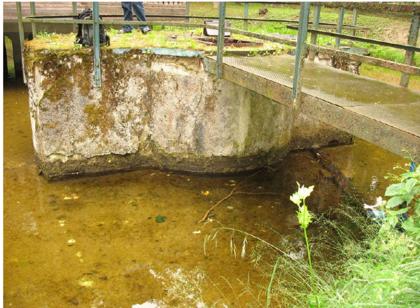
Fot.3 Widok na komorę ujęcia i rozdziału wody
