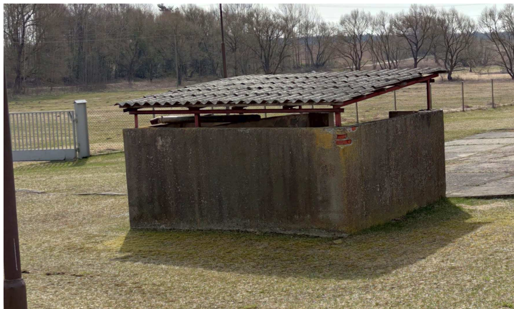
Fot. 6. Istniejącą wiatę śmietnikową o wymiarach 4,0x3,0m przewidziano do rozbiórki.
