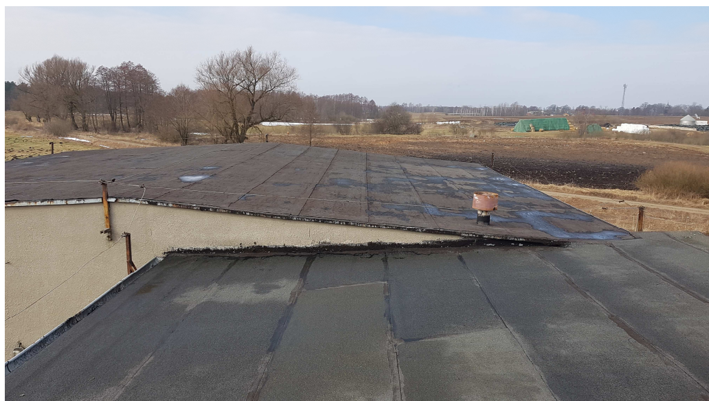
Fot. 3. Dach budynku technologicznego
