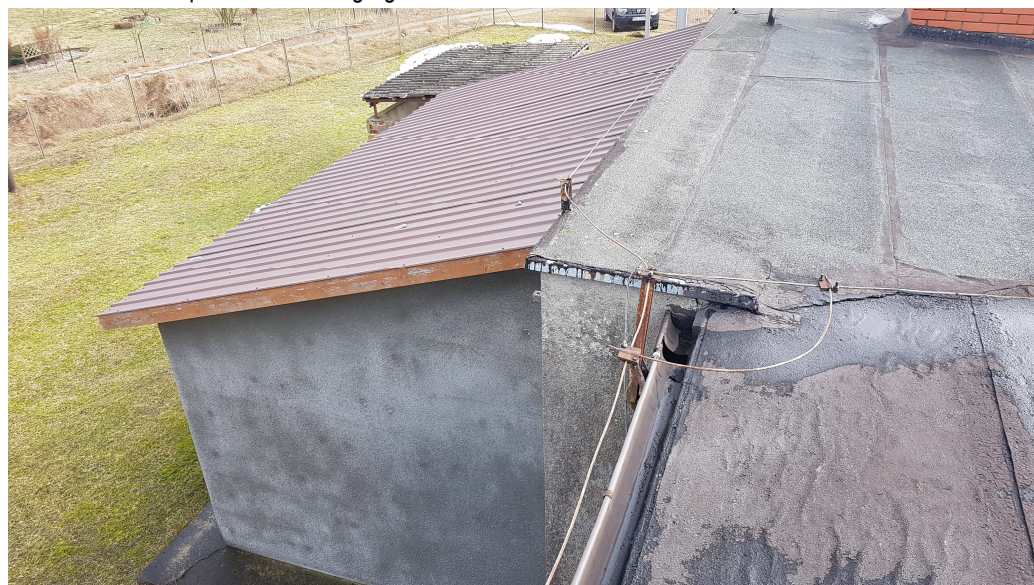
Fot. 4. Zadaszenie pomieszczenia agregatu
