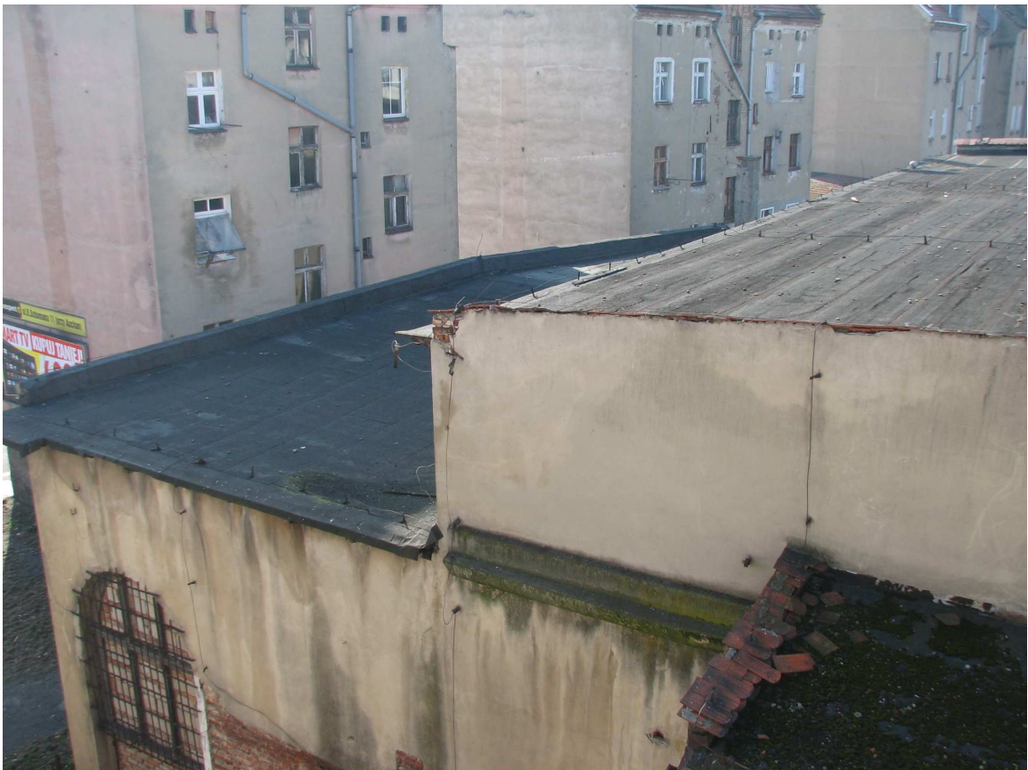
Fot. 23. Dach nad wejściem i pomieszczeniami dodatkowymi.
