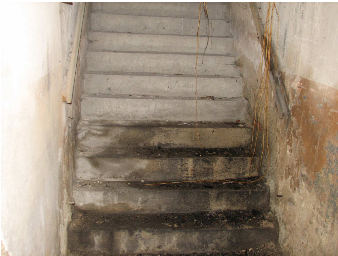
Fot. 15. Widok istniejących schodów na piętro.
