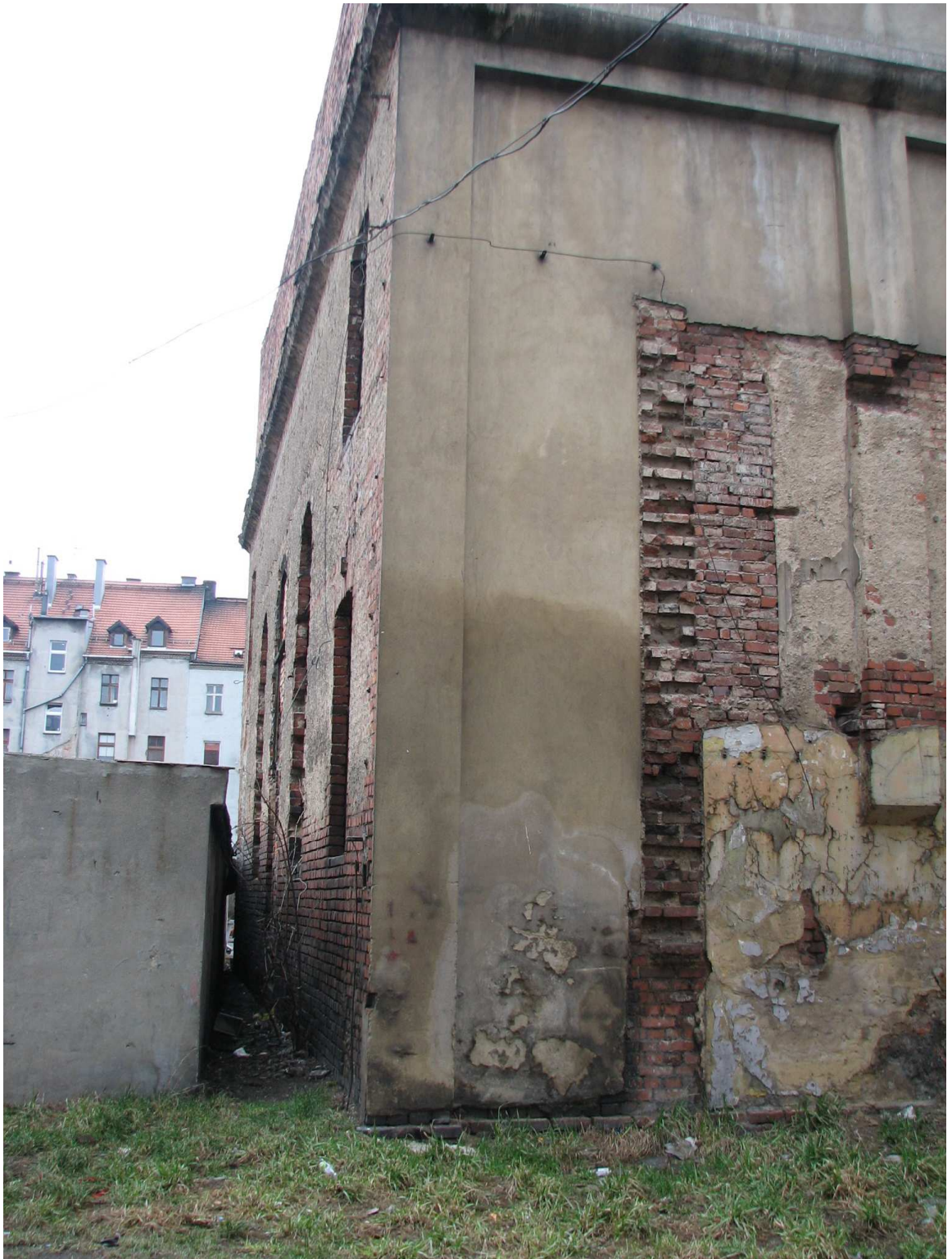
Fot. 21. Elewacja południowa – szczelina do garaży.
