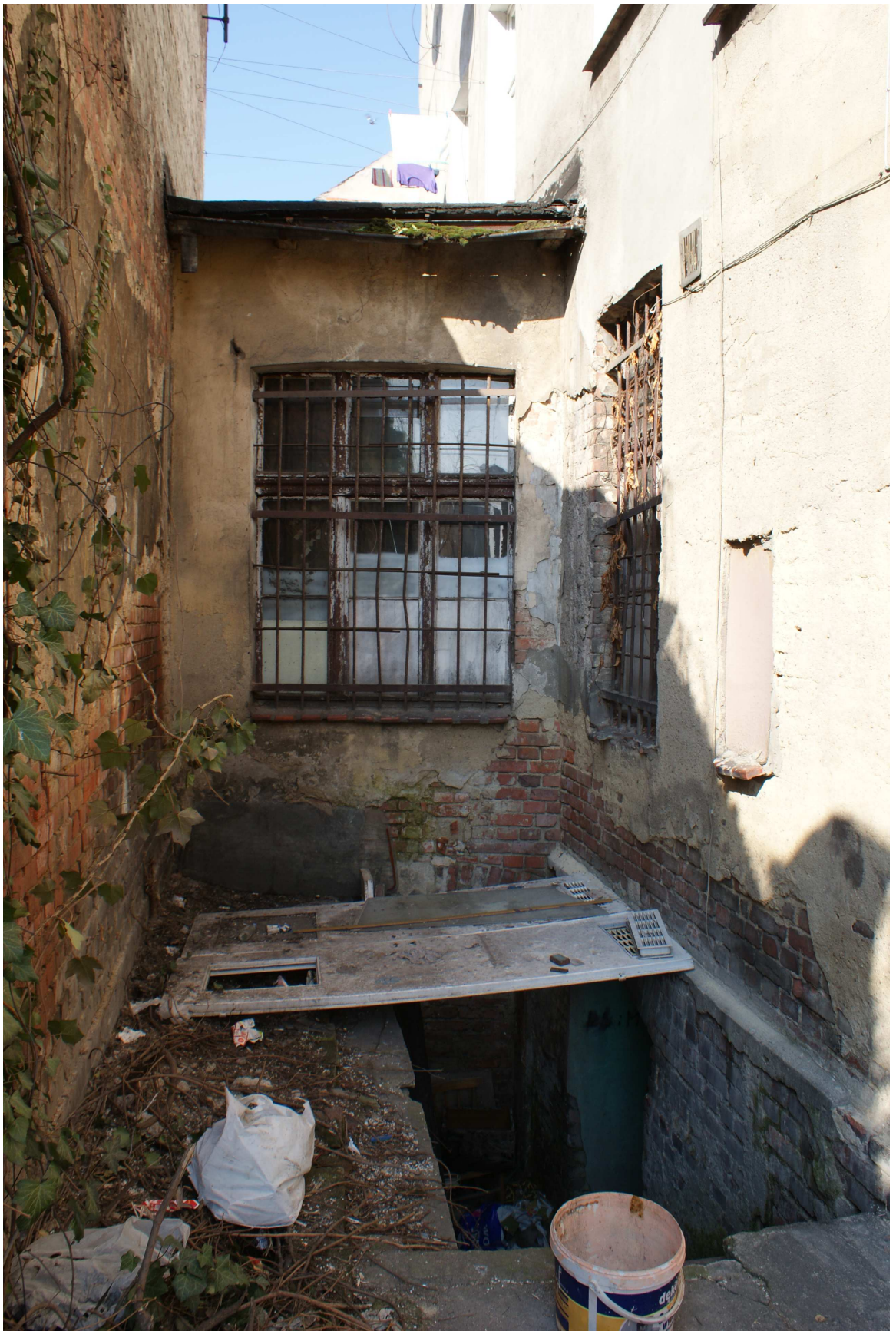
Fot. 24. Widok części łącznika i wejścia do piwnicy od zewnątrz budynku.
