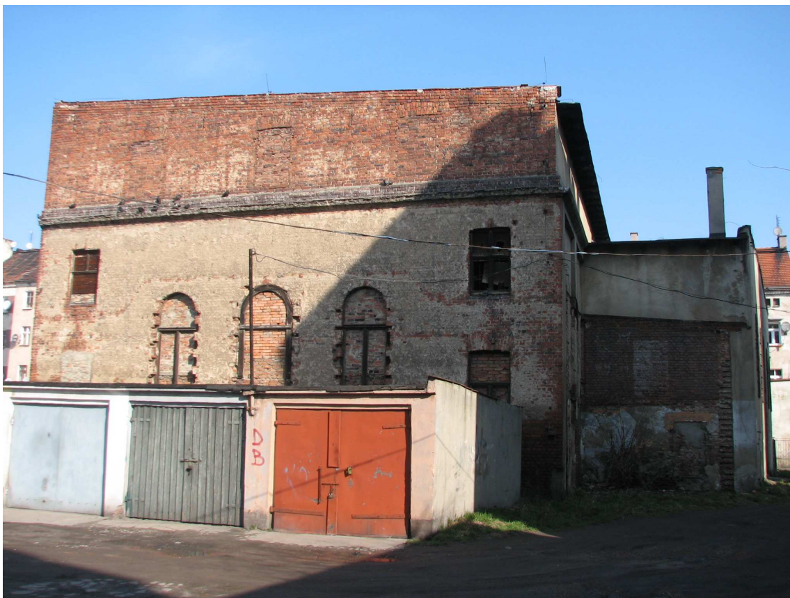
Fot. 19. Elewacja południowa.
