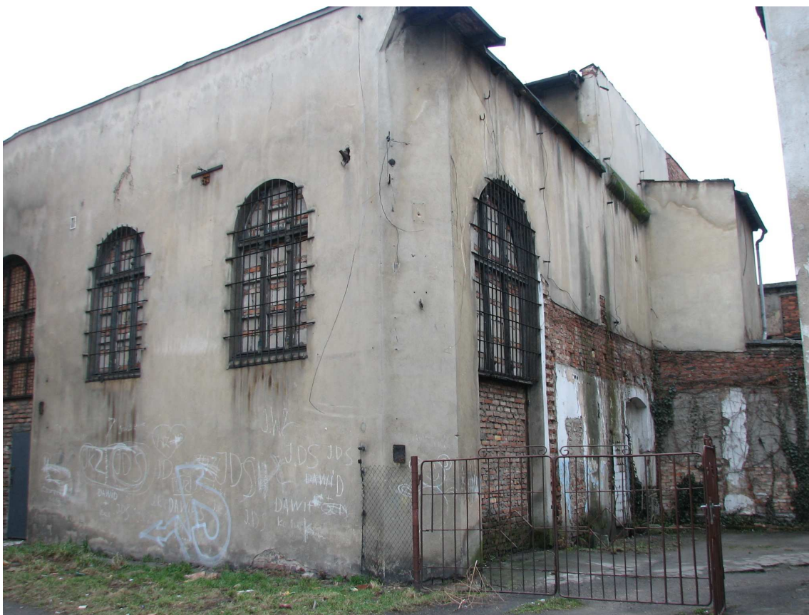
Fot. 16. Elewacja wschodnia i północna.
