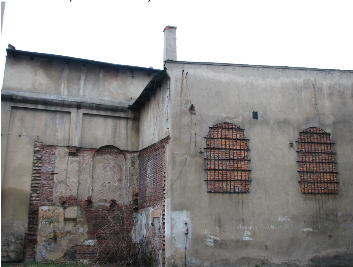
Fot. 18. Elewacja wschodnia.
