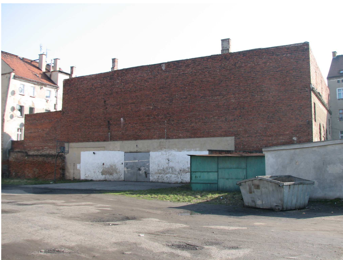
Fot. 20. Elewacja zachodnia.
