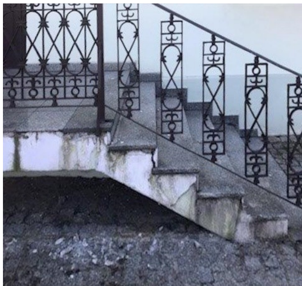
Widok stanu technicznego okładziny schodów i podestu wejściowego
