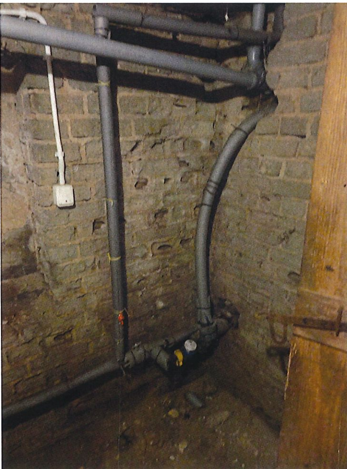
Uszkodzenia murów piwnic.
