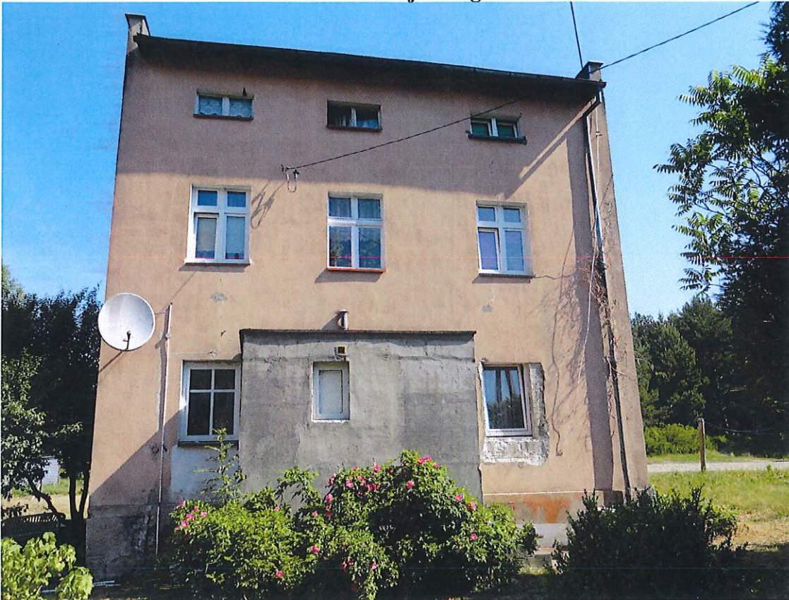
Elewacja frontowa budynku.
