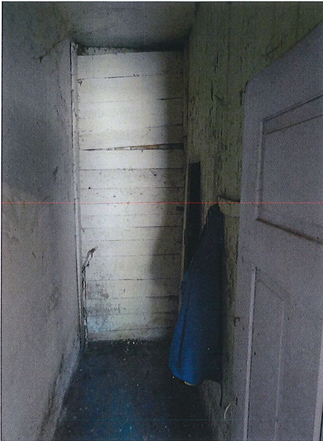
Drewniana obudowa zejścia do piwnicy.
