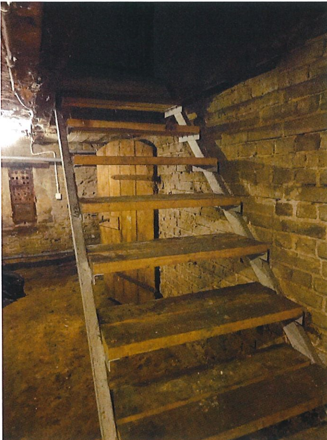
Schody do piwnicy.
