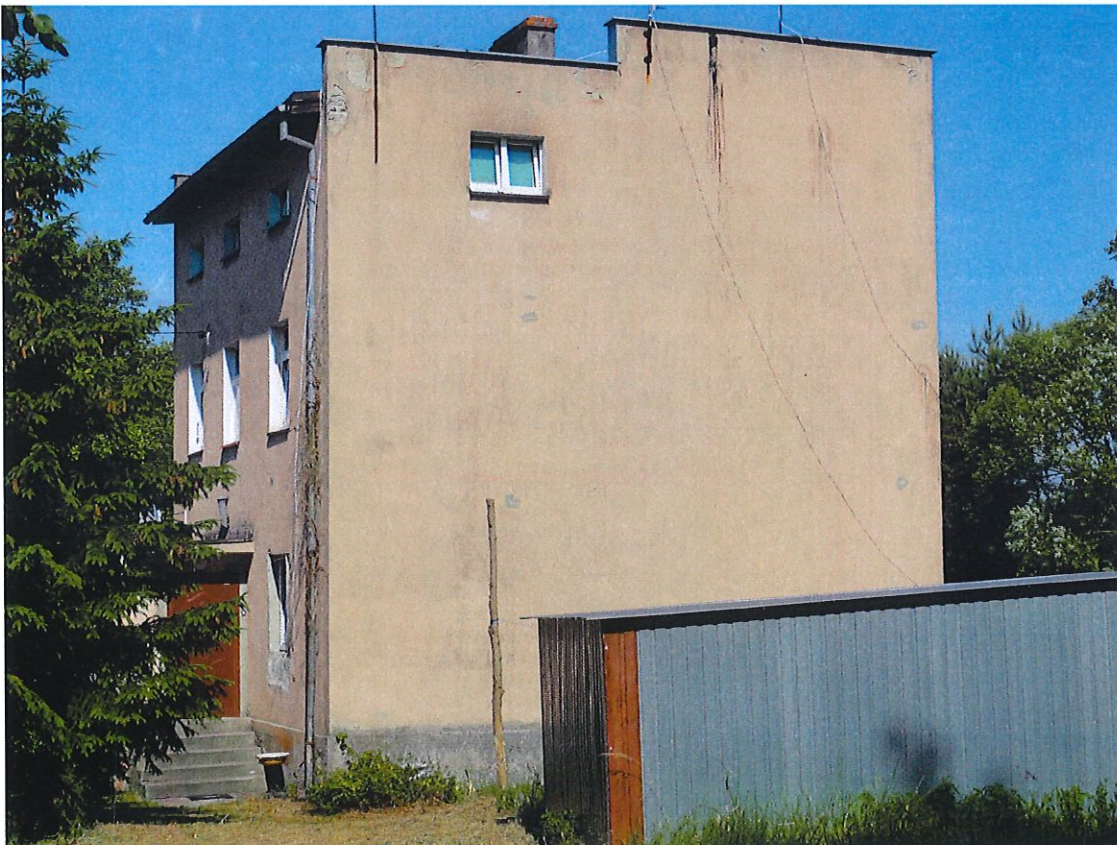
Elewacja boczna budynku.
