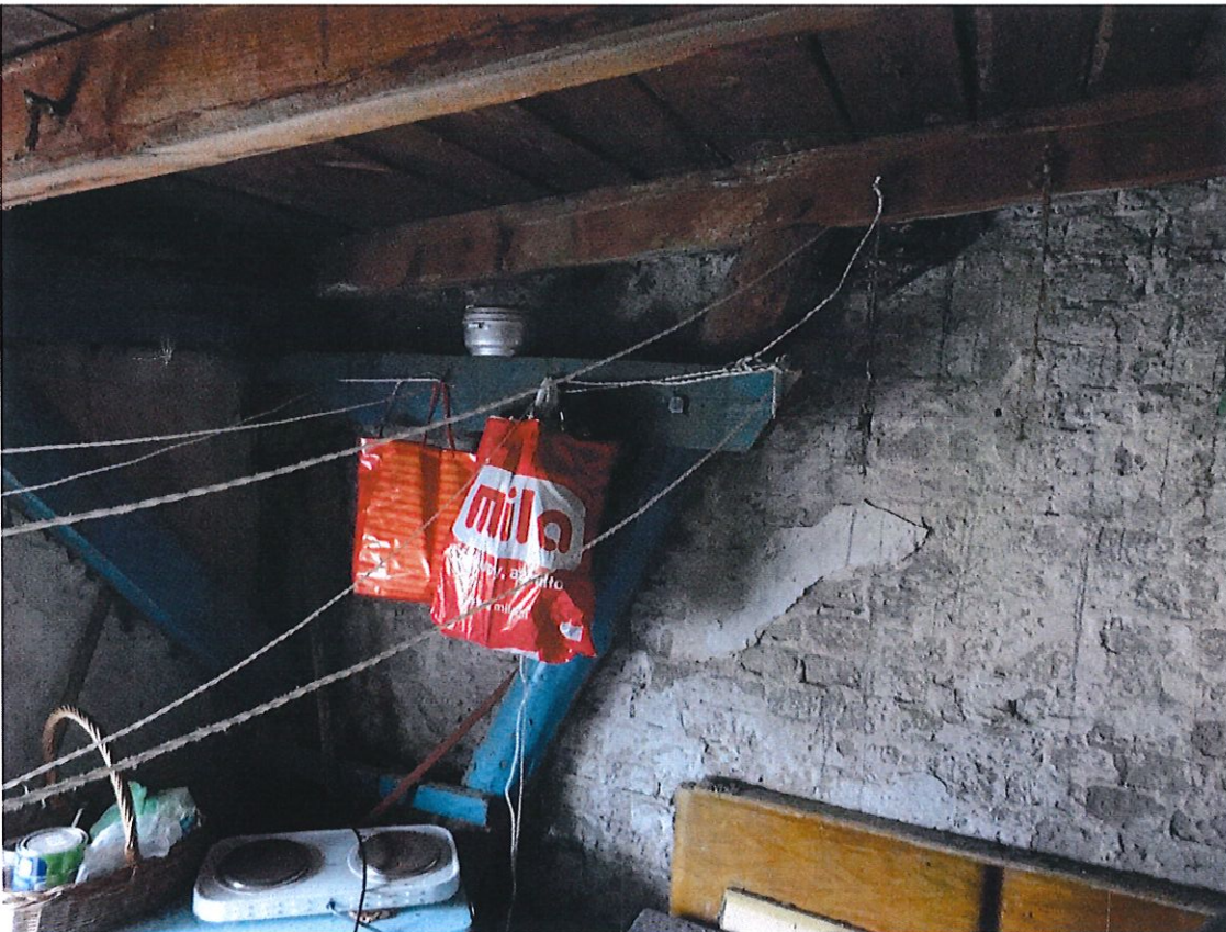
Konstrukcja dachu z drewna okrągłego, mury poddasza.
