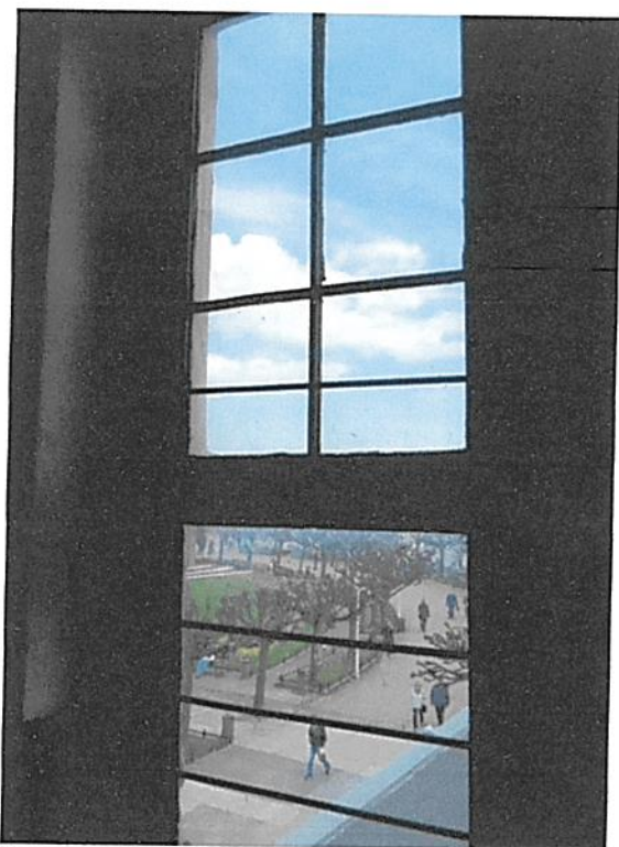
Fot 59 Okno poziom 1
