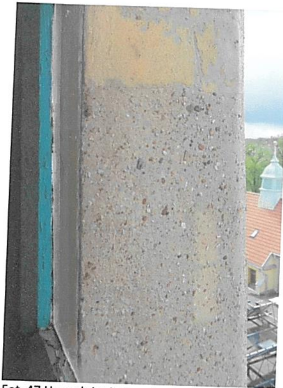
Fot 47 Uzupelnienia z gruboziarnistego tynku przy parapecie
