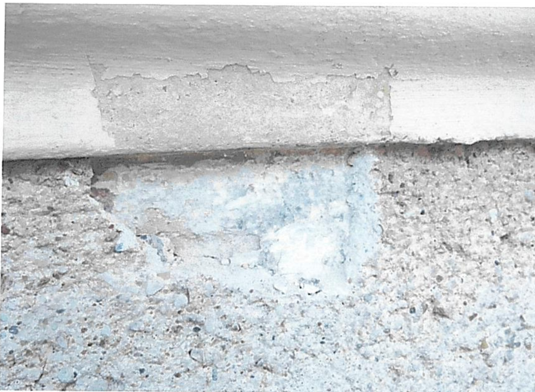
Fot 103 Wykusz wschodni Gładki tynk autorski
