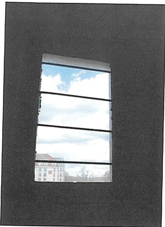
Fot 61 Okno poziom 2
