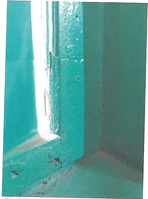
Fot 72 Okno poziom 11 – reperacje ramiaka
