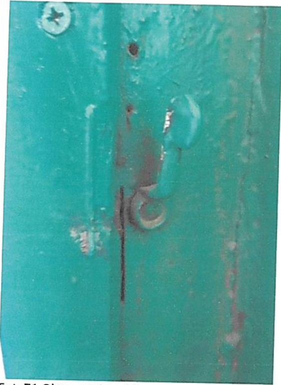
Fot 71 Okno poziom 11
