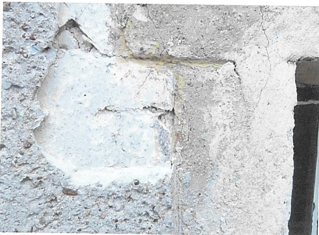
Fot 102 Okno wykusza , strona północna Odkrywka pokazująca
