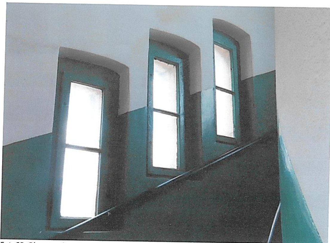
Fot 68 Okno poziom 8
