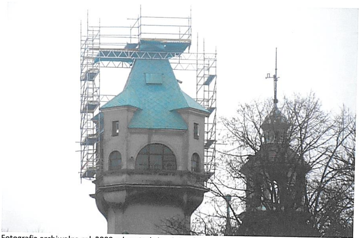
Fotografia archiwalna rok 2008 rekonstrukcja wieżyczki i wykonanie dachu pokrytego blachą
