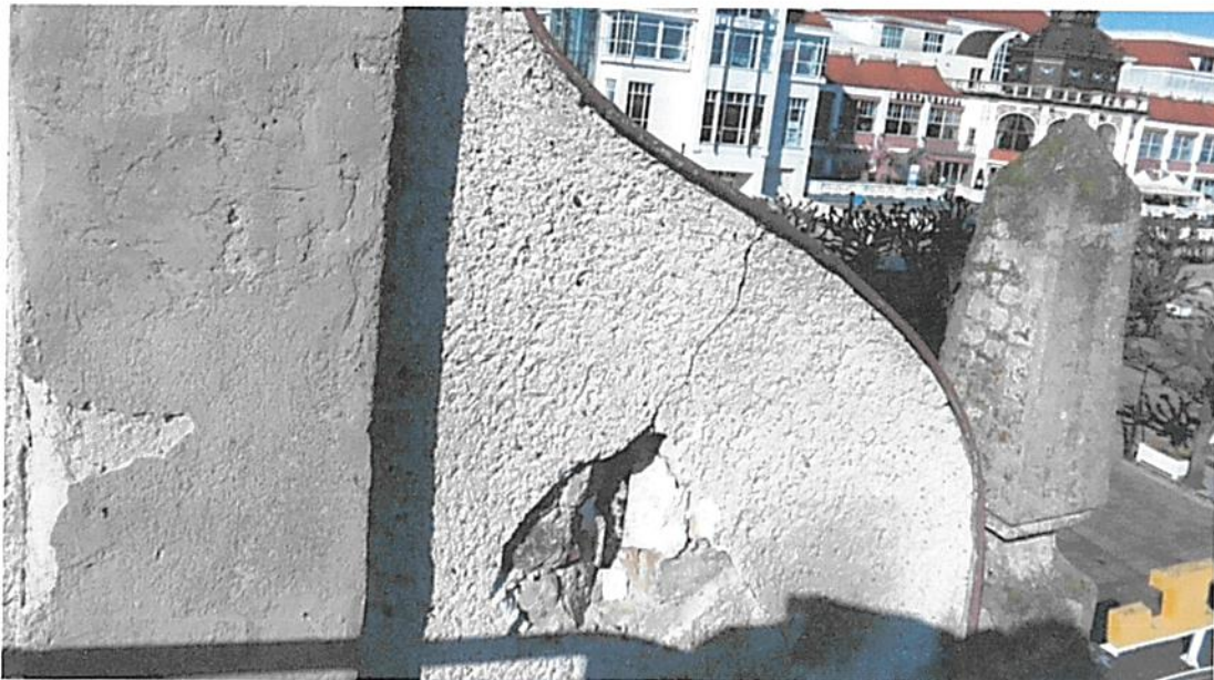
Fot 12 Skorodowane łączniki mechaniczne
