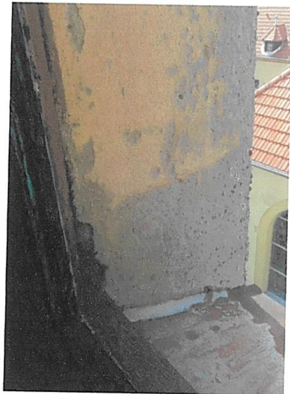
Fot 44 Uzupełnienia tynku przy parapecie
