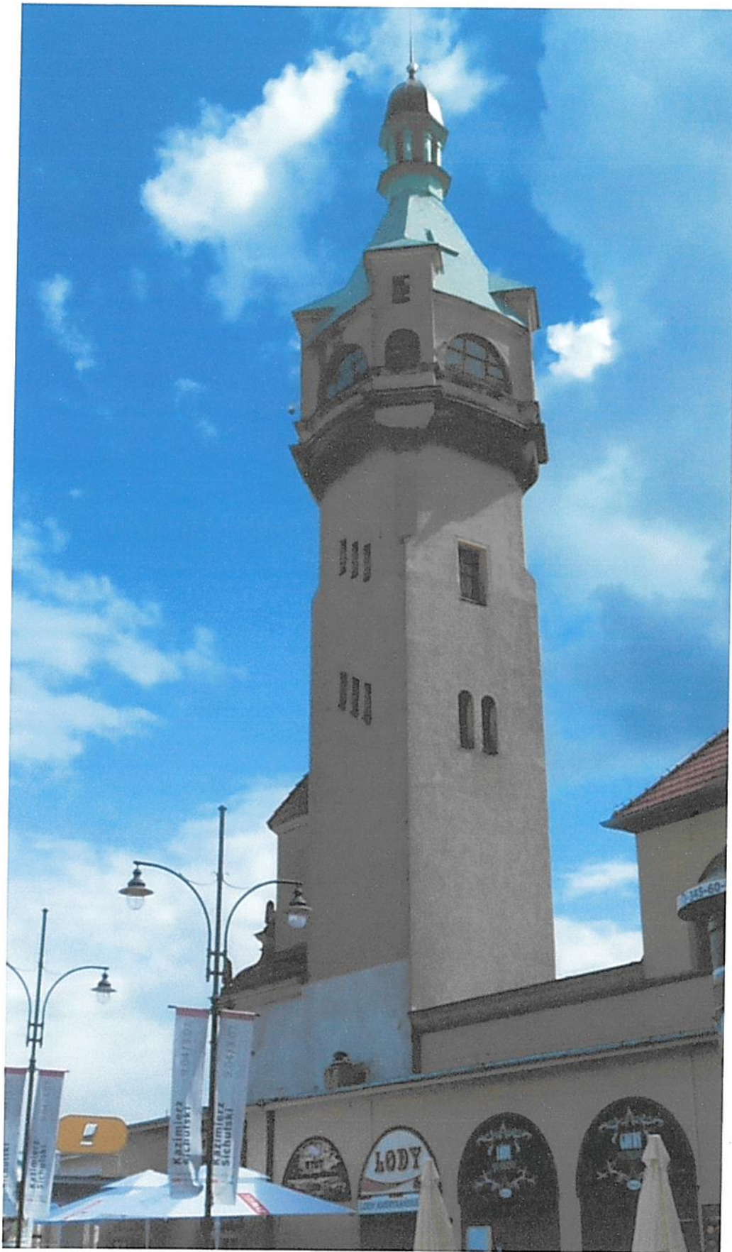
Fot 2 Fasada pn-wsch, widok ogólny – widoczna współczesna przebudowa
