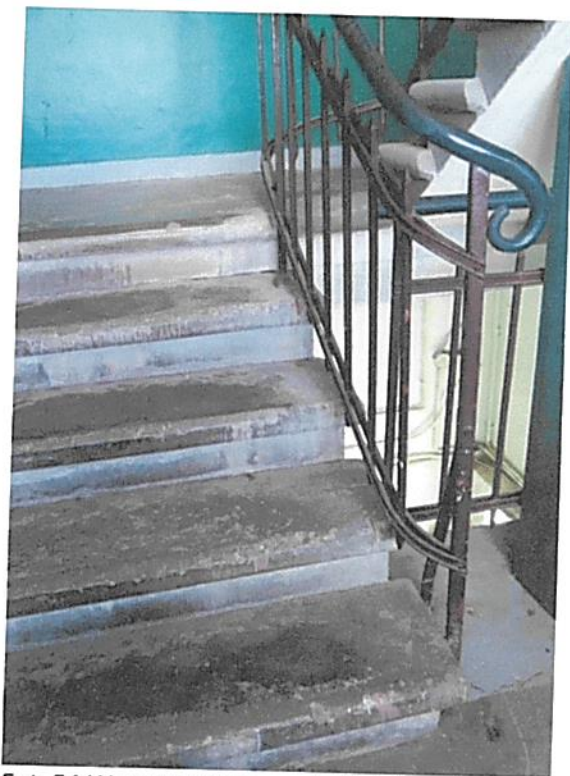
Fot 54 Wnętrze wieży – schody i historyczna poręcz
