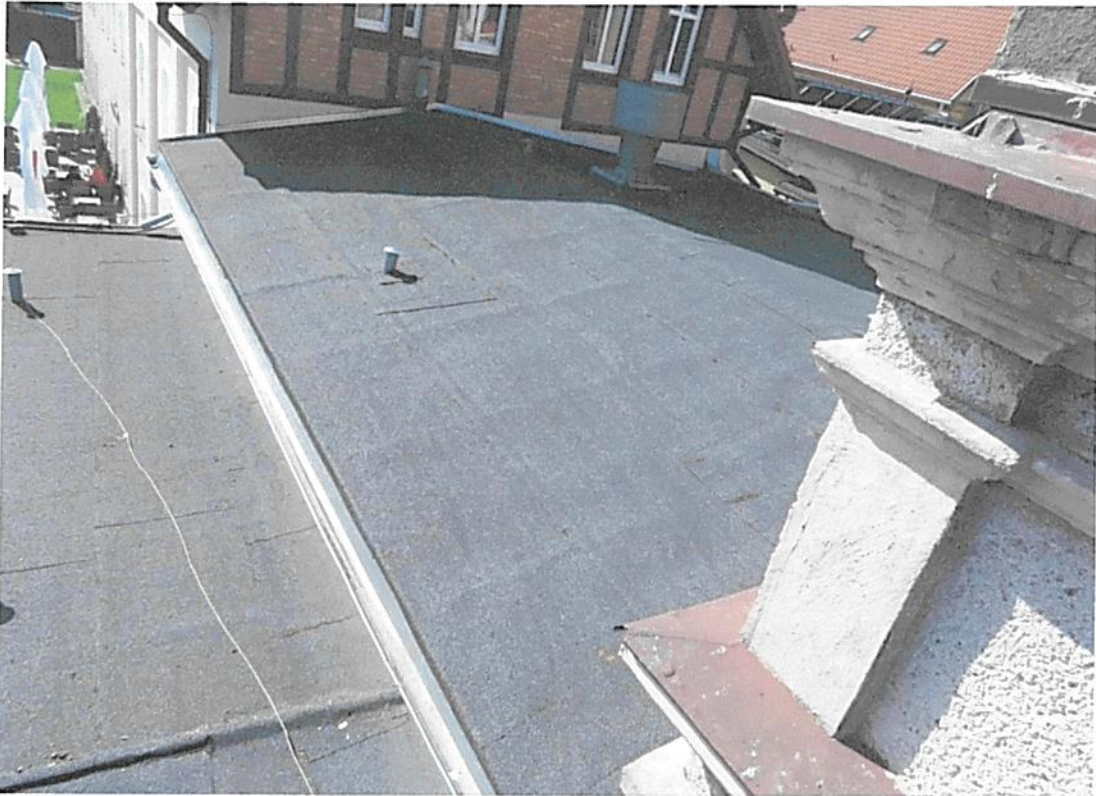
Fot 33 Miejsce pierwotnego tarasu
