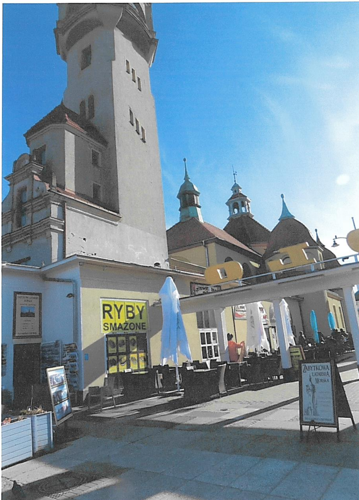
Fot 3 Fasada pn-wsch, widok ogólny – widoczna współczesna przebudowa
