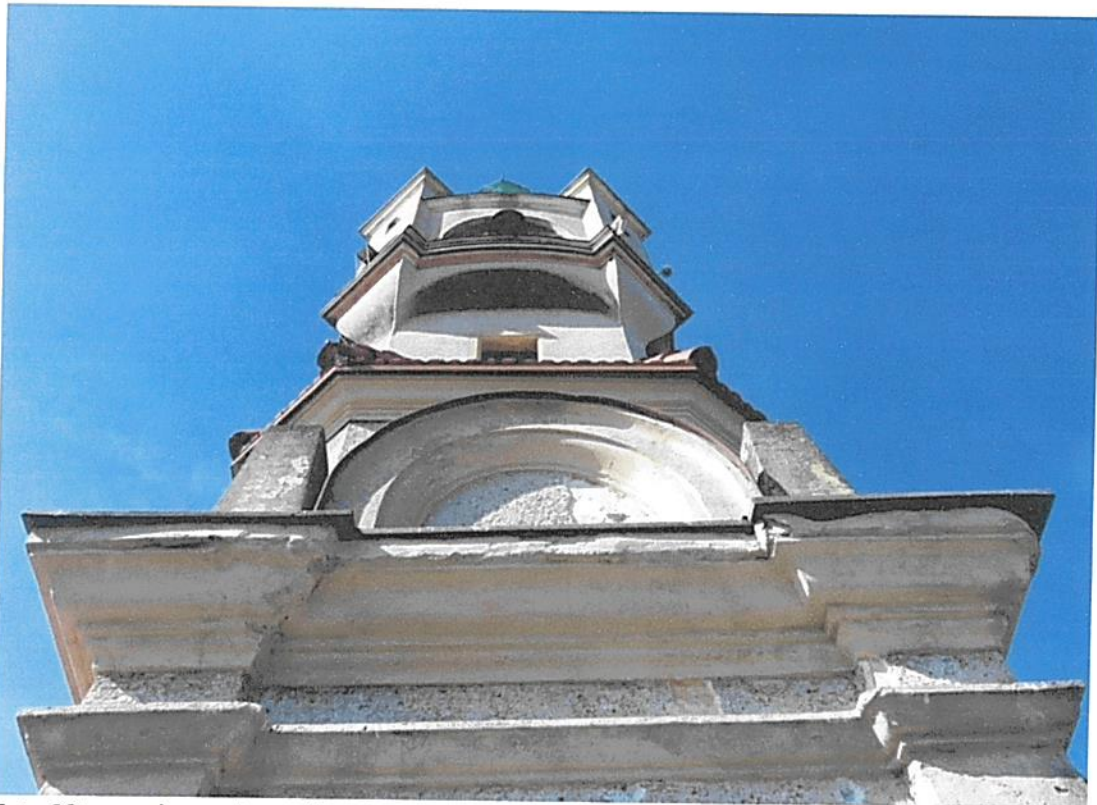
Fot 8 Stan zachowania sztukaterii na ozdobnym szczycie
