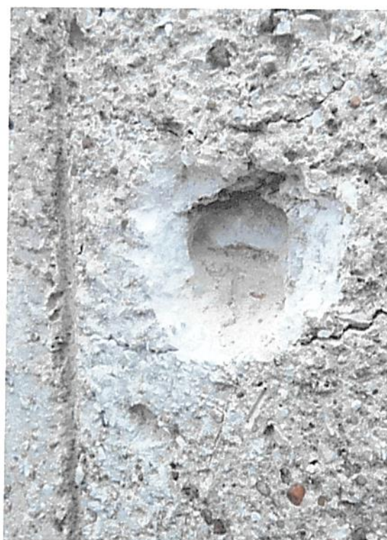
Fot 105 Trzon wieży – widoczna jedna warstwa tynku współczesnego
