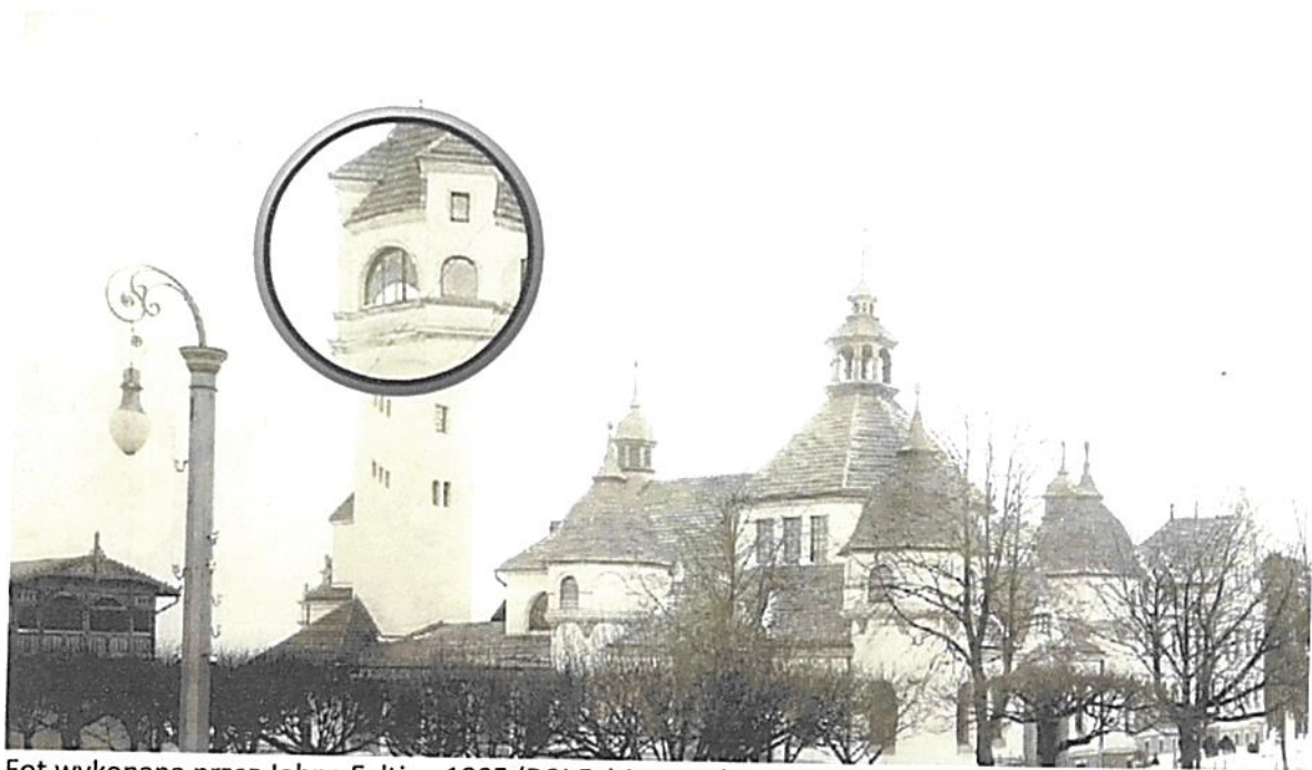
Fot wykonana przez Johna Faltina 1905 (DSJ.Faltin 1905) Detal okno
