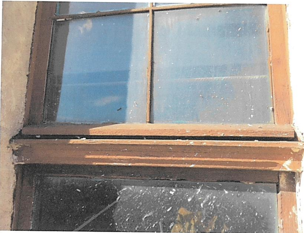
Fot 109 Detal okna – profilowe ślemię
