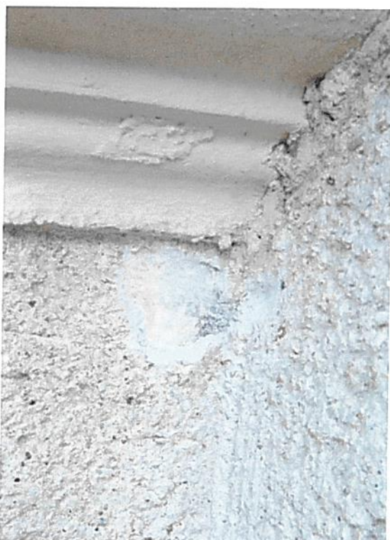
Fot 104 Wykusz wschodni Gładki tynk autorski
