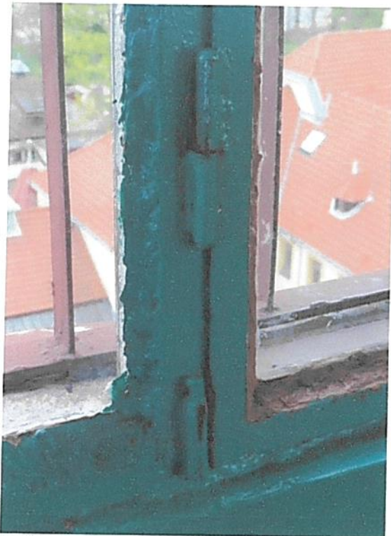
Fot 85 Przebudowy mechanizmów zamykających
