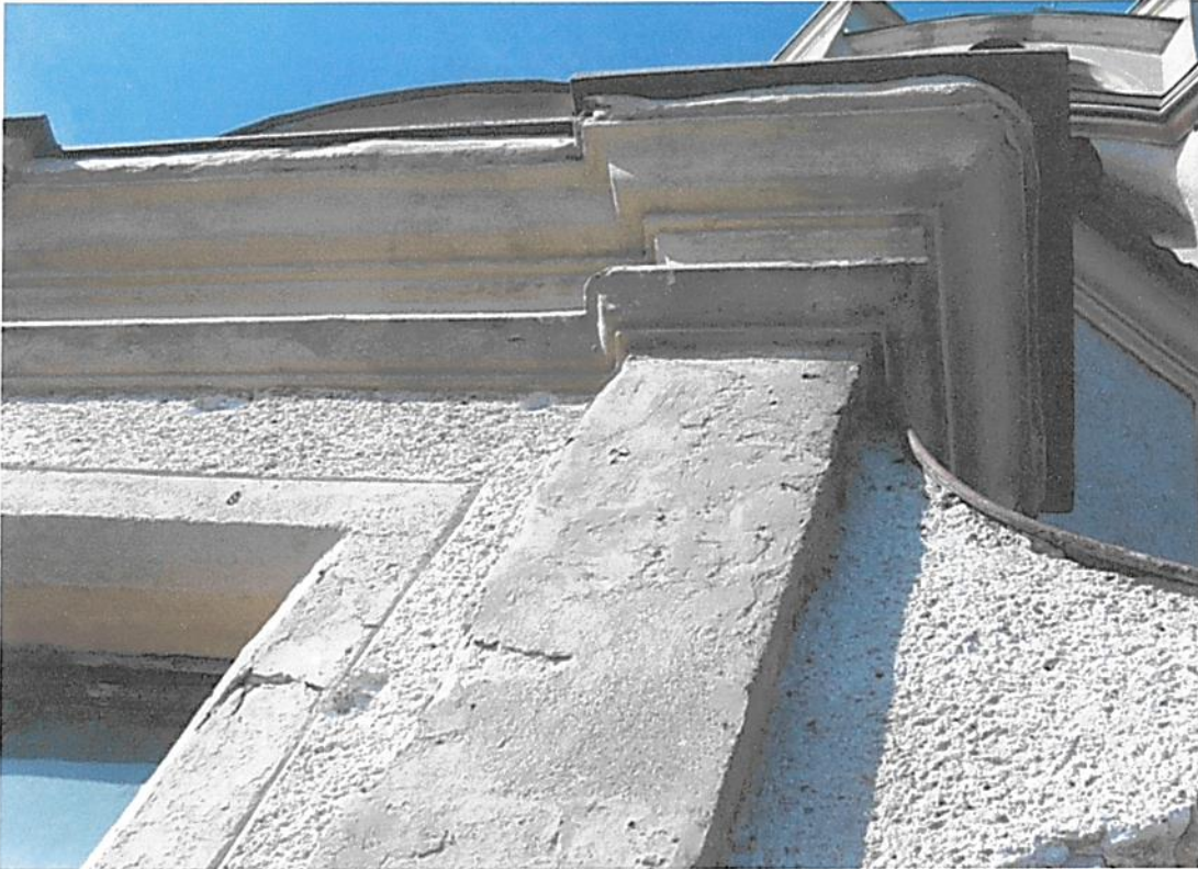
Fot 25 Stan zachowania sztukaterii - zmiana kształtu profili
