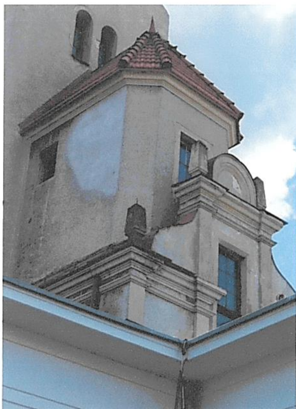
Fot 5 Lokalne naprawy tynku na ścianie wieży
