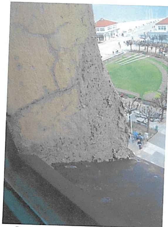
Fot 48 Nieudolne naprawy detalu sztukatorskiego( glify)
