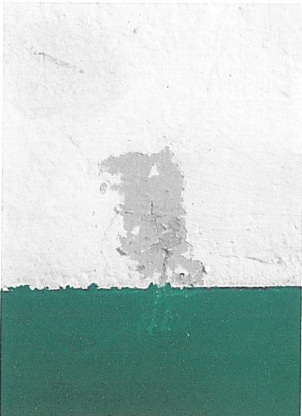
Fot 126 Klatka schodowa latarnia – ściana kolor jasnozielony
