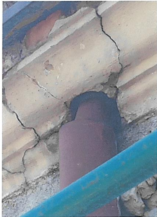
Fot 20 Stan zachowania sztukaterii błędy w odprowadzeniu wody
