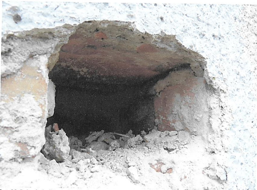
Fot 98 Gniazdo belki więźby dachowej nieistniejącego dachu
