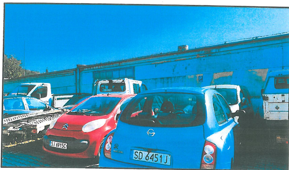
FOT. NR 5 ELEWACJA PÓŁNOCNO-ZACHODNIA
