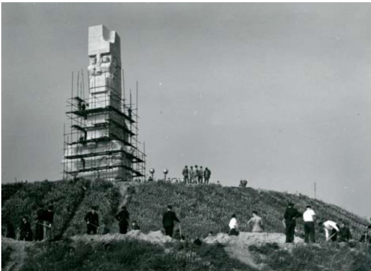
Budowa Pomnika Obrońców Wybrzeża, 1966 (Archiwum MMW)
