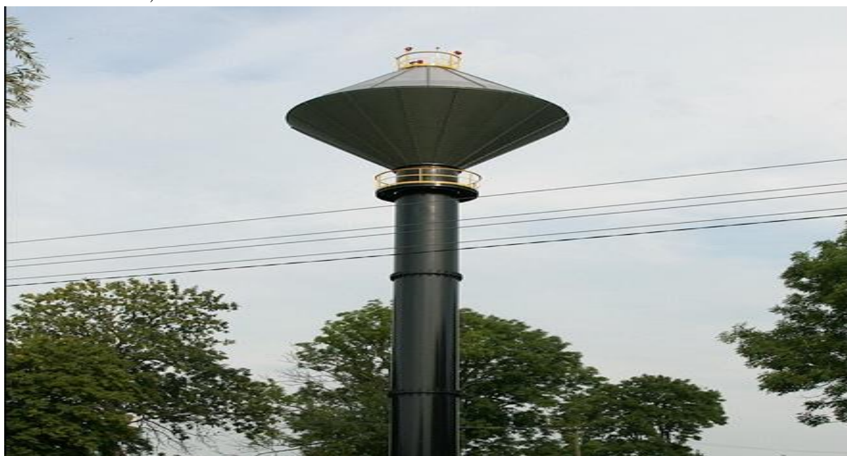
4.3 WIEŻA CIŚNIENÍ , Teren nieogrodzony, nieoświetlony. Konstrukcja stalowa. Brak dewastacji.
